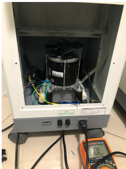
Ilustración 7. Revisión de conexión y pruebas de continuidad en cables de conexión del transformador de voltaje instalado en el succionador.
