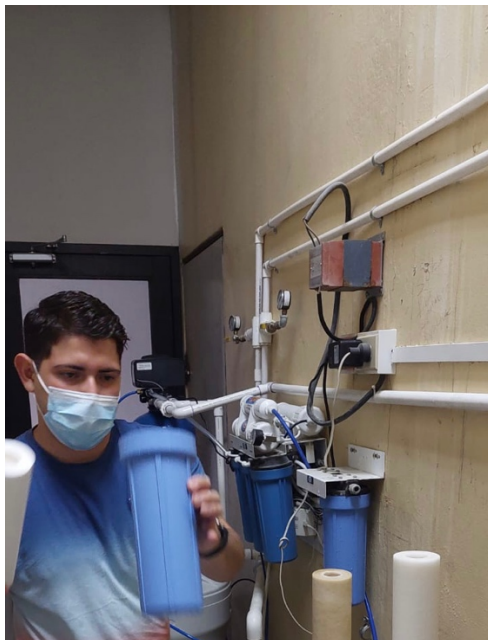
Ilustración 17: Cambio de Filtros de agua para uso de Esterilizador
