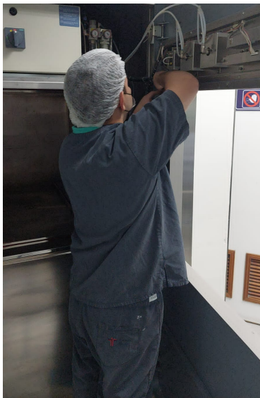
Ilustración 40: Cambio de batería en esterilizador de vapor
