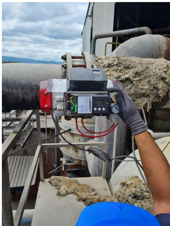
**Ilustración 11. Posicionador de válvula tanque de miel clara**
