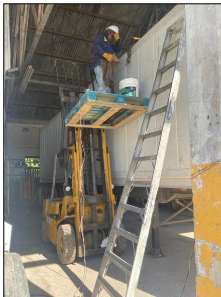
Ilustración 25. Operario realizando el mantenimiento de contenedores
