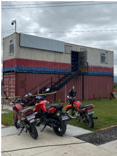
Ilustración 39. Contenedores adaptados para oficina en la carretera CA-5, salida al Norte.
