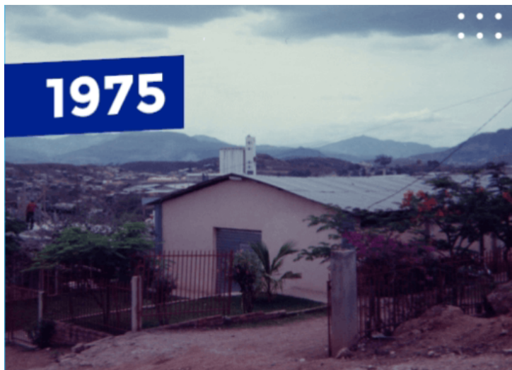
Imagen 2 Primera instalación propia de Laboratorios Andifar. Imagen tomada de la web 2022
