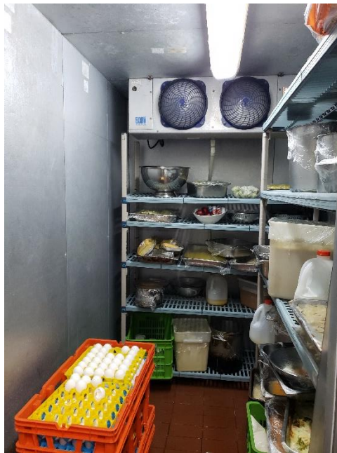
Ilustración 6 Cuarto Frío de Cocina General
