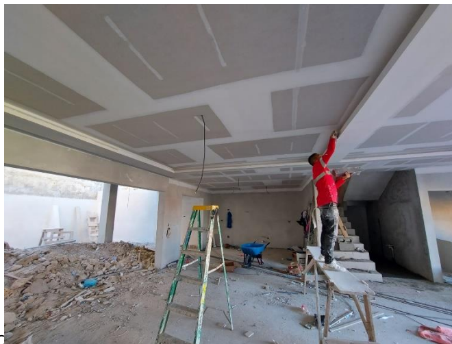
Ilustración 107 Acabados de masilla para tabla yeso
