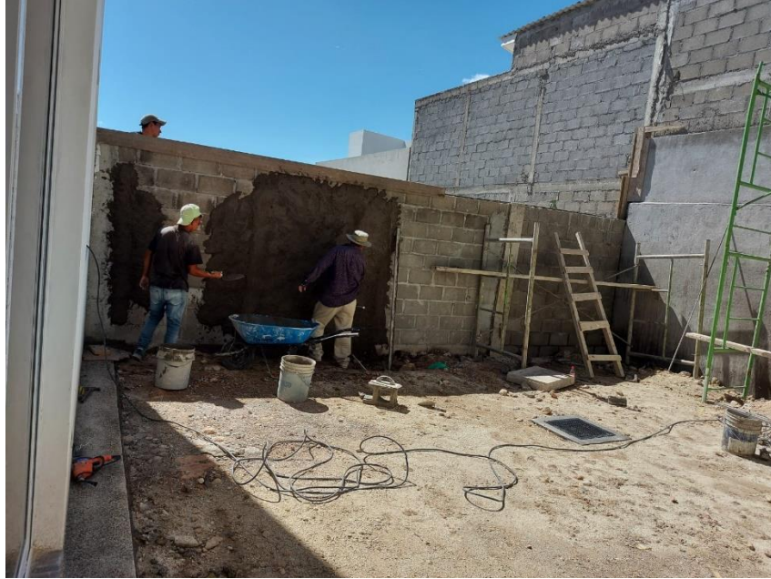
Ilustración 78 Repello pared lateral interior Cipreses #20
