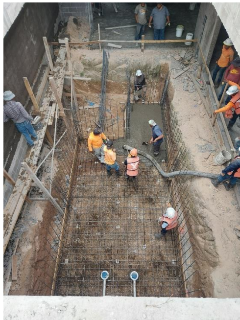
Ilustración 124 Fundición firme de concreto para piscina
