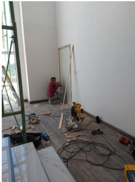
Ilustración 47 Colocación puerta principal
