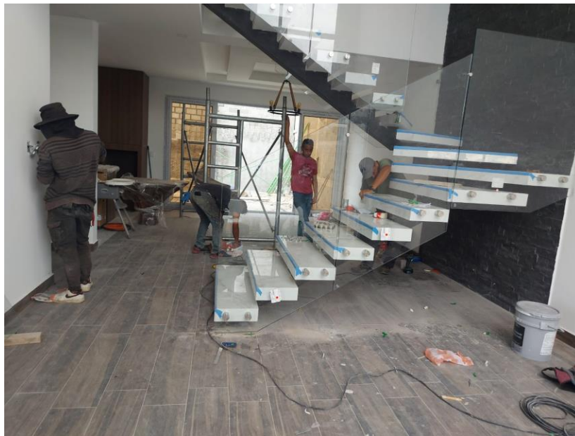
Ilustración 67 Finalizado de colocación vidrio templado
