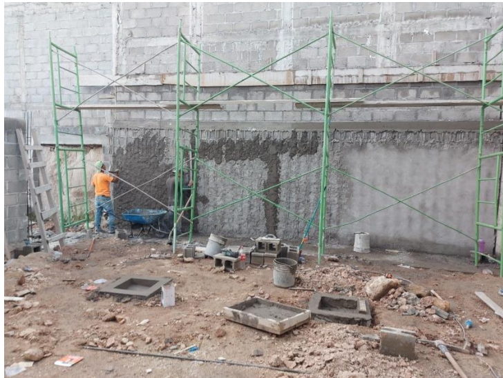
Ilustración 71 Repello muro de contención
