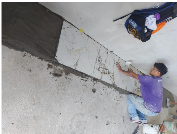
Ilustración 120 Pegado de cerámica cuarto principal
