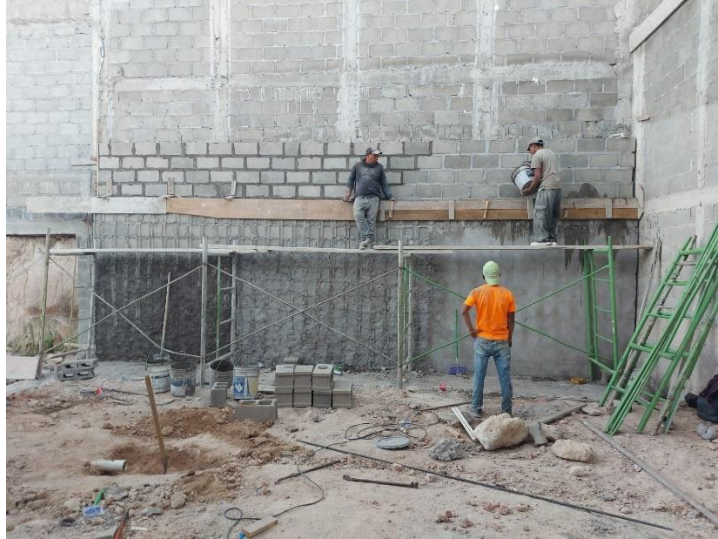
Ilustración 70 Encofrado de solera
