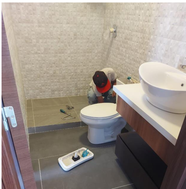
Ilustración 99 Reparación baño vivienda Villa los Cipreses, lote # 20
