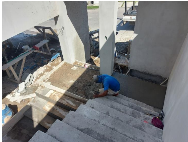
Ilustración 122 Fundición firme de concreto gradas exteriores
