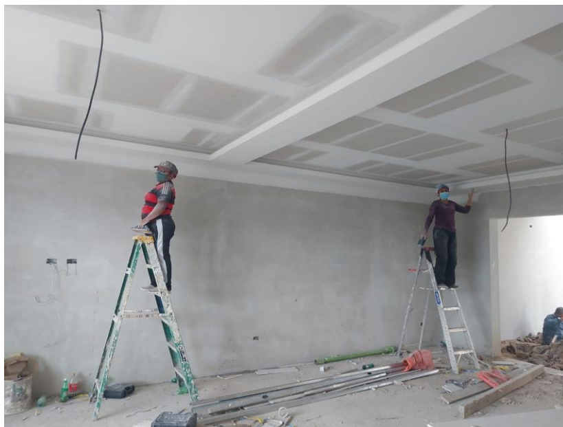
Ilustración 116 Empastado de tablayeso primer nivel
