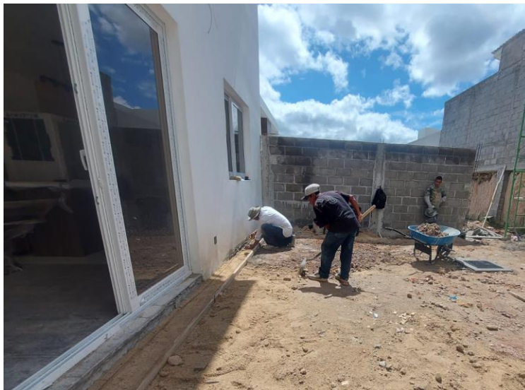
Ilustración 73 Encofrado de acera
