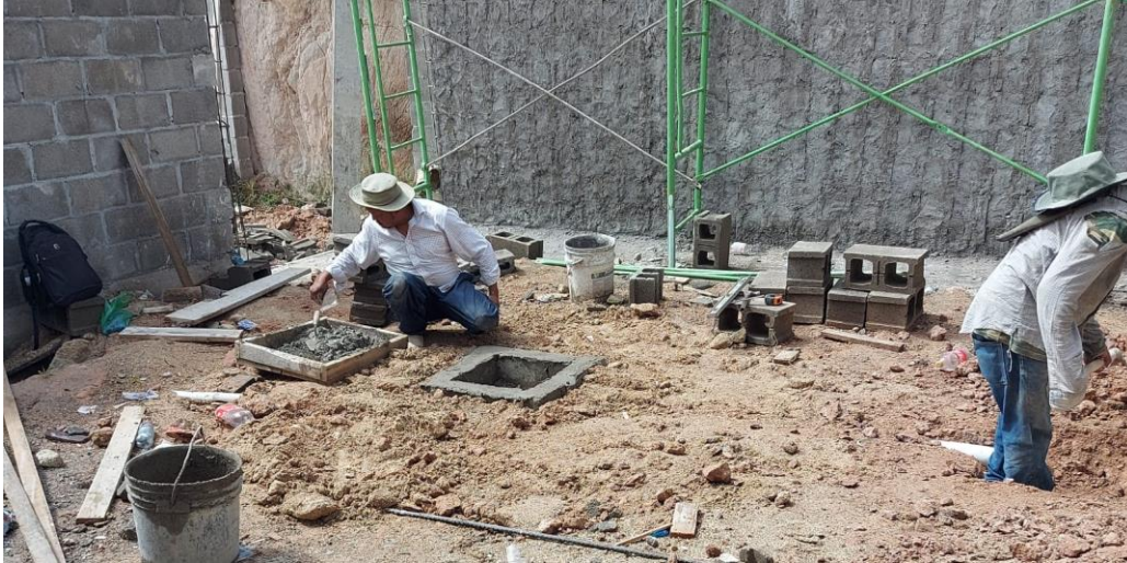
Ilustración 72 Cajas para aguas lluvias
