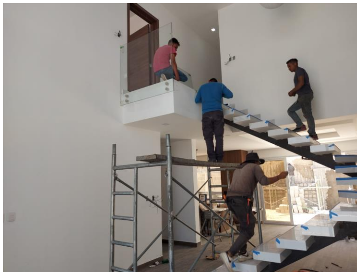
Ilustración 65 Colocación vidrio templado en gradas
