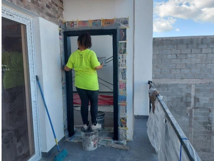
Ilustración 60 Colocación de puerta principal
