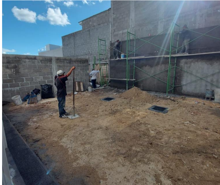
Ilustración 76 Compactación material de relleno utilizando apisonador manual
