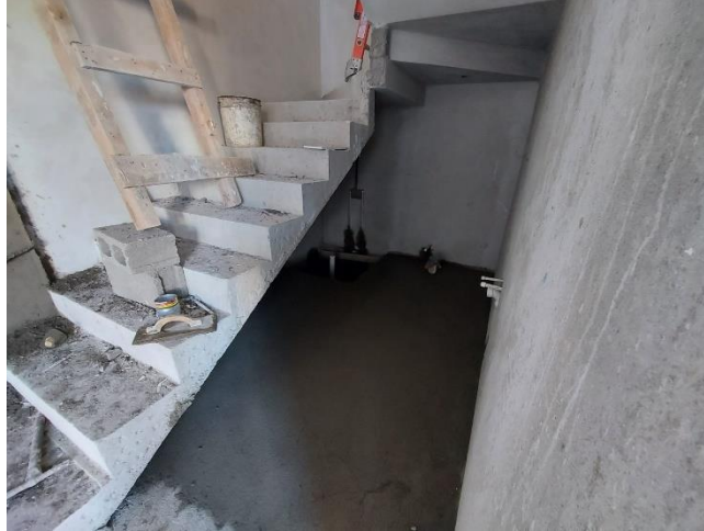
Ilustración 111 Fundición firme de concreto
