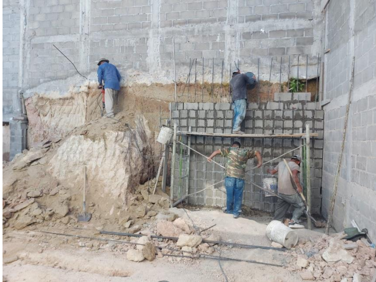
Ilustración 50 Finalizado primera mitad del muro de contención
