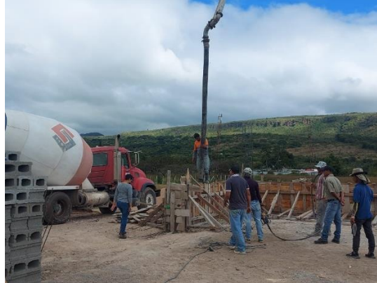
Ilustración 104 Fundición de tensoras
