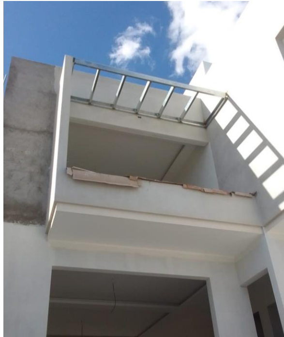
Ilustración 135 Armado de techo para balcón
