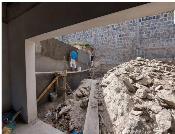
Ilustración 108 Repello paredes posteriores vivienda villa los Naranjos
