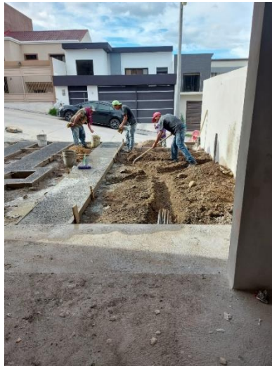
Ilustración 41 Supervisión acabado de grava
