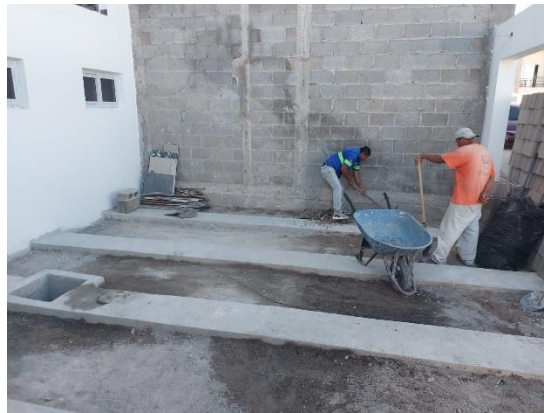
Ilustración 59 Limpieza parte frontal de la vivienda
