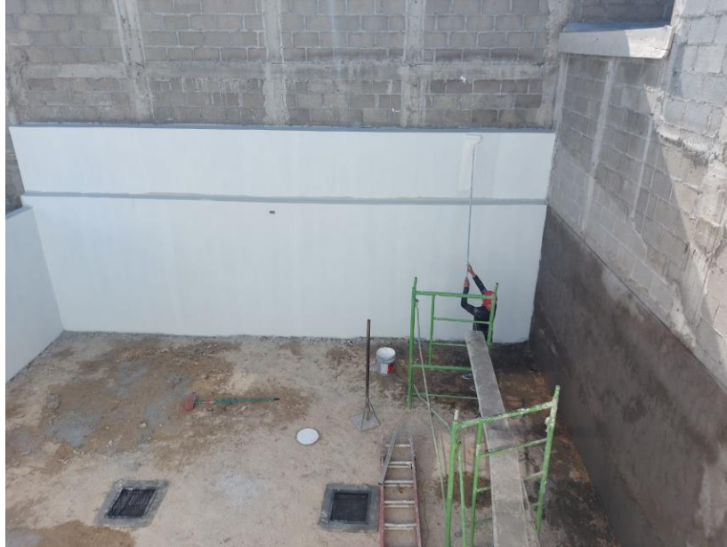
Ilustración 88 Pintado de muro parte posterior Villa los Cipreses #20
