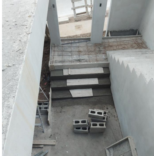
Ilustración 121 fundición gradas exteriores
