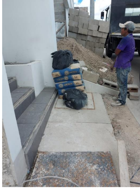
Ilustración 46 Bloques de 8" y cemento solicitado
