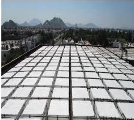
Ilustración 26 Losas aligeradas
