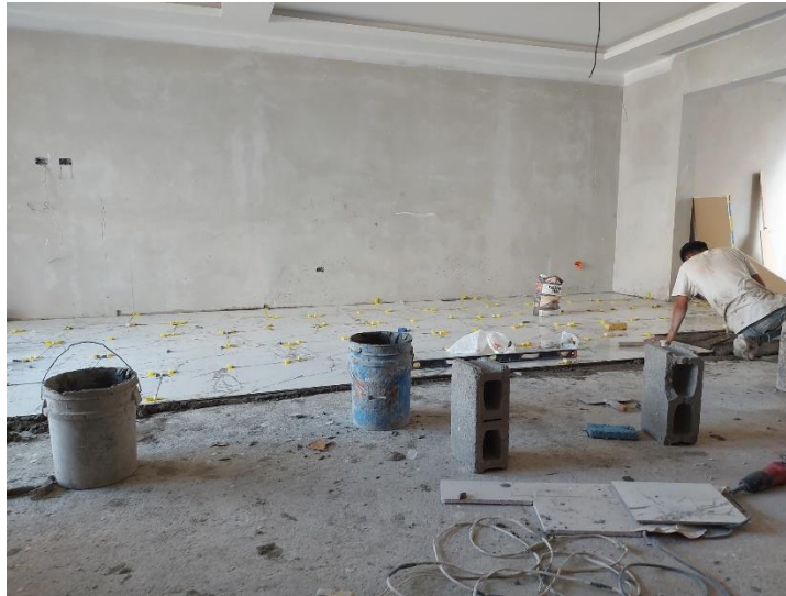
Ilustración 126 Pegado de cerámica primer nivel
