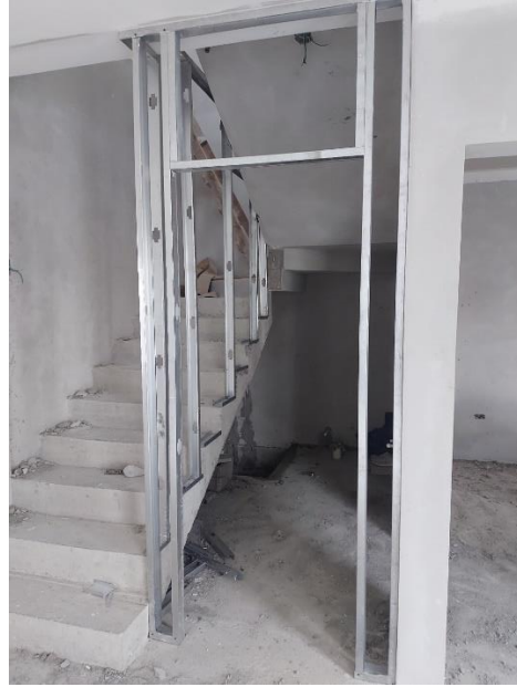
Ilustración 123 Armado de pared de tabla yeso
