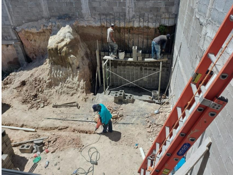
Ilustración 52 Colocación tubería de 3"
