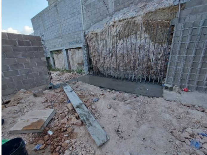
Ilustración 62 Zapata Corrida
