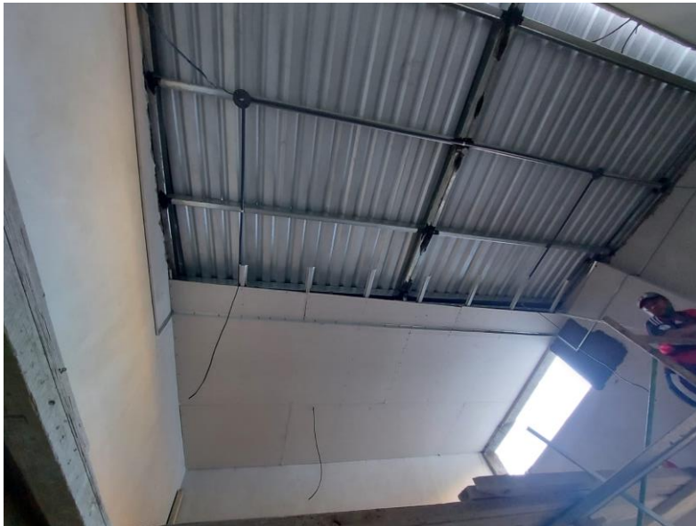
Ilustración 113 Detalle tablayeso en cubo de gradas
