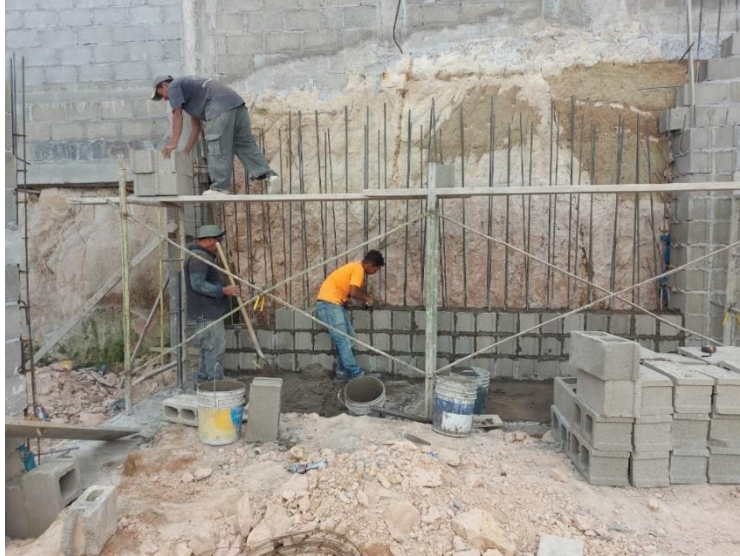
Ilustración 64 Pegado bloque de 8" muro de contención
