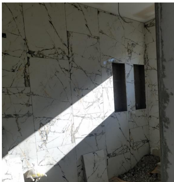
Ilustración 134 Enchape de baño principal
