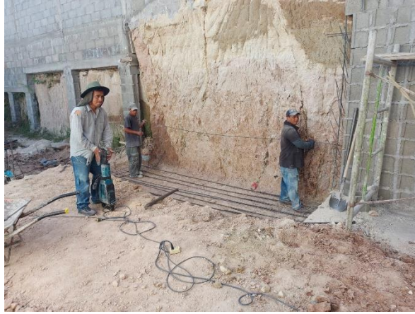
Ilustración 56 Armado acero de refuerzo para Zapata corrida
