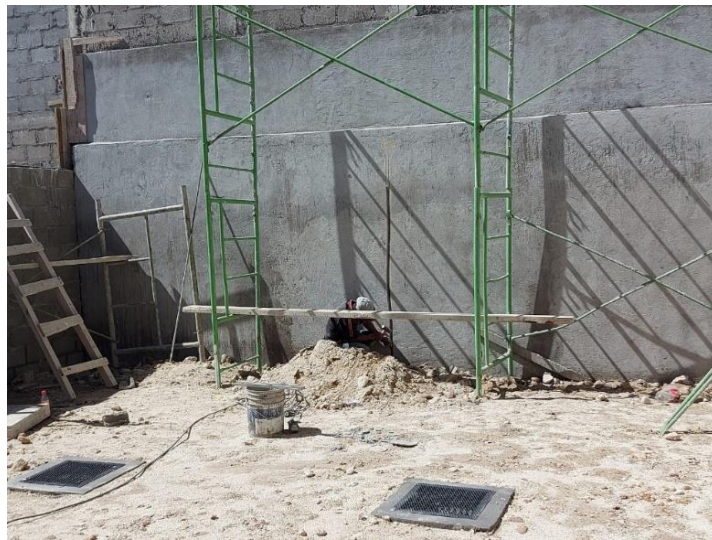
Ilustración 79 Ranura para ducto eléctrico Villa los Cipreses, lote # 20
