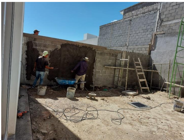
Ilustración 86 Repello pared lateral Vivienda Villa los Cipreses, lote # 20
