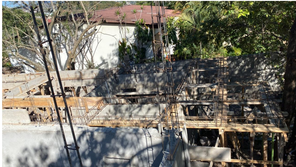
Ilustración 129 Armado de refuerzo para vigas
