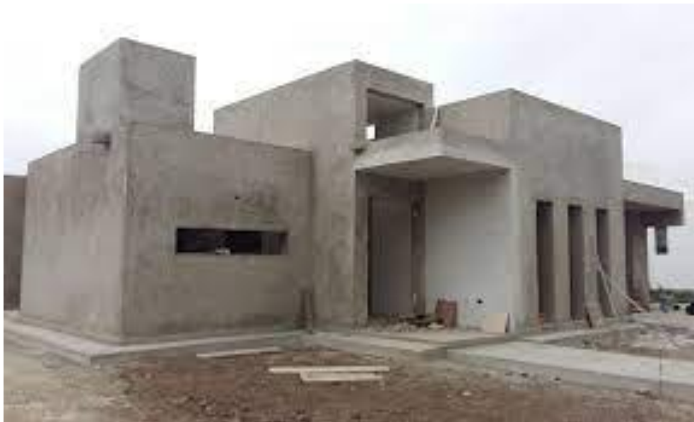
Ilustración 17 Estructura de concreto
