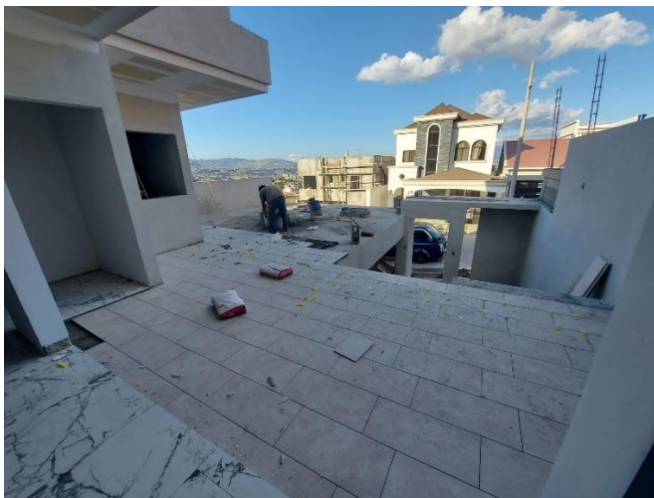
Ilustración 133 Pegado de cerámica en losa
