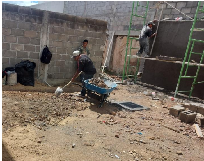
Ilustración 75 Colocación material de relleno
