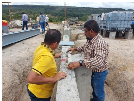
Ilustración 106 Marcaje de ejes para placas metálicas
