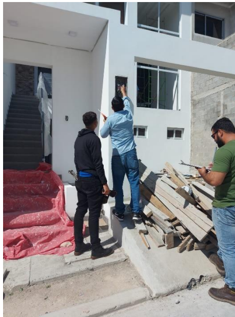
Ilustración 57 Colocación contador de energía
