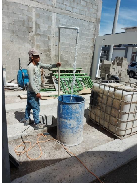
Ilustración 66 Vaciado de cisterna
