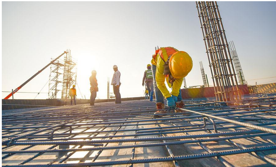
Ilustración 25 Armado de refuerzo para losas
