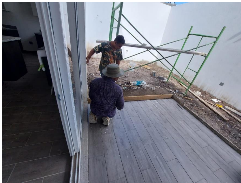
Ilustración 89 Encofrado para fundición de bordillo Villa los Naranjos, lote # 07
