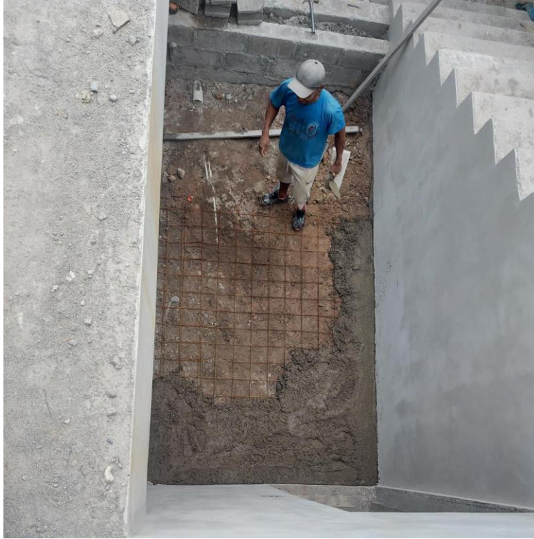
Ilustración 115 Fundición de firme de concreto vivienda Villa los Naranjos, lote # 10
