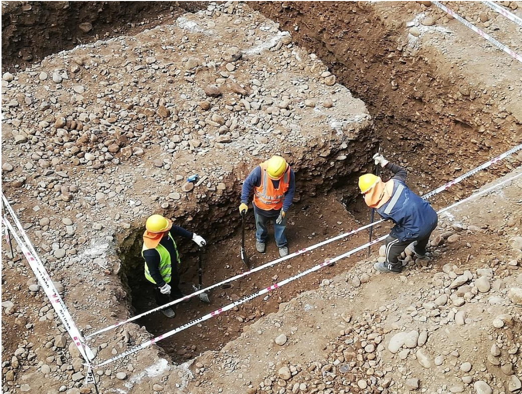
Ilustración 19 Excavaciones para fundiciones
