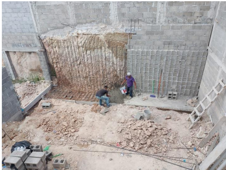
Ilustración 61 Fundición zapata corrida
