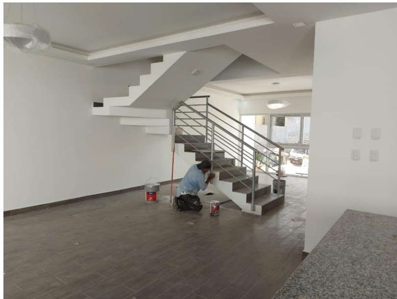
Ilustración 91 Colocación de masilla para acabados de pintura Villa los Naranjos, lote # 07
