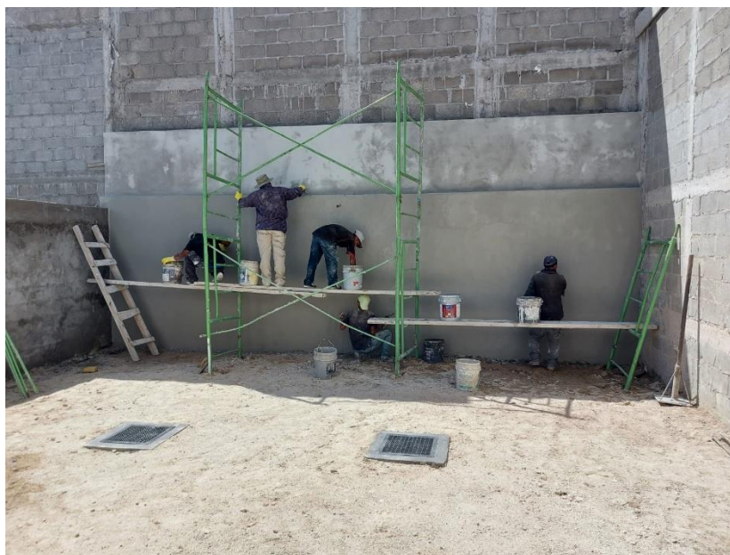
Ilustración 82 Pulido parte inferior muro de contención Villa los Cipreses, lote # 20
