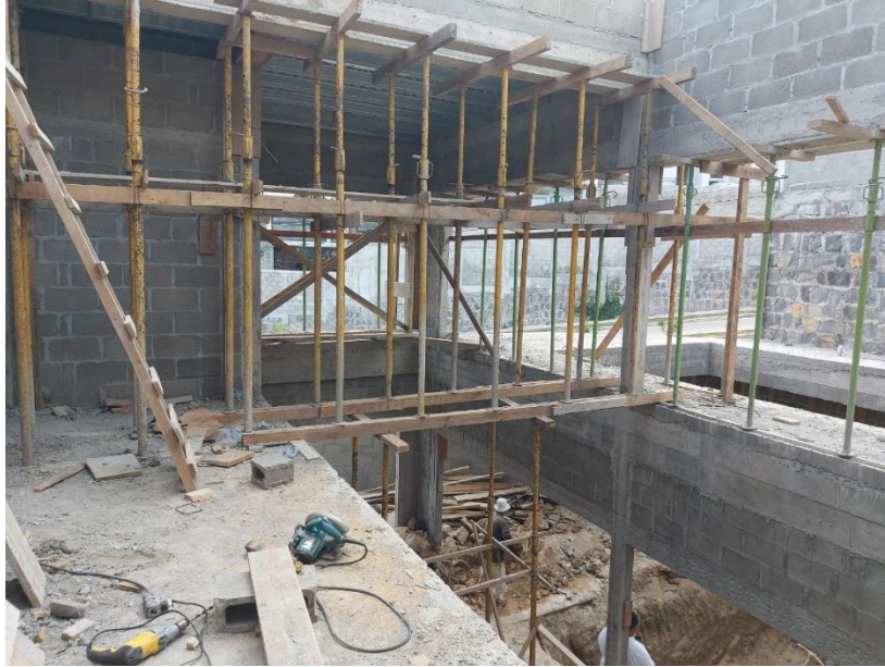
Ilustración 98 Encofrado para viga Villa los Naranjos, lote # 17
