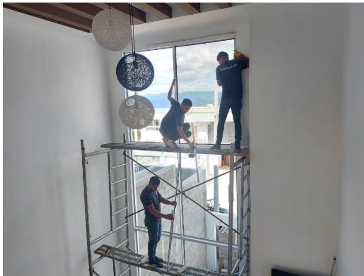
Ilustración 63 Colocación vidrio templado
