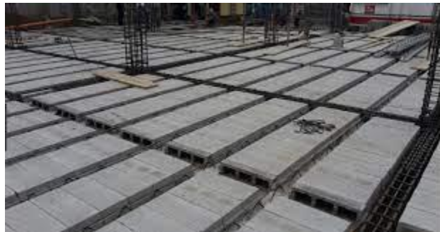
Ilustración 27 Losas prefabricadas
