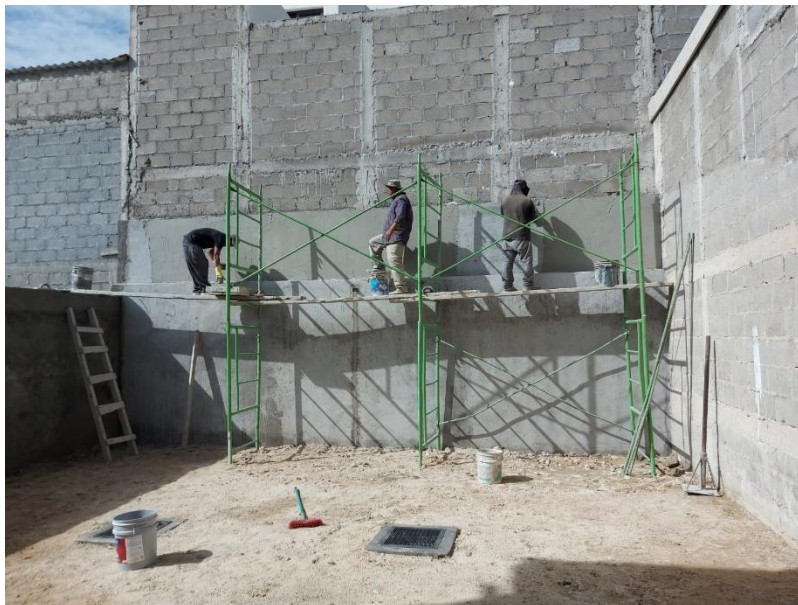
Ilustración 81 Pulido parte superior muro de contención Cipreses #20
