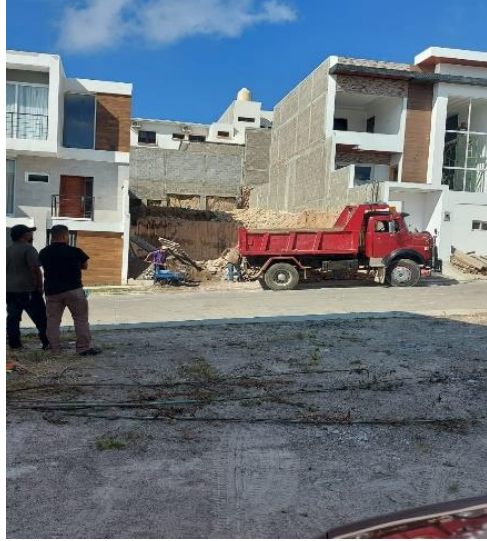
Ilustración 58 Acarreo de desperdicio
