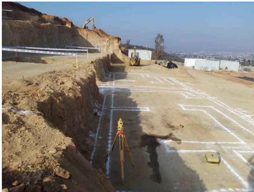
Ilustración 18 Trazado y marcado de terreno
