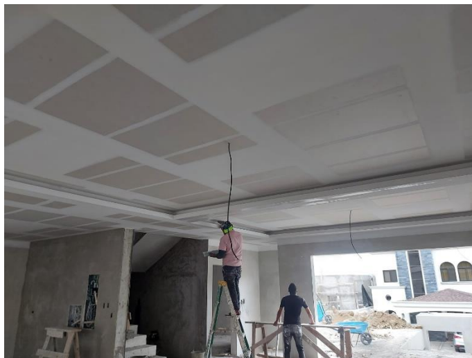
Ilustración 114 Lijado de tablayeso primer nivel
