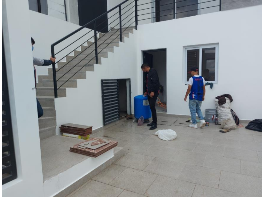
Ilustración 96 Verificación de presiones en tuberías, Villa los Naranjos, lote # 07
