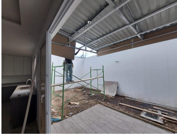
Ilustración 92 Colocación tabla yeso en área social, Villa los Naranjos # 07
