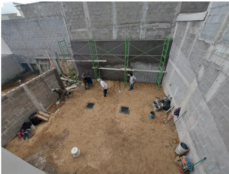
Ilustración 77 Terreno compactado
