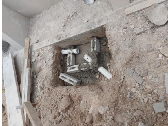
Ilustración 125 Cajas para aguas lluvias
