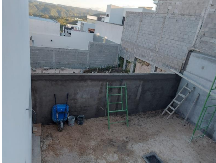
Ilustración 80 Muro lateral repellido Villa los Cipreses, lote # 20
