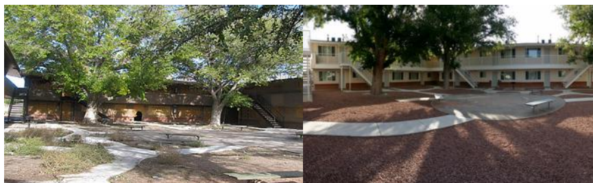
Ilustración 14. Antes y después de mantenimiento.
