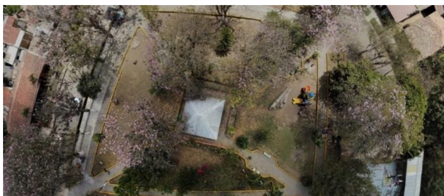
Ilustración 91. Imagen del estado actual del Parque.
