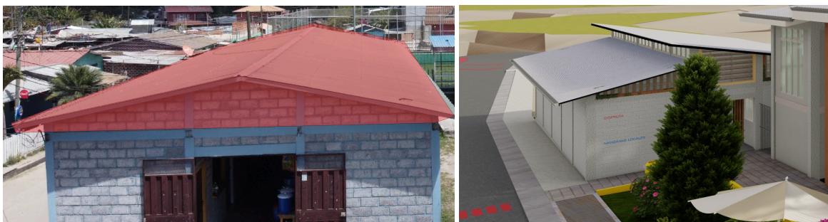
Ilustración 114. Remplazo de techo. Fuente: Elaboración propia.
