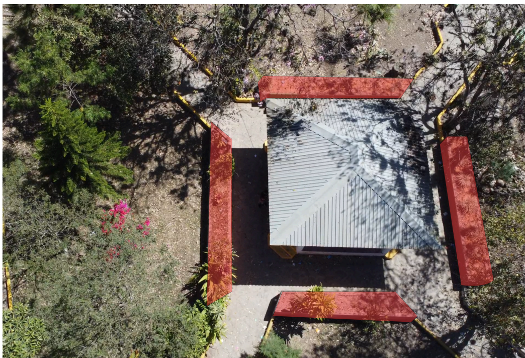
Ilustración 116. Demolición de jardineras en parque. Fuente: Elaboración propia.
