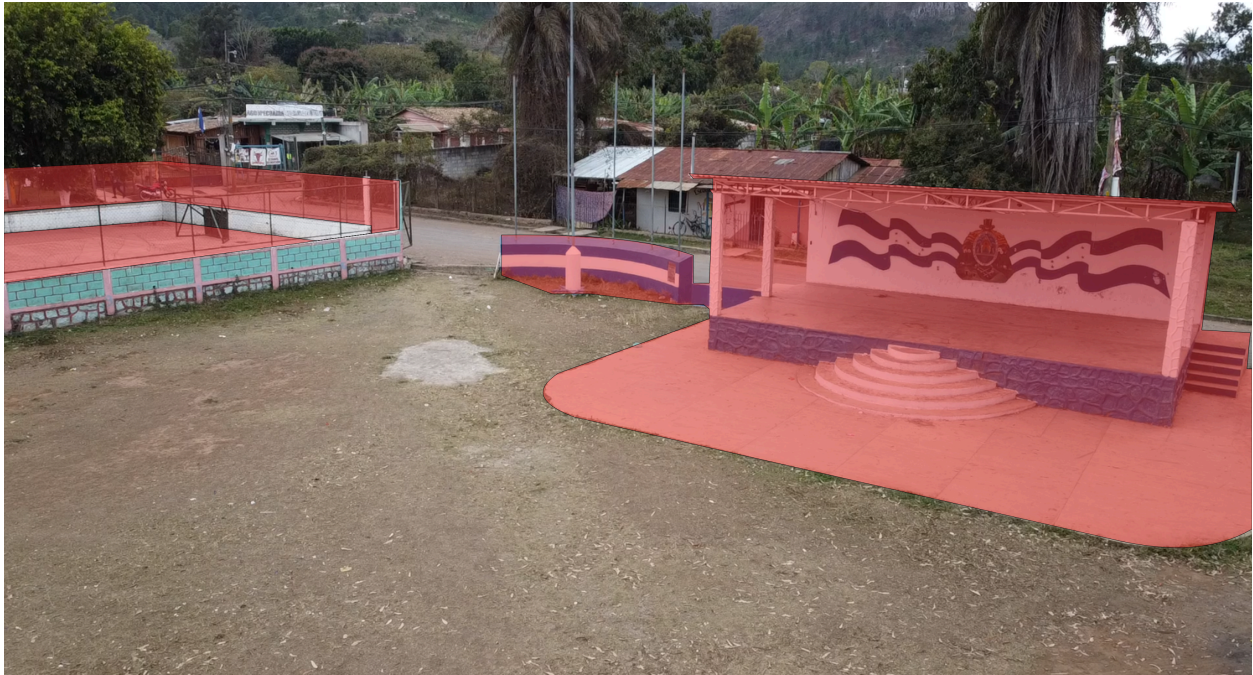
Ilustración 111. Demolición de espacios en Plaza. Fuente: Elaboración propia
