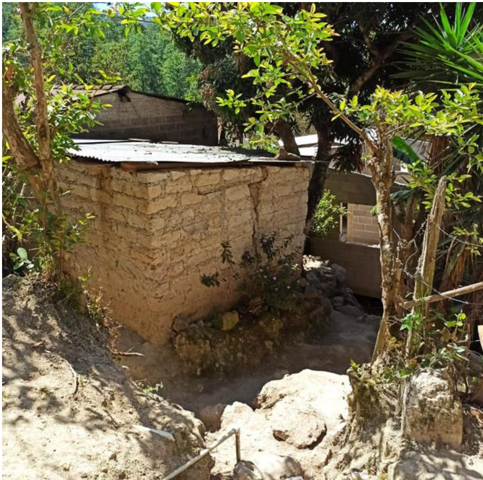
Ilustración 2: Estructura de vivienda, comunidad de Planes el Duraznal
