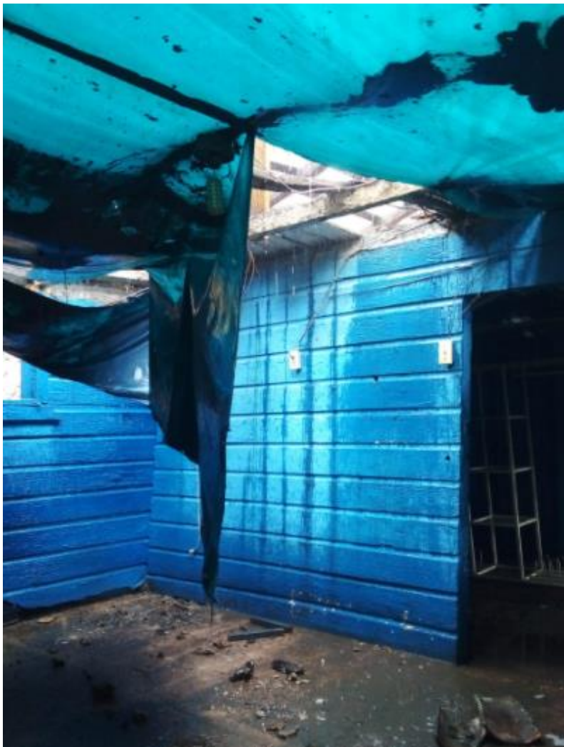
Ilustración 5: Condición de techo
