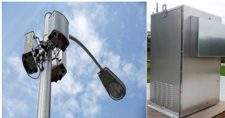
**Ilustración 18. Ejemplo de sistema de antena de células pequeñas y distribuidor situado en la vía pública**
