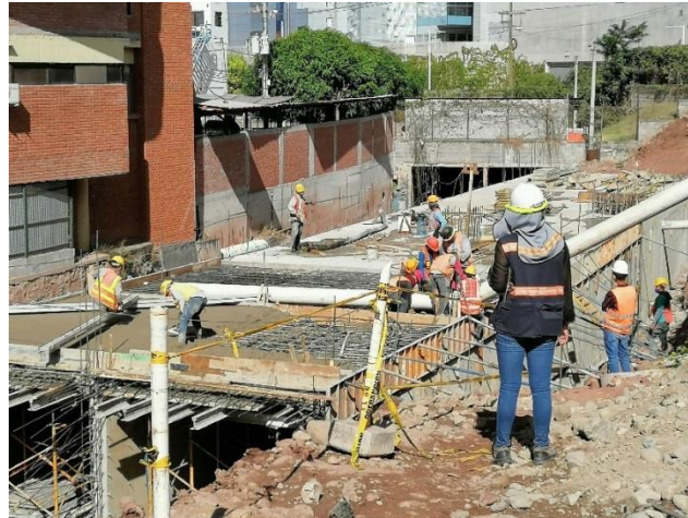
Ilustración 61. Sistema alternativo para vertido del concreto.
