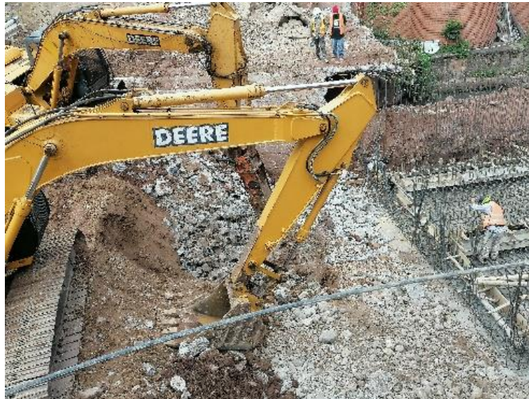
Ilustración 78. Demolición de embaulado existente.
