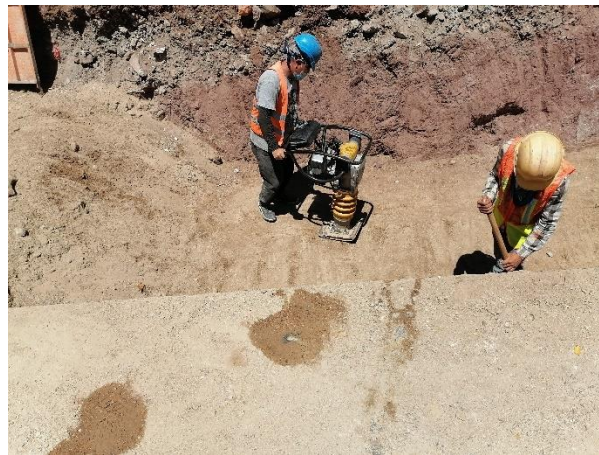
Ilustración 91. Compactación de material selecto.
