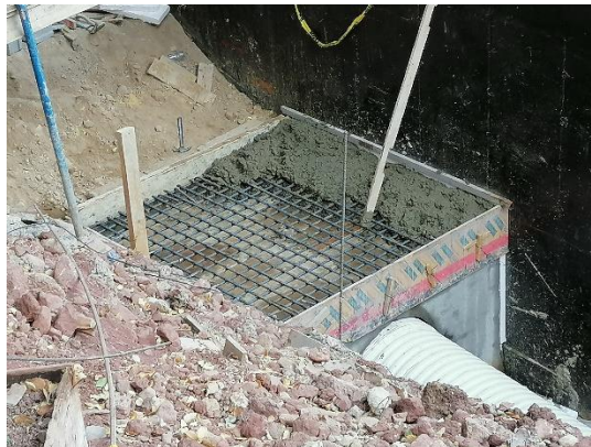
Ilustración 103. Fundición de caja de inspección #21.
