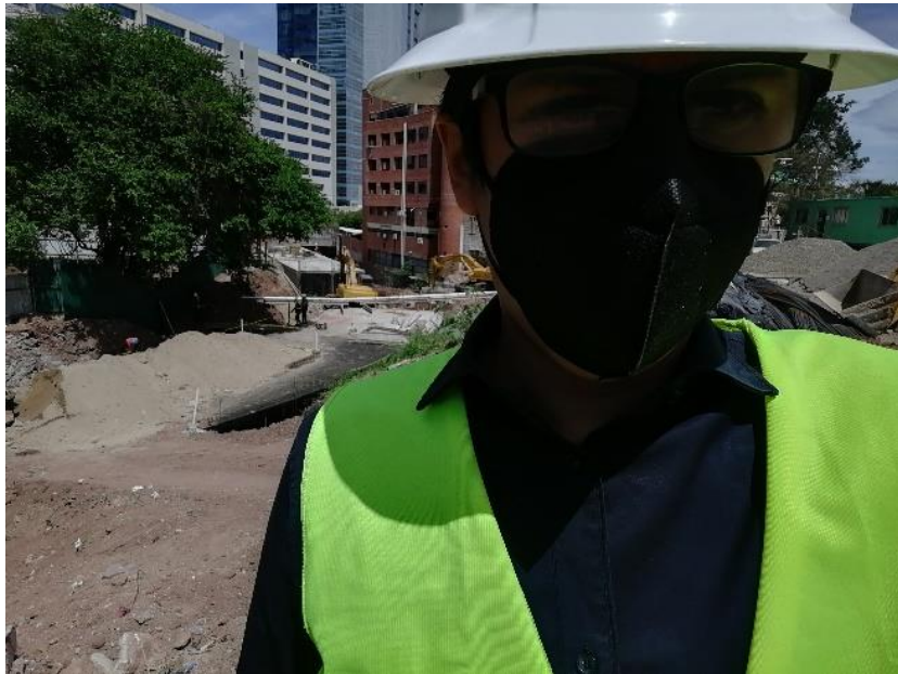
Ilustración 80. Material selecto en la entrada de acceso al embaulado.
