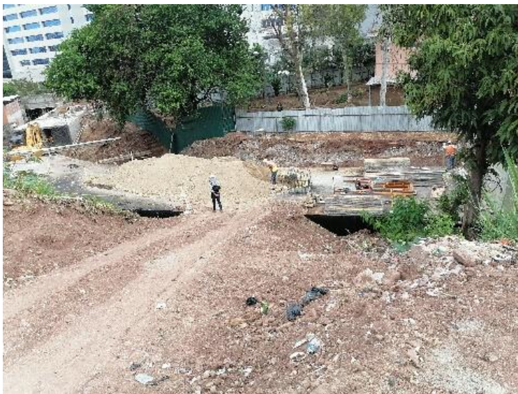
Ilustración 76. Acceso a embaulado.
