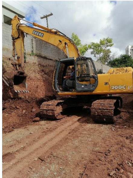
Ilustración 25. Movimiento de material a través de excavadora.
