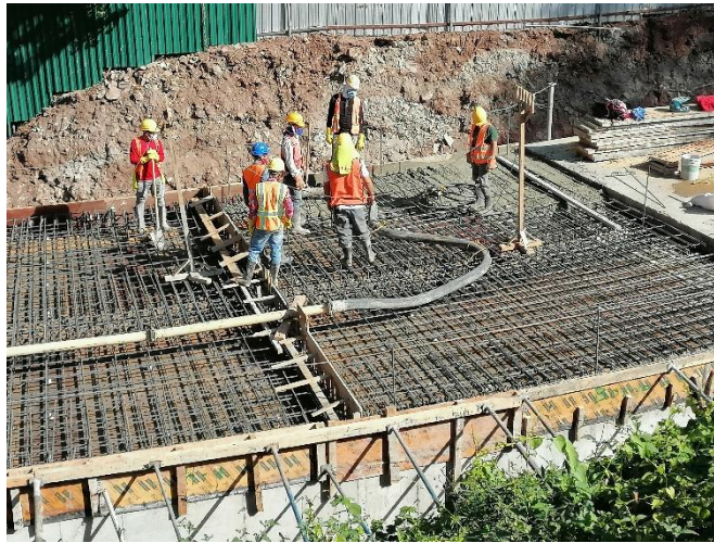
Ilustración 33. Fundición de losa superior de concreto del embaulado.
