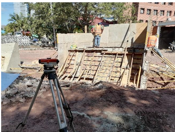
Ilustración 20. Toma de niveles para altura de encofrado.
