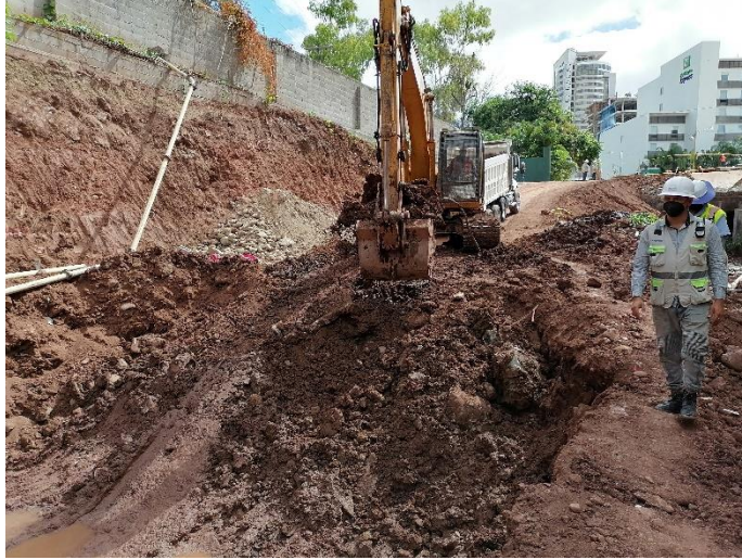
Ilustración 31. Excavación para paso de maquinaria.
