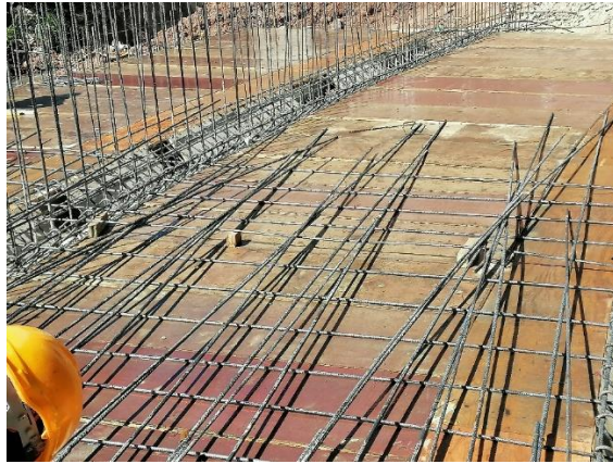
Ilustración 36. Colocación de acero en losa superior.
