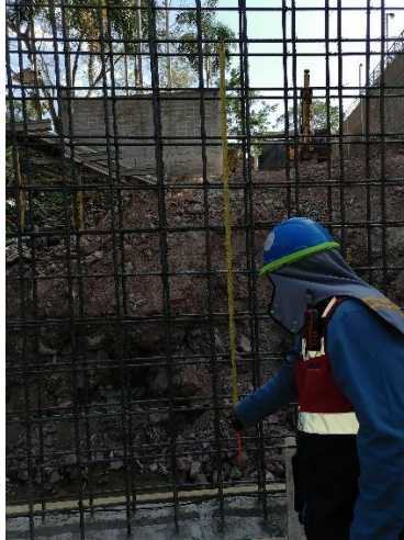
Ilustración 100. Inspección de acero en muros laterales.
