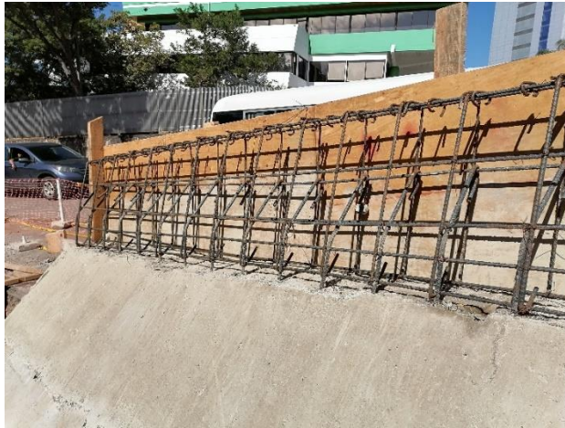
Ilustración 18. Inspección de armado de acero, barrera Jersey.
