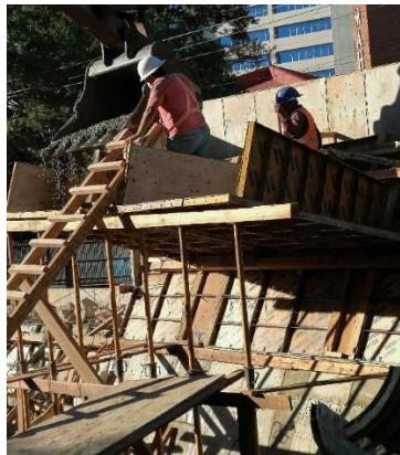
Ilustración 37. Fundición de muros de concreto ciclópeo en lote #1.
