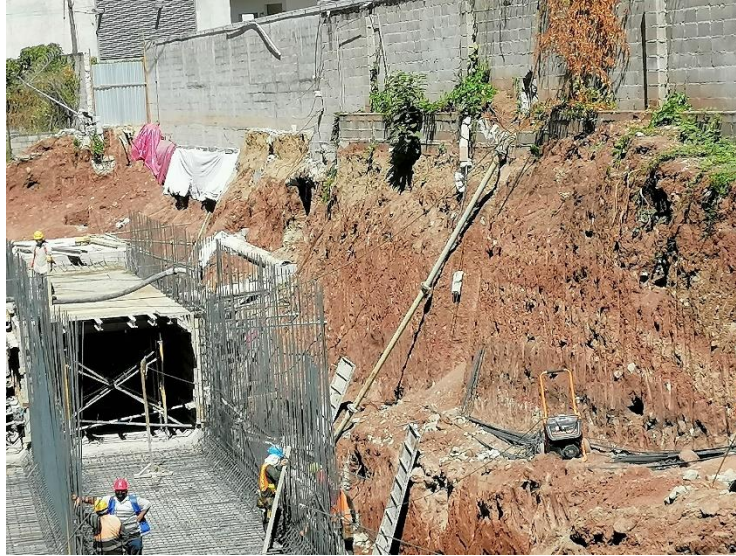
Ilustración 42. Avances en construcción del embaulado.
