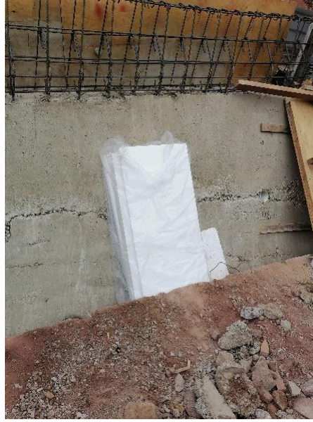
Ilustración 23. Poliestireno extendido para generar juntas de construcción.
