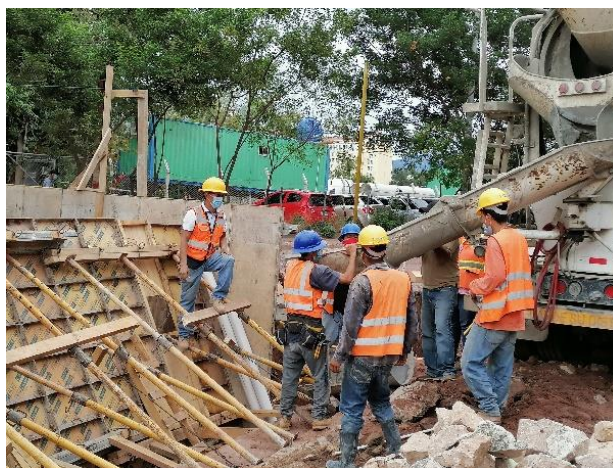
Ilustración 19. Fundición de muro de concreto ciclópeo.
