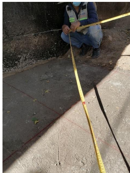
Ilustración 79. Verificación de coordenadas de caja de inspección.
