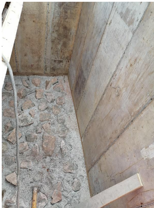
Ilustración 17. Inspección interna del encofrado.
