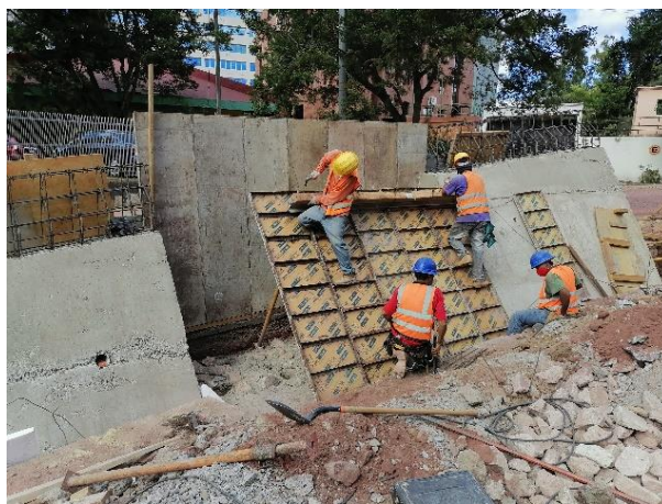
Ilustración 21. Preparación de encofrado para fundición al día siguiente.
