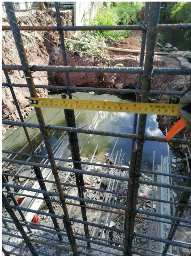
Ilustración 60. Revisión de armado de acero de pantalla del embaulado.
