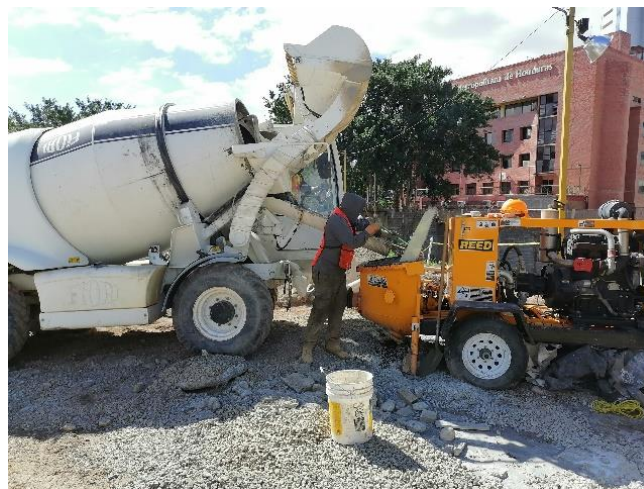
Ilustración 30. Llegada del camión mixer al sitio.
