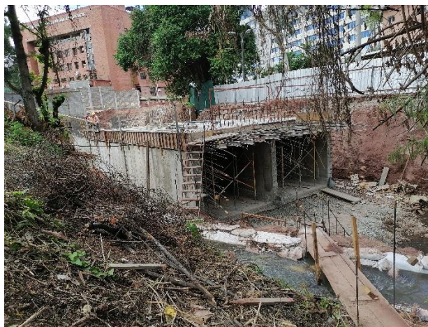
Ilustración 24. Sección de embaulado en proceso de construcción.
