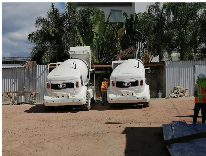
Ilustración 28. Camiones mixers de 3.5 y 2.5 metros cúbicos.
