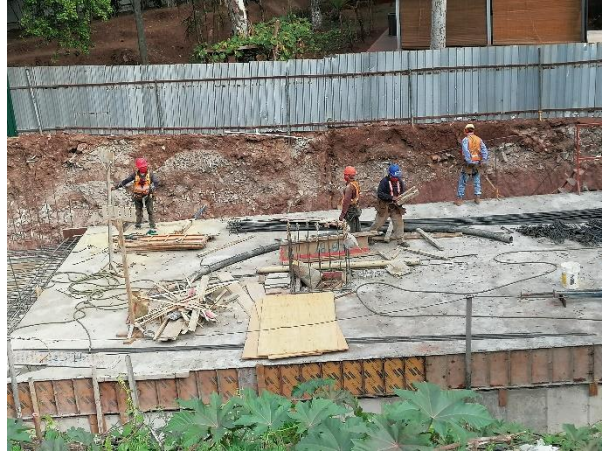
Ilustración 26. Preparación de encofrado losa superior de embaulado.
