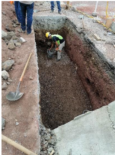
Ilustración 22. Excavación y limpieza para colocación de base granular.
