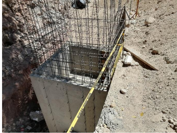
Ilustración 90. Cajas de concreto de colectores de aguas negras al lado izquierdo del embaulado.
