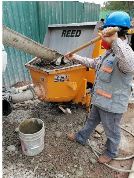
Ilustración 82. Muestras de material para generar cilindros de concreto.
