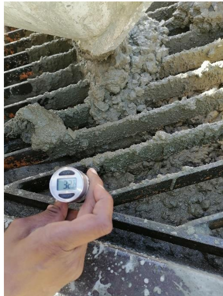
Ilustración 29. Toma de temperatura del concreto vertido en sitio.
