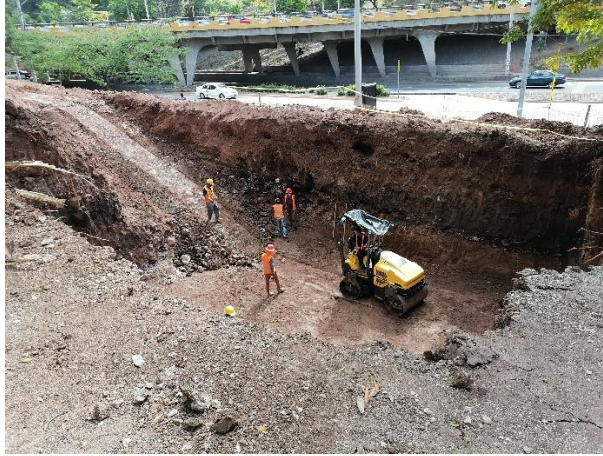
Ilustración 16. Compactación de suelo en excavación.
