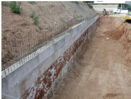
Ilustración 14. Muros de contención de concreto.
