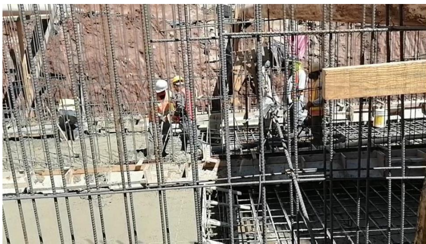
Ilustración 38. Fundición de losa inferior estación 0+133 a 0+147.
