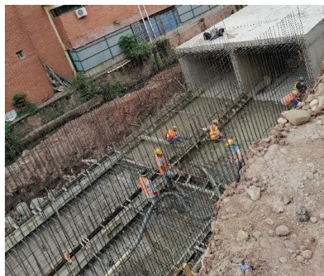
Ilustración 81. Fundición de losa inferior entre estaciones 0+172 a 0+185.
