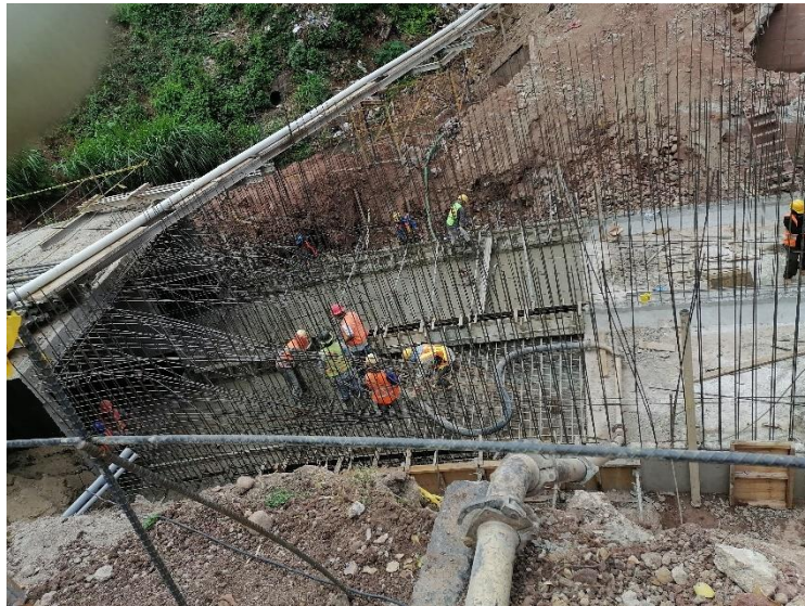
Ilustración 89. Fundición losa inferior estación 0+190 a 0+202.
