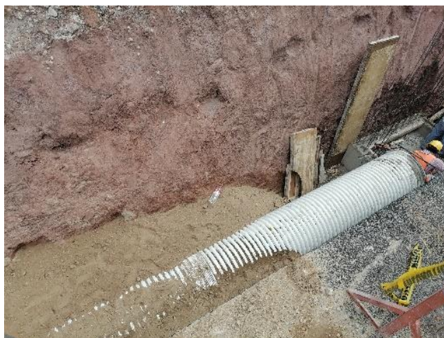
Ilustración 77. Compactación de material selecto en tramos de tuberías.
