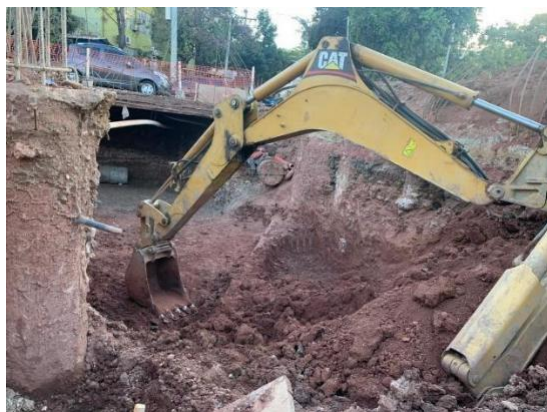
Ilustración 53 Finalización de excavación estructural en el túnel CCCIT-Hondutel
