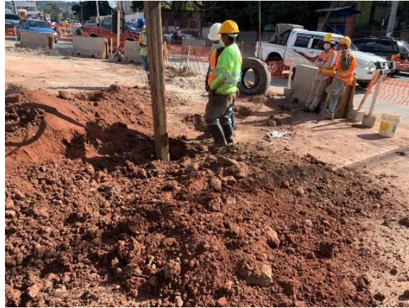
Ilustración 20 Perforación en túnel CCIT
