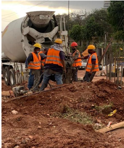
Ilustración 57 Fundición de 7 pilotes en el túnel CCIT-Hondutel
