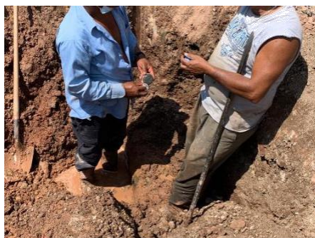
Ilustración 37 Reparación de válvula en CCIT
