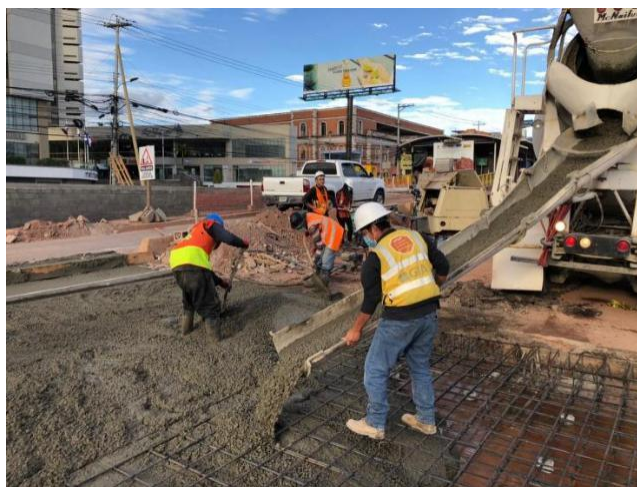
Ilustración 64 Fundición de losa en túnel Metrópolis con una cantidad de 27m3 de concreto
