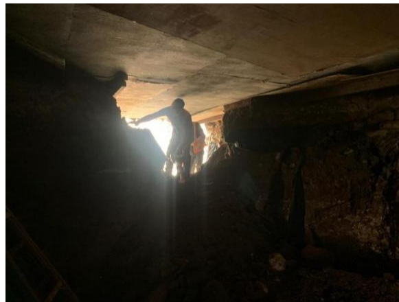
Ilustración 71 Finalización de conexión de túneles en túnel CCIT-Hondutel
