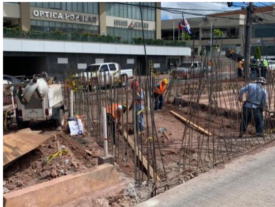
Ilustración 51 Excavación estructural para losa en túnel Metrópolis
