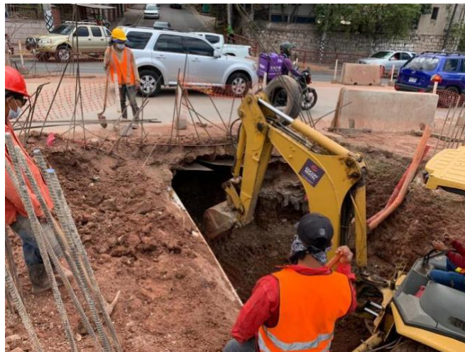
Ilustración 46 Excavación estructural en túnel CCIT-Hondutel con maquinaria pesada
