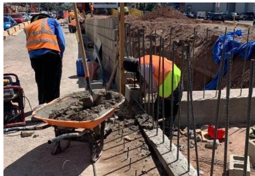
Ilustración 32 Pegado de bloque en jamba
