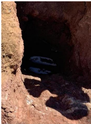
Ilustración 19 Calicata para ubicar la fibra óptica de Hondutel
