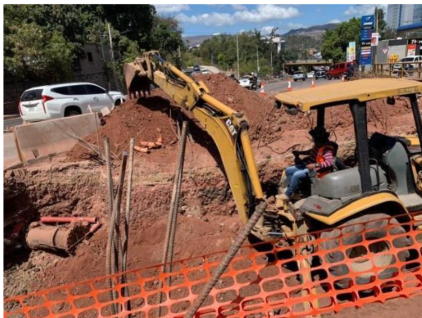
Ilustración 52 Continuación de excavación estructural con retroexcavadora en túnel CCIT-Hondutel
