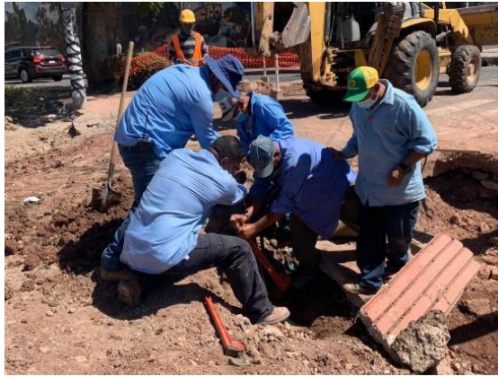
Ilustración 35 Reparación de válvula en CCIT
