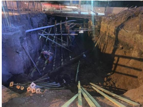
Ilustración 54 Colocación de puntales en el túnel CCIT-Hondutel
