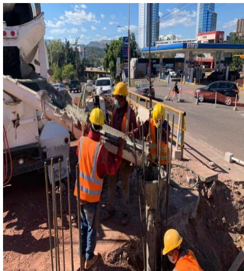
Ilustración 25 Fundición de 13 pilotes en túnel CCIT
