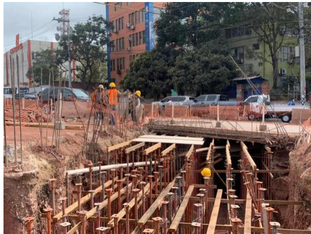
Ilustración 56 Colocación de lámina de plywood de 3/8 en túnel CCIT-Hondutel
