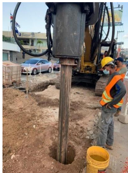
Ilustración 39 Comienzo de perforaciones en túnel Metrópolis
