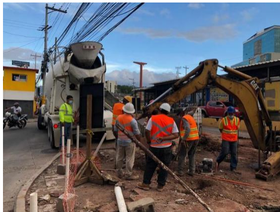
Ilustración 69 Fundición de 4 pilotes con una cantidad de 3.5m 3 de concreto
