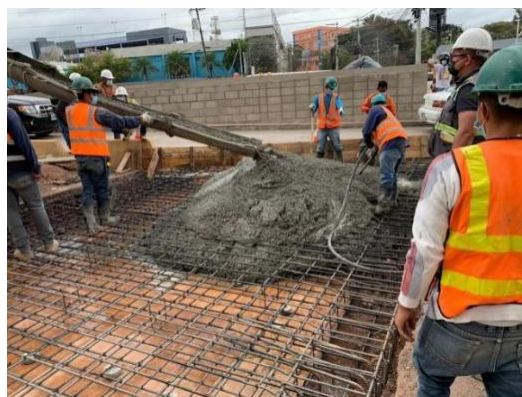
Ilustración 58 Fundición de losa en el túnel Metrópolis
