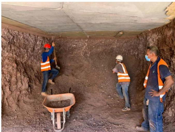
Ilustración 67 Excavación estructural en túnel Metrópolis
