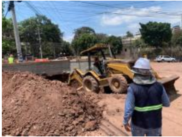
Ilustración 72 Excavación estructural en túnel CCIT-Hondutel en el sector de emisora unidas
