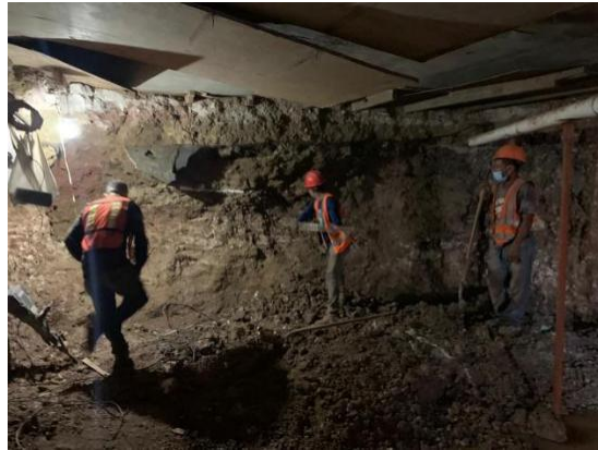
Ilustración 68 Excavación estructural en túnel CCIT-Hondutel para la conexión del sector de INGEOMIN con CCIT
