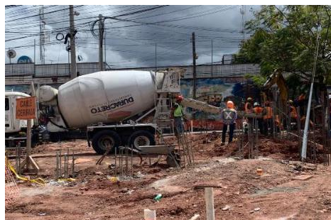
Ilustración 60 Fundición de 10 pilotes en túnel CCIT-Hondutel
