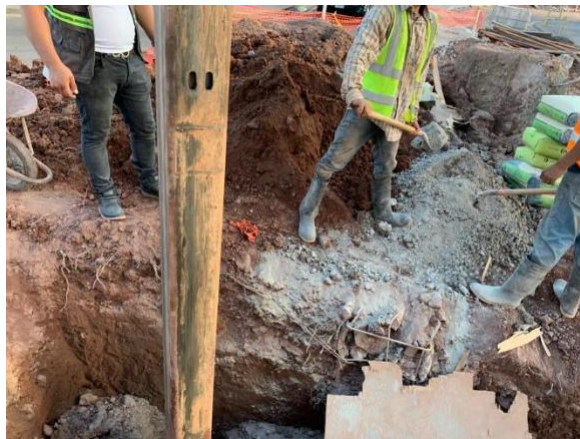
Ilustración 62 Colocación de suelo cemento para las perforaciones
