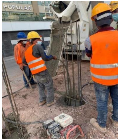
Ilustración 41 Fundición de 11 pilotes en túnel Metrópolis
