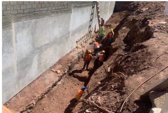
Ilustración 36 Continuación de excavación para zapatas
