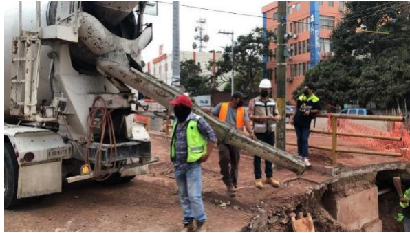
Ilustración 50 Fundición de 6 pilotes en túnel CCIT-Hondutel
