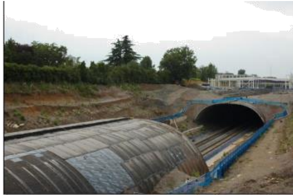
Ilustración 9. Túnel construido Cut and Cover.
