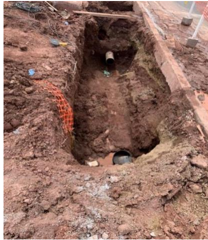
Ilustración 61 Reparación de tubería de 8" en túnel Metrópolis
