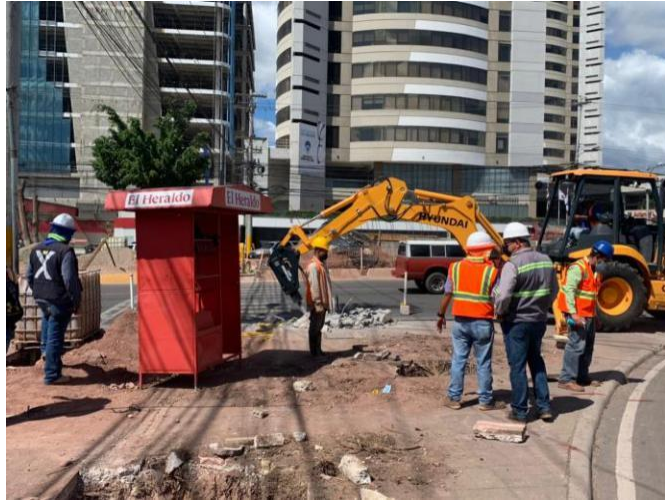
Ilustración 59 Demolición para perforaciones en túnel Metrópolis
