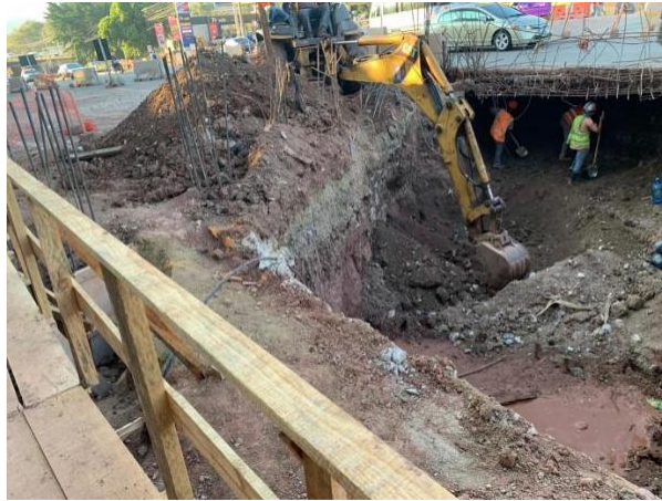
Ilustración 70 Excavación estructural en túnel CCIT-Hondutel en el sector de INGEOMIN
