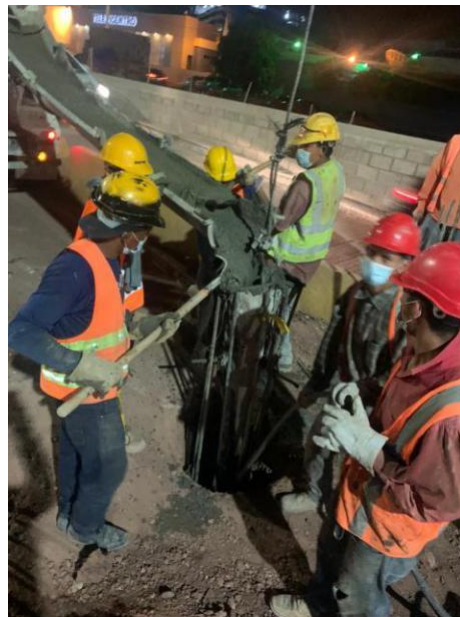
Ilustración 48 Fundición de 11 pilotes en el túnel Metrópolis
