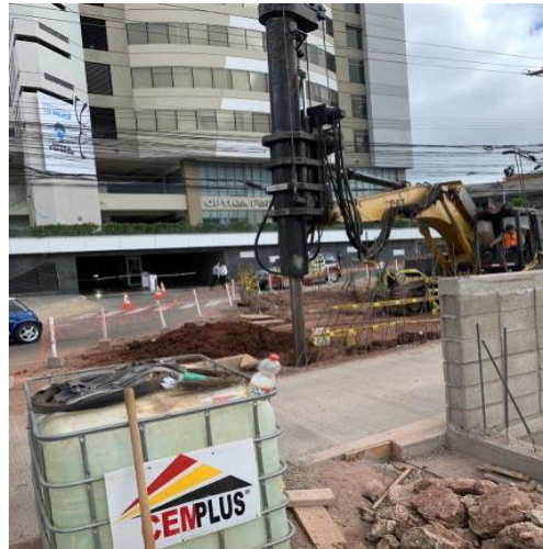
Ilustración 47 Continuación de perforaciones en túnel Metrópolis
