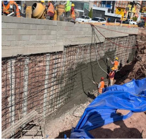
Ilustración 24 Fundición de pared con concreto lanzado
