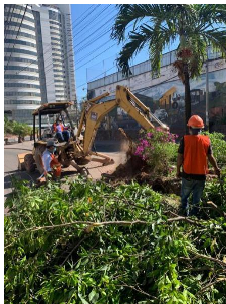
Ilustración 55 Extracción de árboles en el túnel CCIT-Hondutel
