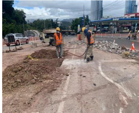
Ilustración 18 Demolición de losa de concreto
