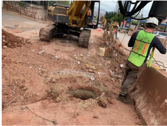
Ilustración 63 Continuación de 18 perforaciones en túnel CCIT-Hondutel en el sector de INGEOMIN
