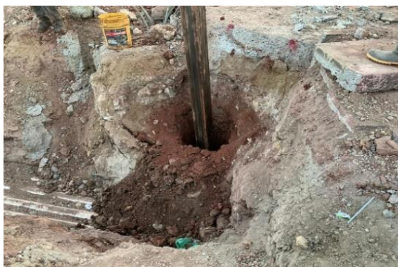
Ilustración 28 Continuación de perforaciones en túnel CCIT
