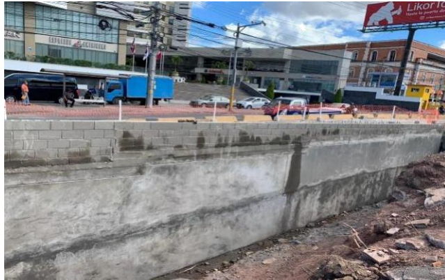
Ilustración 26 Pared de concreto lanzado túnel Metrópolis
