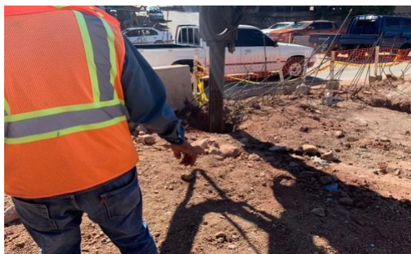
Ilustración 23 Perforaciones para pilotes en túnel CCIT
