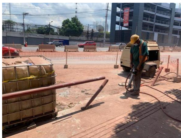
Ilustración 66 Demolición de acera y bordillo en el túnel CCIT-Hondutel
