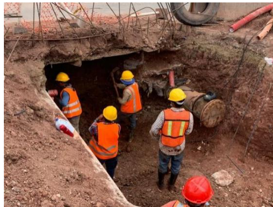
Ilustración 44 Inicio de excavación estructural en túnel CCIT-Hondutel
