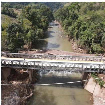
Ilustración 2 Puente Bailey La Arada, Santa Bárbara
