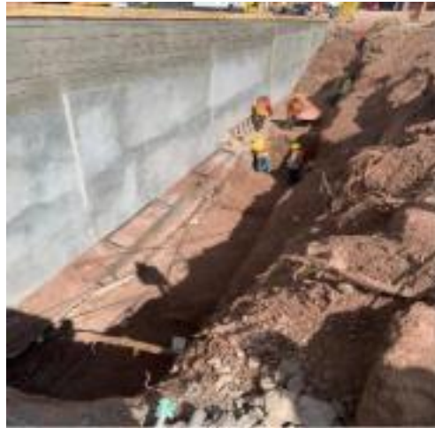
Ilustración 38 Armado de zapata tipo Z-1
