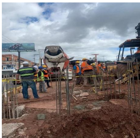
Ilustración 5 Obra en ejecución, túneles peatonales
