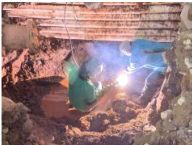
Ilustración 30 Soldadura de placa para reparación de tubería perforada
