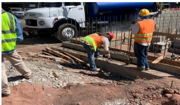
Ilustración 31 Fundición para pared de bloque en la jamba
