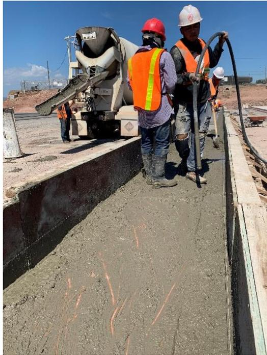
**Ilustración 16: Fundición de canaleta en zona de avionetas**
