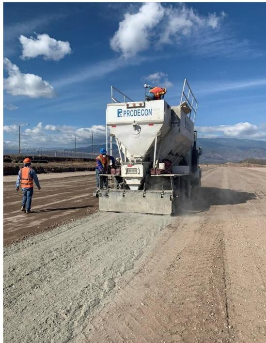
**Ilustración 41: Espaciador de cemento**
