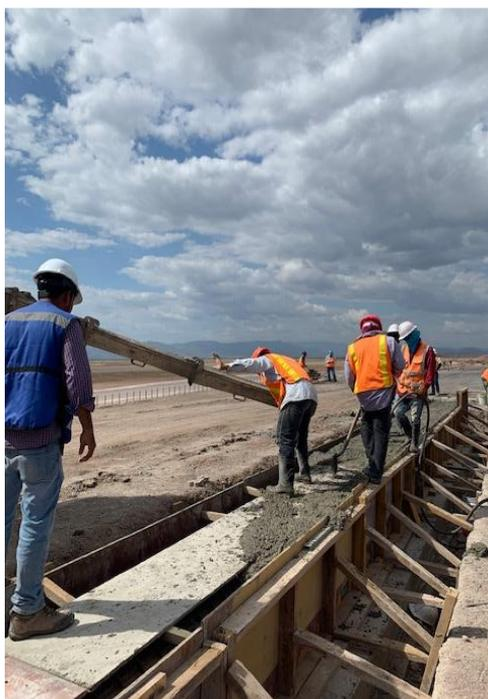
**Ilustración 35: Armado, encofrado y fundición de cajas de canaletas**
