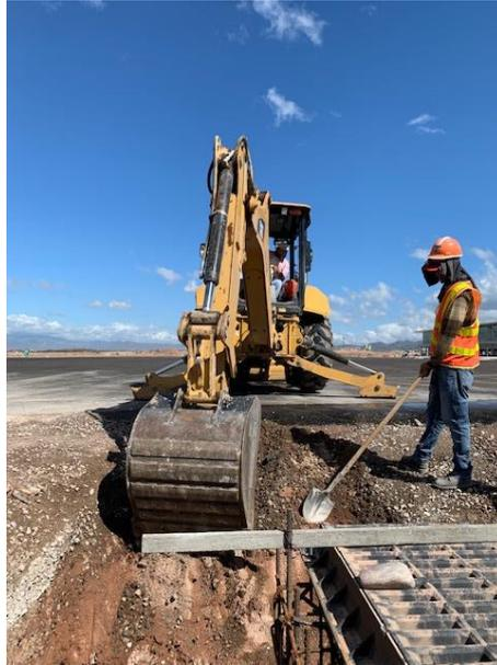
**Ilustración 33: Excavación para cajas de aguas lluvias**
