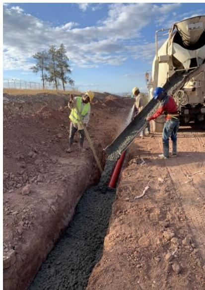
**Ilustración 47 Fundición de canalización balizamiento**
