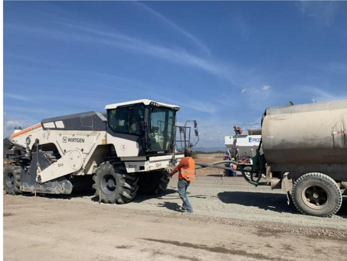
**Ilustración 42: Proceso de mezclado**
