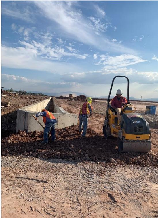
**Ilustración 24: Relleno en canal**
