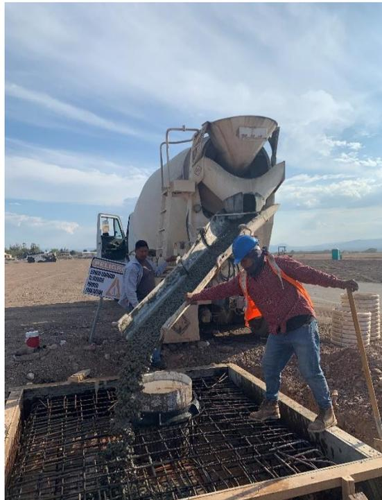
**Ilustración 21: Fundición de cajas de aguas lluvias**
