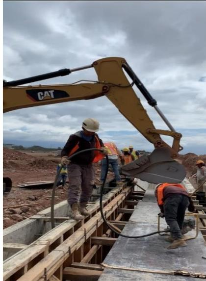
**Ilustración 19: Fundición del canal en "Acceso 3"**
