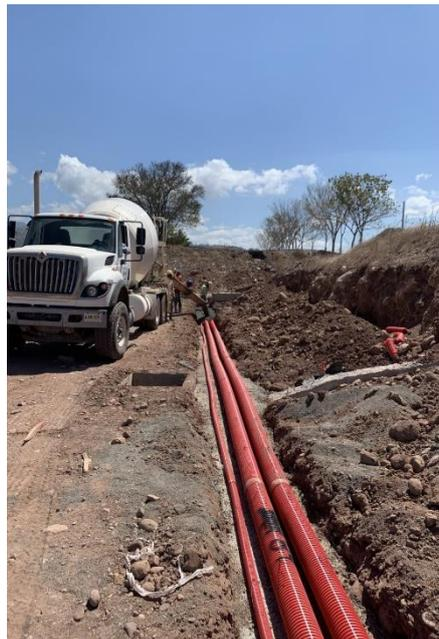
**Ilustración 48: Fundición de canalización de media tensión**
