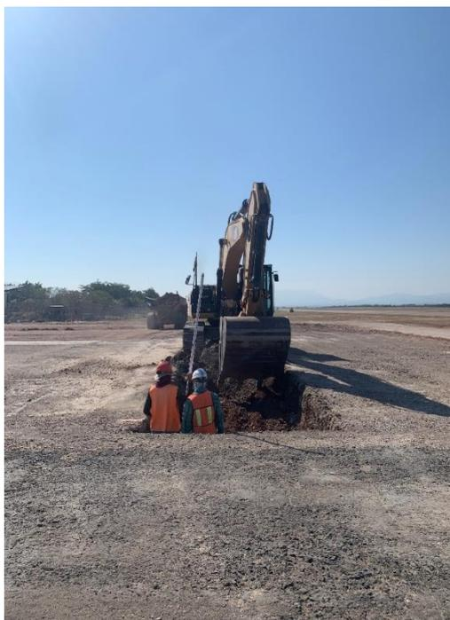
**Ilustración 26: Excavación para canaletas en zona de avionetas**
