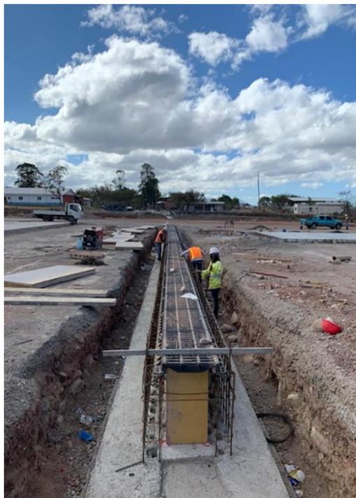
**Ilustración 32: Colocación de rejilla**
