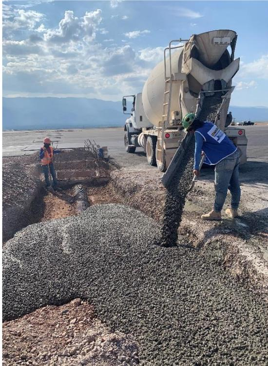
**Ilustración 22: Fundición de resane de tubería**
