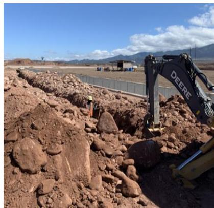
**Ilustración 45: Excavación para canalización en calle de rodaje**
