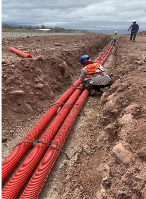
**Ilustración 46: Instalación de tubos en calle de rodaje**
