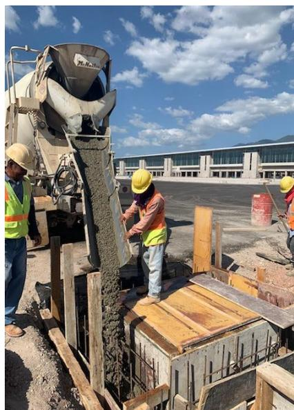
**Ilustración 34: Armado, encofrado y fundición de cajas de aguas lluvias**
