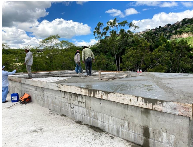
ILUSTRACIÓN 67 FUNDICIÓN DE LOSA DE SALA
