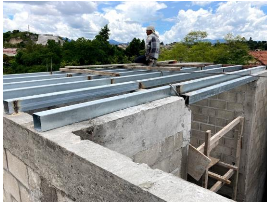
ILUSTRACIÓN 63 ENTABICADO EN TUBOS DE LOSA
