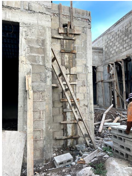
ILUSTRACIÓN 73 FUNDICIÓN DE RANURAS DE BAJANTES DE AGUAS LLUVIAS
