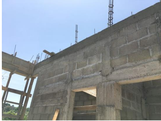
ILUSTRACIÓN 24 SOLERAS DE DORMITORIO 2
