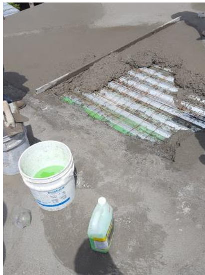
ILUSTRACIÓN 49 ADITIVO PARA UNIÓN DE CONCRETO VIEJO CON CONCRETO NUEVO
