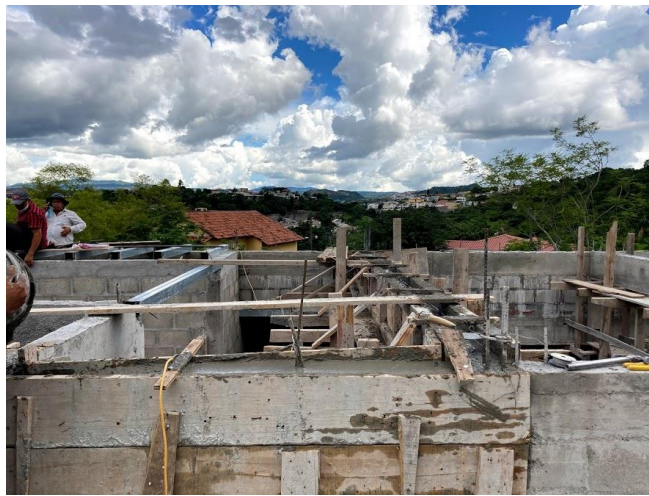
ILUSTRACIÓN 61 FUNDICIÓN DE VIGA DE 10 DE SALA
