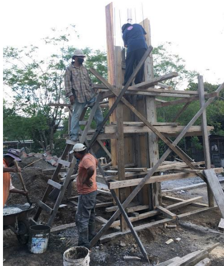
ILUSTRACIÓN 14 FUNDICION DE PARED ARMADA DE SALA
