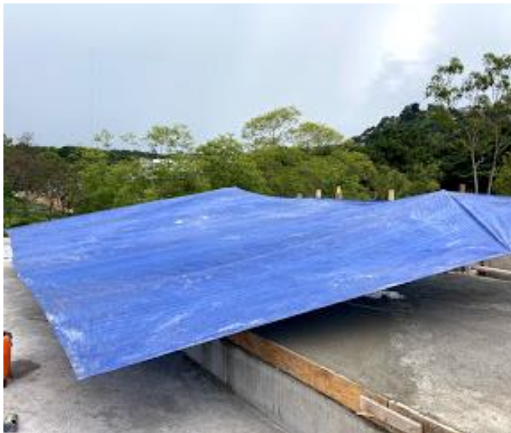
ILUSTRACIÓN 56 LOSA DE TECHO DE MÓDULO DE COMEDOR
