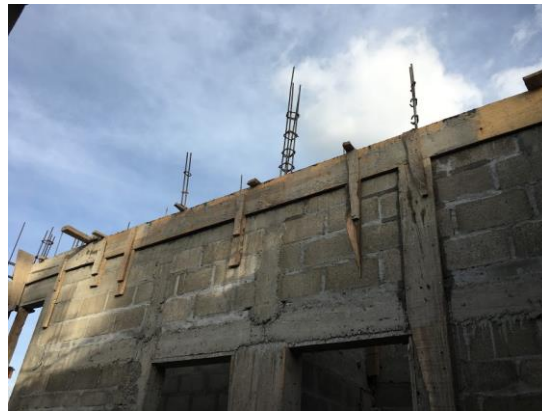
ILUSTRACIÓN 23 FUNDICIÓN DE SOLERAS DE CIERRE EN ÁREA DE LAVANDERÍA
