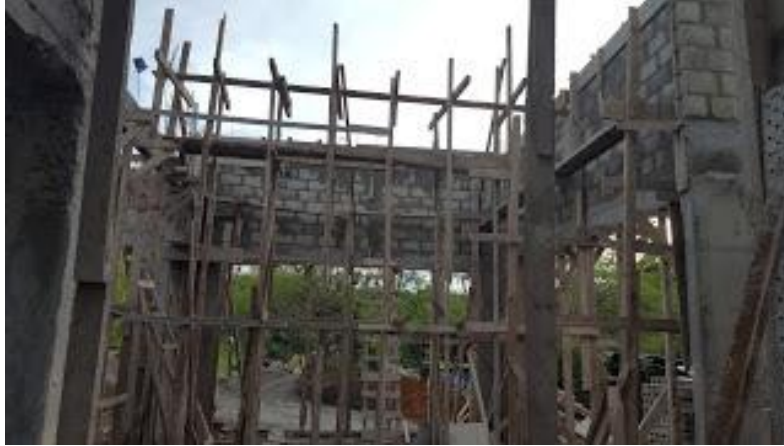
ILUSTRACIÓN 42 FUNDICIÓN DE SOLERAS DE CIERRE EN MÓDULO DE SALA
