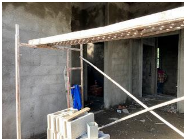
ILUSTRACIÓN 51 AZOTADO DE PARED DE DORMITORIO PRINCIPAL
