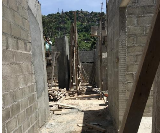
ILUSTRACIÓN 26 DESENCOFRADO DE PANTALLA ARMADA EN SALA
