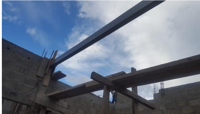
ILUSTRACIÓN 36 COLOCACIÓN DE TUBOS 4X8" CHAPA 11 PARA LOSA DE TECHO
