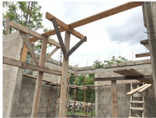
ILUSTRACIÓN 25 APUNTALADO DE VIGA DE COCINA/DESAYUNADOR
