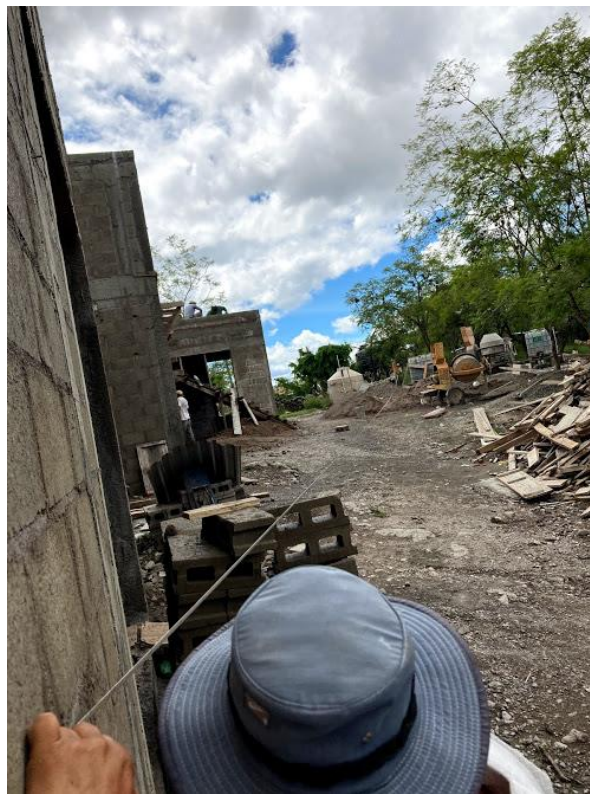
ILUSTRACIÓN 75 TRAZADO Y REPLANTEO PARA TERRAZA POSTERIOR
