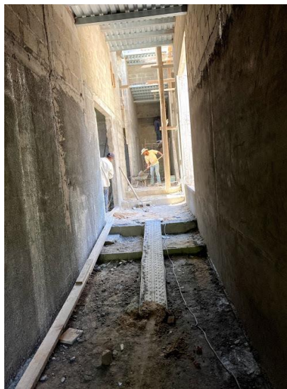
ILUSTRACIÓN 78 AZOTADO DE PAREDES DE PASILLO DE DORMITORIOS
