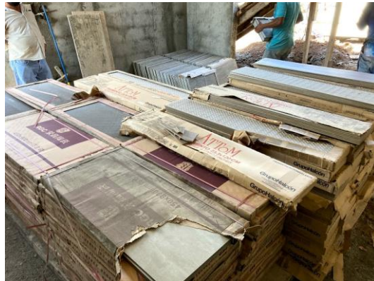
ILUSTRACIÓN 81 DESCARGA DE PORCELANATO PARA PISOS Y ENCHAPES
