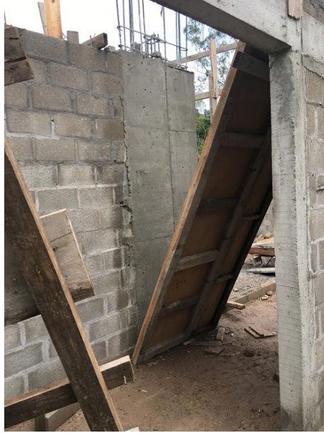
ILUSTRACIÓN 13 DESENCOFRADO DE PARED ARMADA
