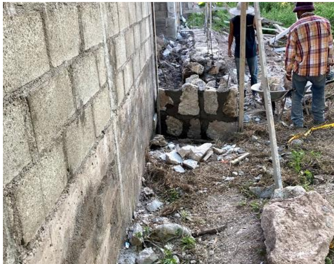
ILUSTRACIÓN 76 CONFORMACIÓN DE MURO DE PIEDRA PARA TERRAZA FRONTAL
