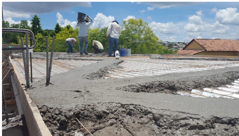
ILUSTRACIÓN 40 CONFORMACIÓN DE MAESTRAS PARA DESNIVEL DE LOSA DE TECHO
