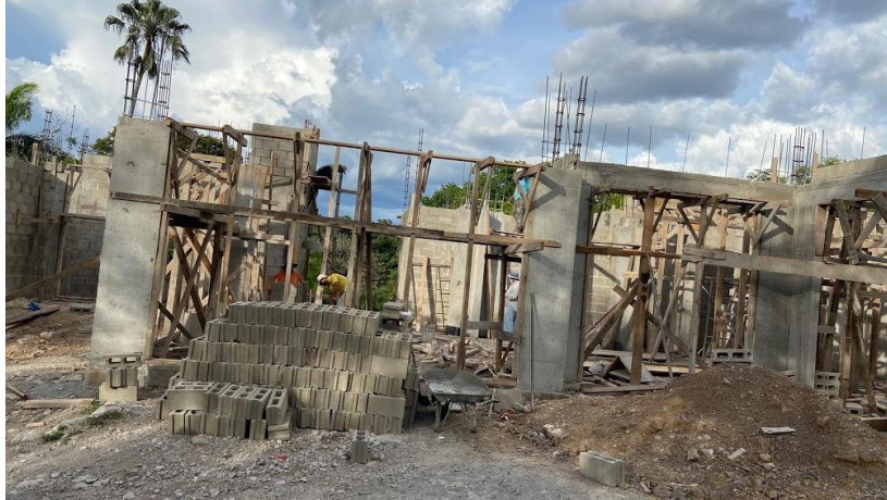
ILUSTRACIÓN 28 PILOTEADO PARA VIGAS
