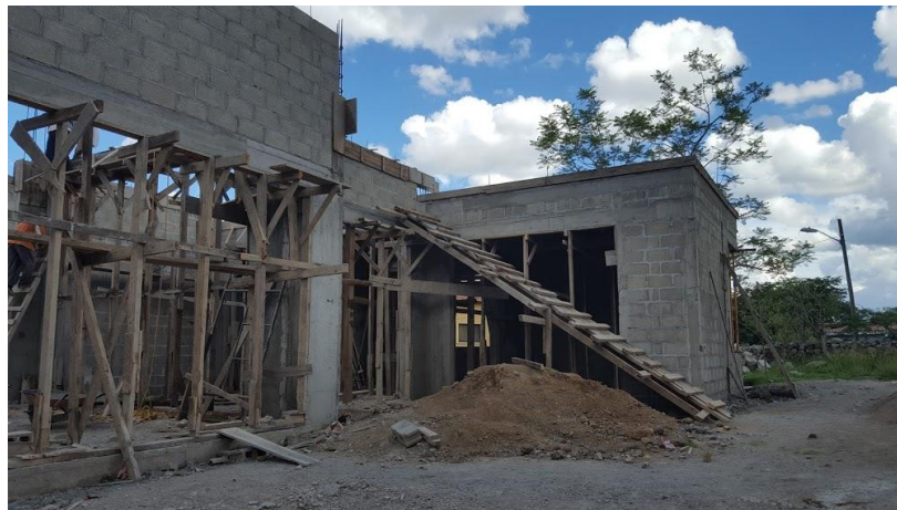
ILUSTRACIÓN 39 RAMPA PARA ACCEDER AL TECHO
