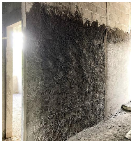
ILUSTRACIÓN 82 REPELLO EN PARED DE PASILLO
