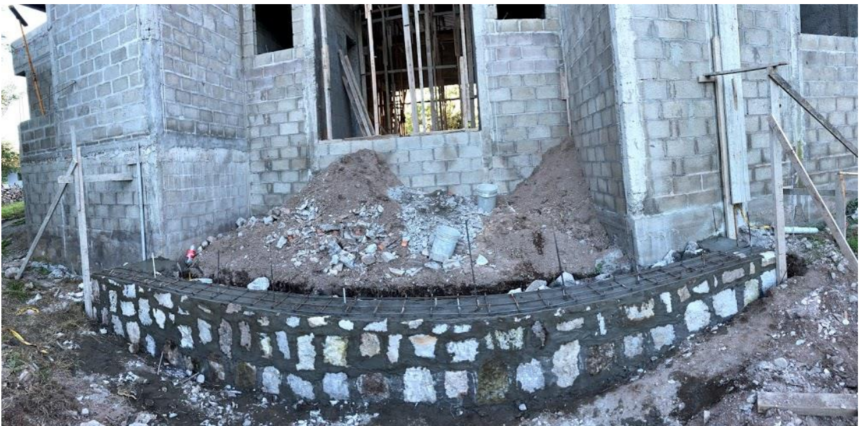
ILUSTRACIÓN 77 MURO DE PIEDRA PARA TERRAZA FRONTAL
