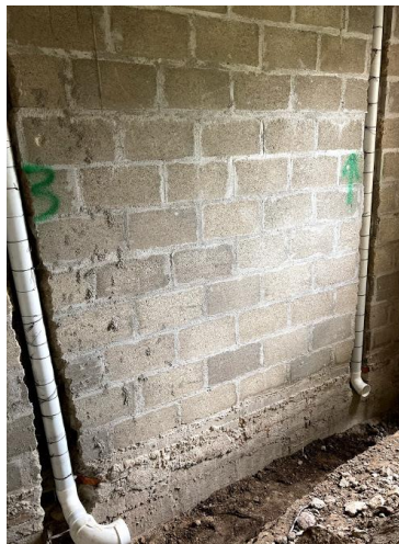
ILUSTRACIÓN 64 COLOCADO DE TUBO PVC PARA BAJANTES DE AGUAS LLUVIAS
