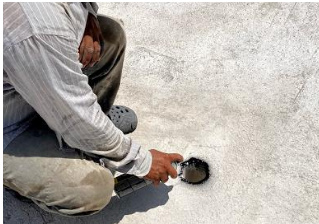
ILUSTRACIÓN 72 IMPERMEABILIZACIÓN PARA BAJANTES EN LOSA
