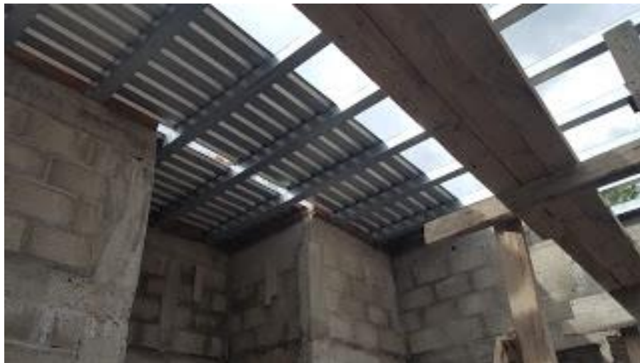
ILUSTRACIÓN 43 COLOCACIÓN DE LÁMINA DE CALIBRE 25 EN ÁREA DE DORMITORIO 1
