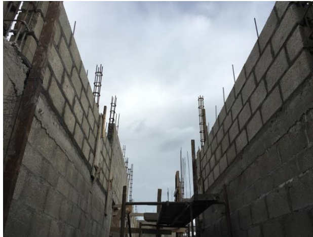
ILUSTRACIÓN 17 LEVANTAMIENTO DE PARED DE BLOQUE EN PASILLOS
