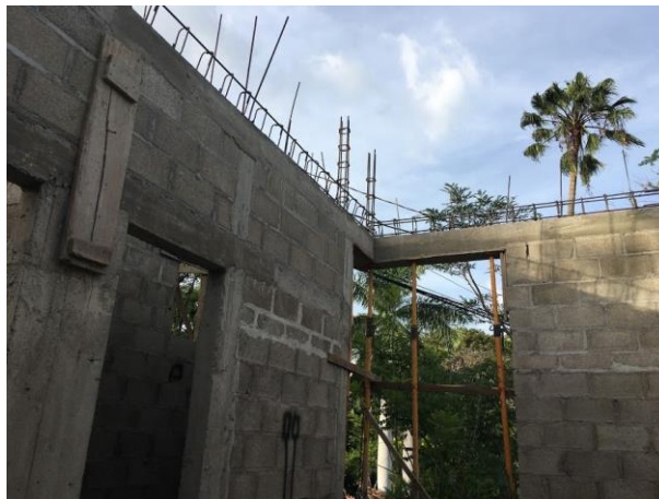
ILUSTRACIÓN 21 SOLERAS DE CIERRE
