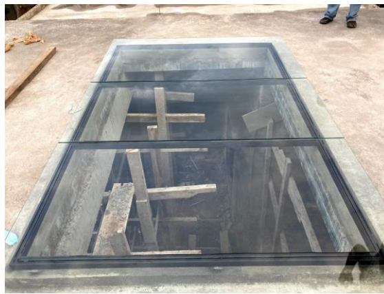
ILUSTRACIÓN 69 INSTALACIÓN DE VIDRIO PARA TRAGALUZ
