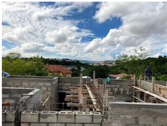
ILUSTRACIÓN 60 FUNDICIÓN DE VIGA 12 DE SALA
