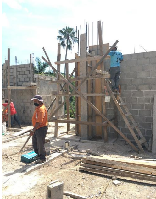
ILUSTRACIÓN 12 FUNDICIÓN DE PANTALLA ARMADA
