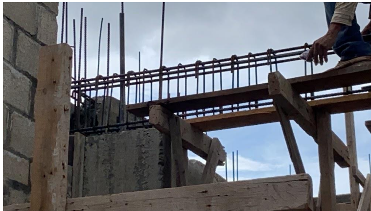
ILUSTRACIÓN 30 ARMADO DE VIGA DE SALA
