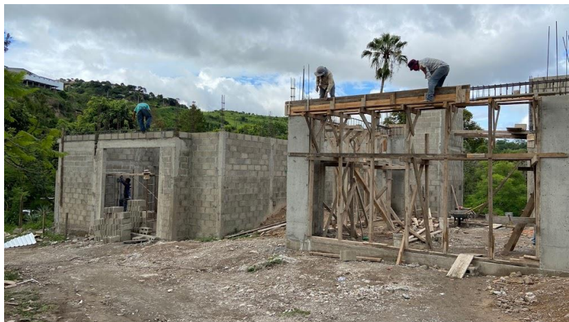
ILUSTRACIÓN 31 ENCOFRADO DE CARGADOR DE PUERTA DE SALA
