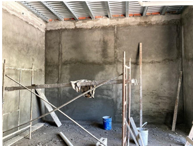
ILUSTRACIÓN 74 REPELLO EN PARED DE DORMITORIO PRINCIPAL
