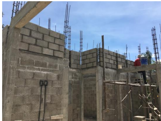
ILUSTRACIÓN 11 LEVANTAMIENTO DE PARED DE BLOQUE EN DORMITORIO PRINCIPAL
