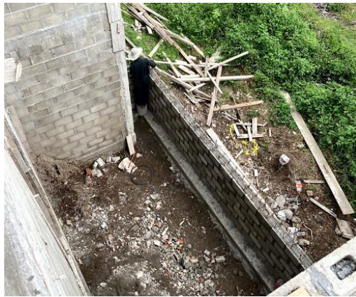
ILUSTRACIÓN 83 VISTA EN ELEVACIÓN DE MURO PARED DE BLOQUE EN MURO DE CONTENCIÓN
