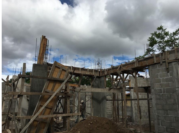
ILUSTRACIÓN 18 FUNDICIÓN DE CARGADOR DE4 Y D14
