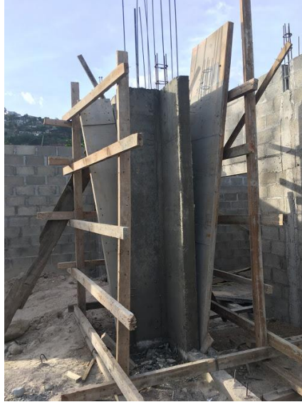
ILUSTRACIÓN 22 DESENCOFRADO DE PARED ARMADA
