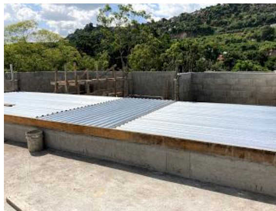
ILUSTRACIÓN 53 ENCOSTILLADO DE LOSA Y COLOCACIÓN DE LÁMINA DE ALUZINC EN LOSA DE TECHO
