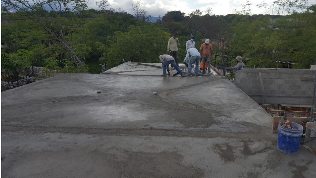
ILUSTRACIÓN 41 FUNDICIÓN DE LOSA DEL MÓDULO DE COCINA. DESAYUNADOR Y LAVANDERÍA
