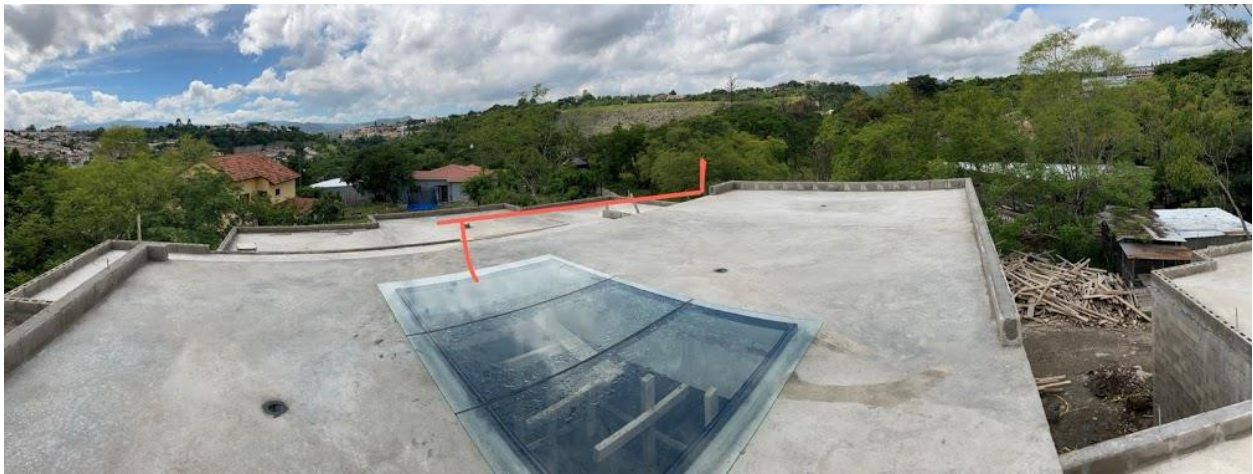
ILUSTRACIÓN 80 BLOQUE PERIMETRAL EN LOSA DE TECHO
