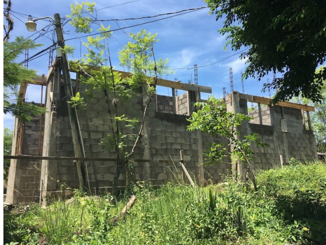
ILUSTRACIÓN 15 FUNDICION DE SOLERAS DE CIERRE ALA ESTE
