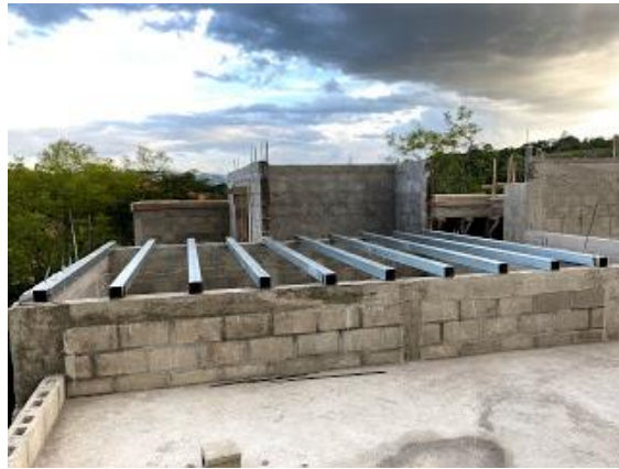
ILUSTRACIÓN 52 COLOCACIÓN DE TUBOS EN ZONA CORRESPONDIENTE A DORMITORIO 1
