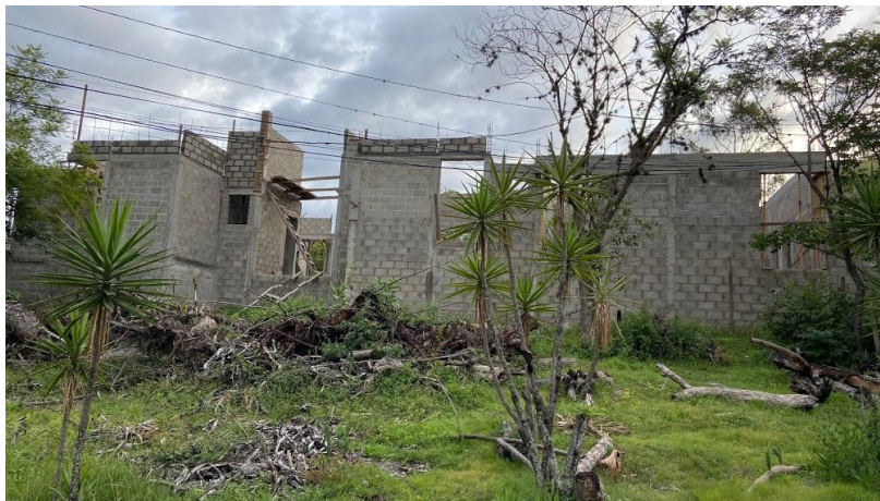
ILUSTRACIÓN 29 LEVANTAMIENTO DE PARED EN VESTÍBULO
