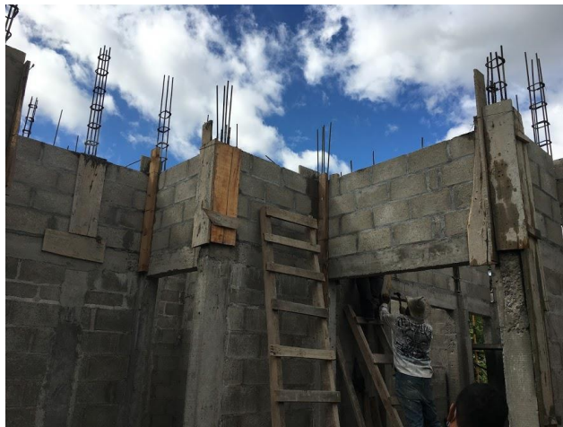
ILUSTRACIÓN 19 FUNDICIÓN DE CASTILLOS EN ÁREA DEL DORMITORIO PRINCIPAL
