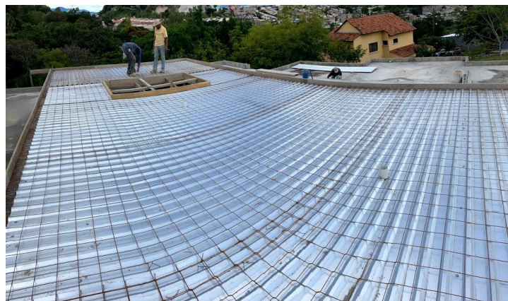
ILUSTRACIÓN 66 ELECTROMALLA EN LOSA DE TECHO DE SALA
