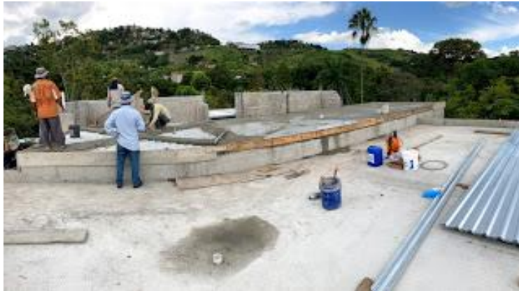
ILUSTRACIÓN 55 CONFORMACIÓN DE MAESTRAS PARA DESNIVEL DE LOSA DE TECHO
