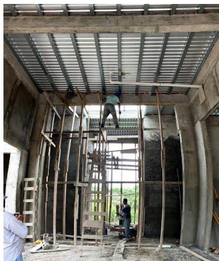
ILUSTRACIÓN 84 REMOCIÓN DE PUNTALES EN VIGA DE SALA
