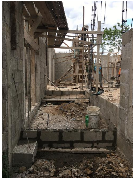
ILUSTRACIÓN 16 CONFORMACION DE DESNIVEL PARA GRADAS DE PASILLO
