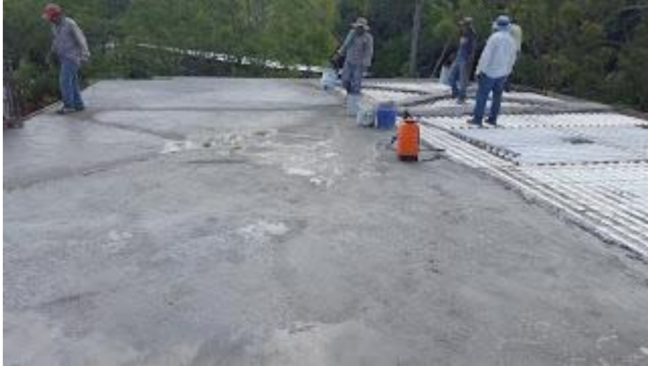
ILUSTRACIÓN 46 PRIMERA FUNDICIÓN DE LOSA EN MÓDULO DE DORMITORIOS
