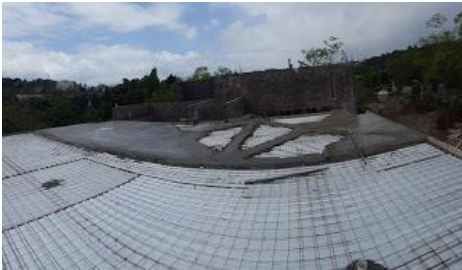
ILUSTRACIÓN 47 VISTA PANORÁMICA DE LOSA DE MÓDULO DE DORMITORIOS.
