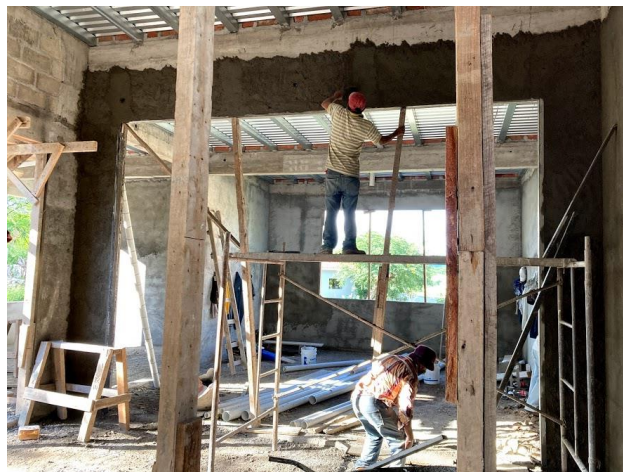
ILUSTRACIÓN 68 AZOTADO EN PARED DE COMEDOR
