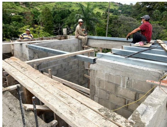
ILUSTRACIÓN 62 COLOCADO DE TUBO PARA LOSA EN VESTÍBULO
