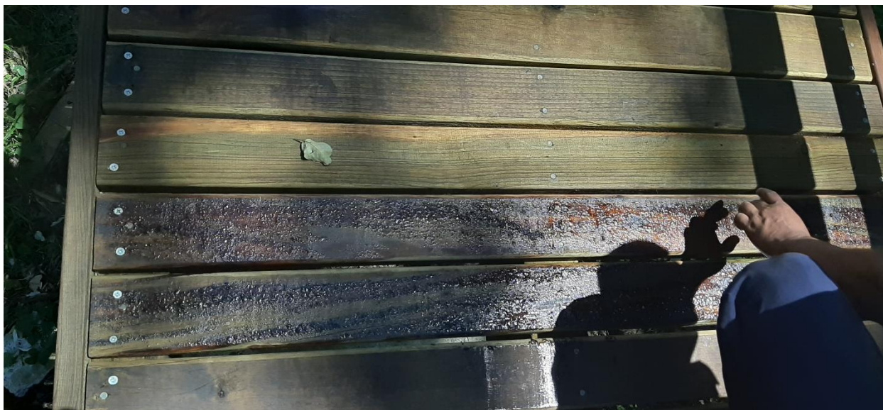
Ilustración 54 Tablones de madera con resina en puente polines en Parque Los Naranjos
