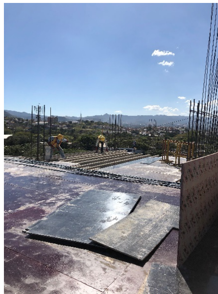
Ilustración 43-Avance en armado de tarima de losa N-07
