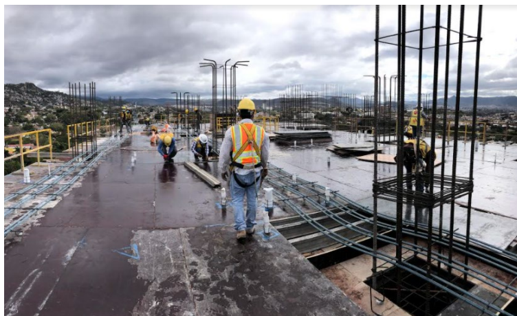
Ilustración 77-Inicio de construcción en tarima para losa N-11
