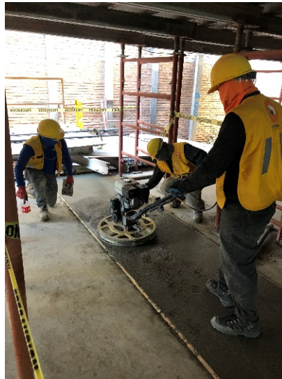
Ilustración 37-Acabado fino para franja de cerramiento en la losa E-02
