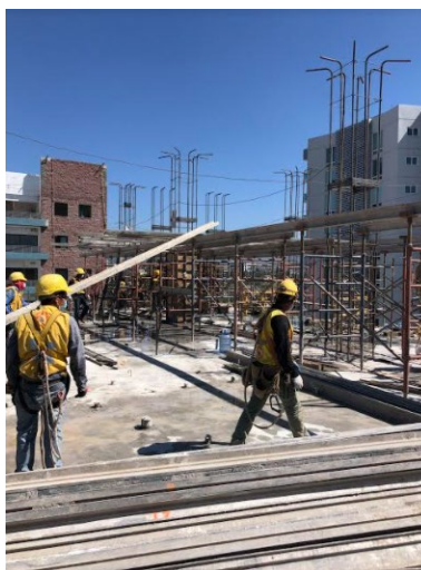
Ilustración 76-Inicio de construcción de tarima para losa N-11
