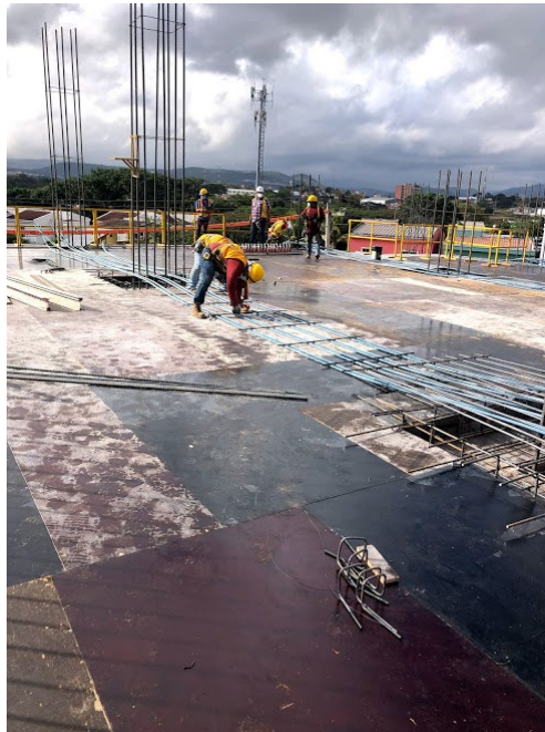
Ilustración 18-Avance en segunda parte de la losa N-04
