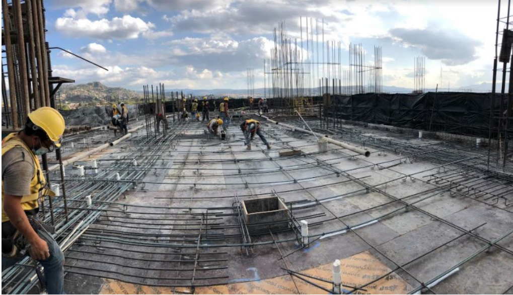
Ilustración 57-Últimos detalles en armado de losa N-08
