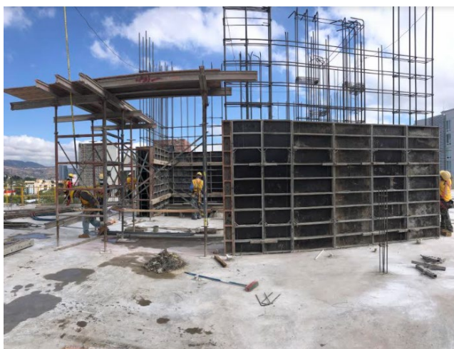
Ilustración 88-Inicio de construcción de tarima para tapadera N-13
