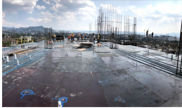
Ilustración 51-Avance en construcción de tarima de losa N-08
