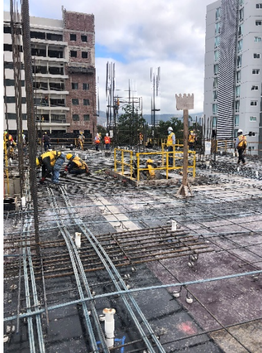
Ilustración 39-Últimos detalles constructivos en tarima de losa N-06
