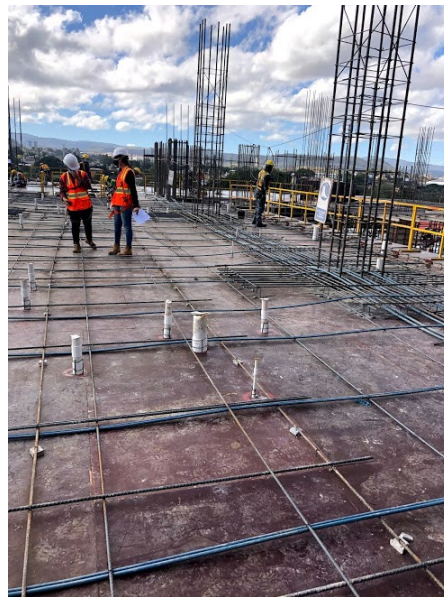
Ilustración 29-Avance de estructuración en tarima de losa N-05
