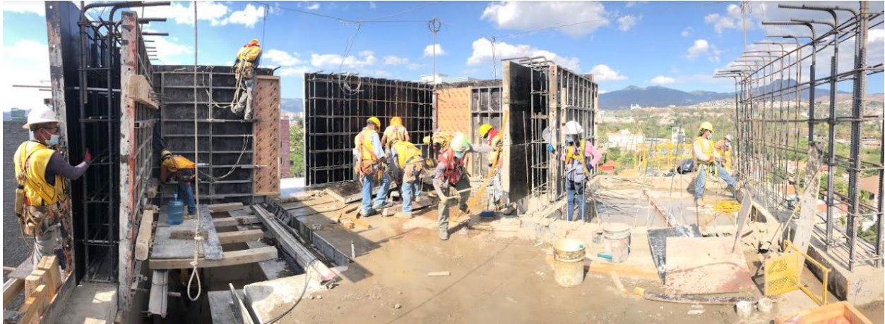
Ilustración 92-Encofrado de muros en tapadera N-13
