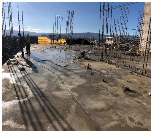
Ilustración 40-Colado de losa N-06
