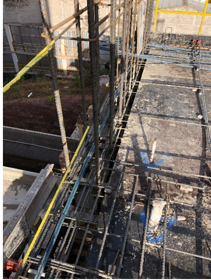
Ilustración 35-Colado de muro de la losa N-05
