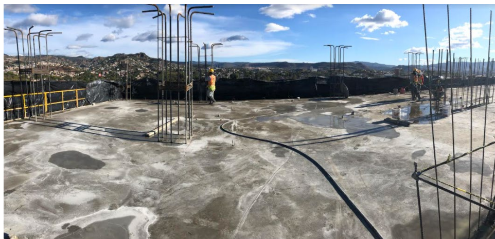
Ilustración 81-Colado de losa N-11
