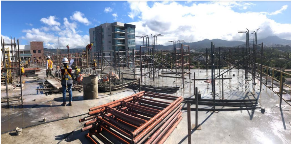
Ilustración 82-Inicio de construcción de tarima para losa N-12
