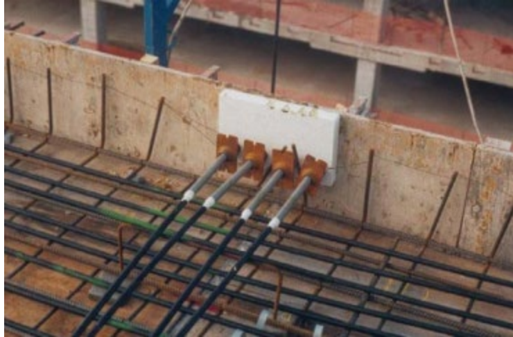
Ilustración 12-Protección de anclaje antes del hormigonado
