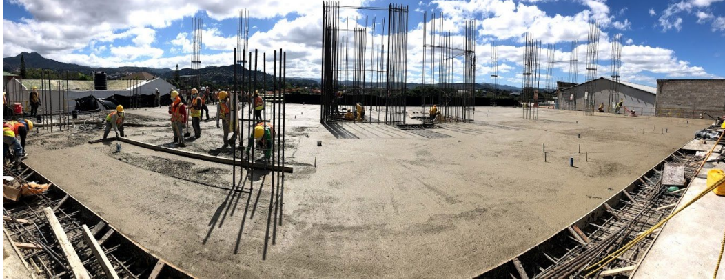
Ilustración 21-Colado de la segunda parte de la losa N-04
