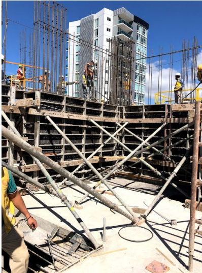
Ilustración 26-Colado de columnas y muros en losa N-04
