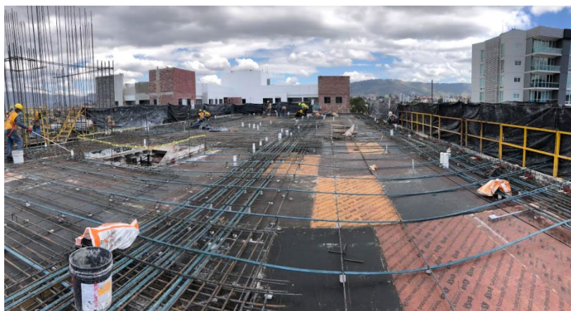
Ilustración 86-Finalización de detalles en armado de losa N-12
