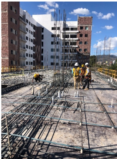
Ilustración 47-Avance de acero de refuerzo en tarima para losa N-07
