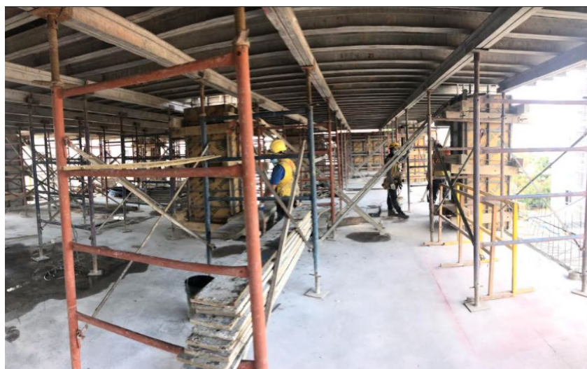
Ilustración 70-Encofrado de columnas en la losa N-09
