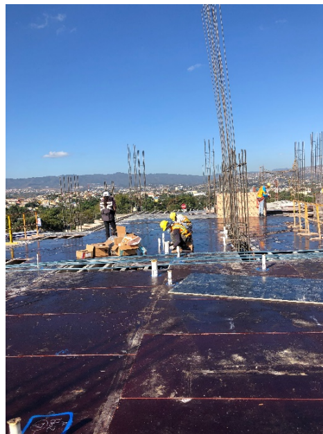
Ilustración 45-Avance de construcción de tarima para losa N-07
