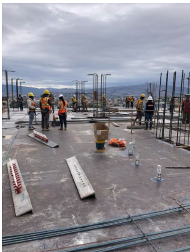
Ilustración 78-Continuación en tarima para losa N-11
