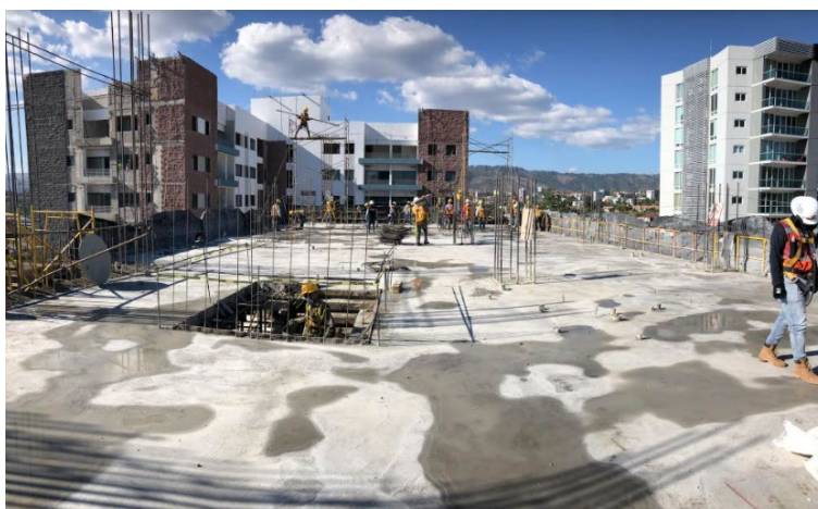
Ilustración 75-Colado de losa N-10
