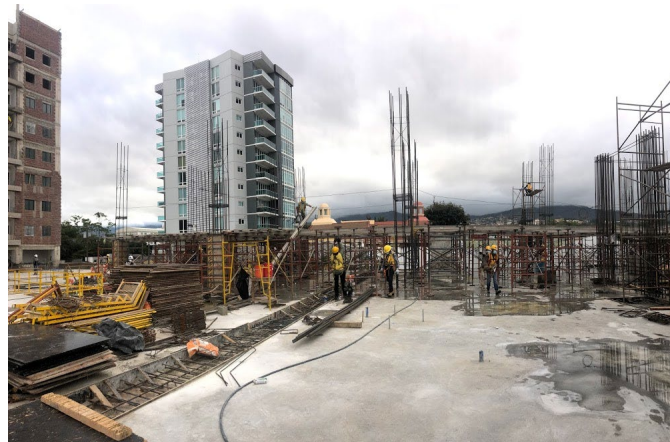
Ilustración 25-Avance de encofrado y tarima en losa N-05
