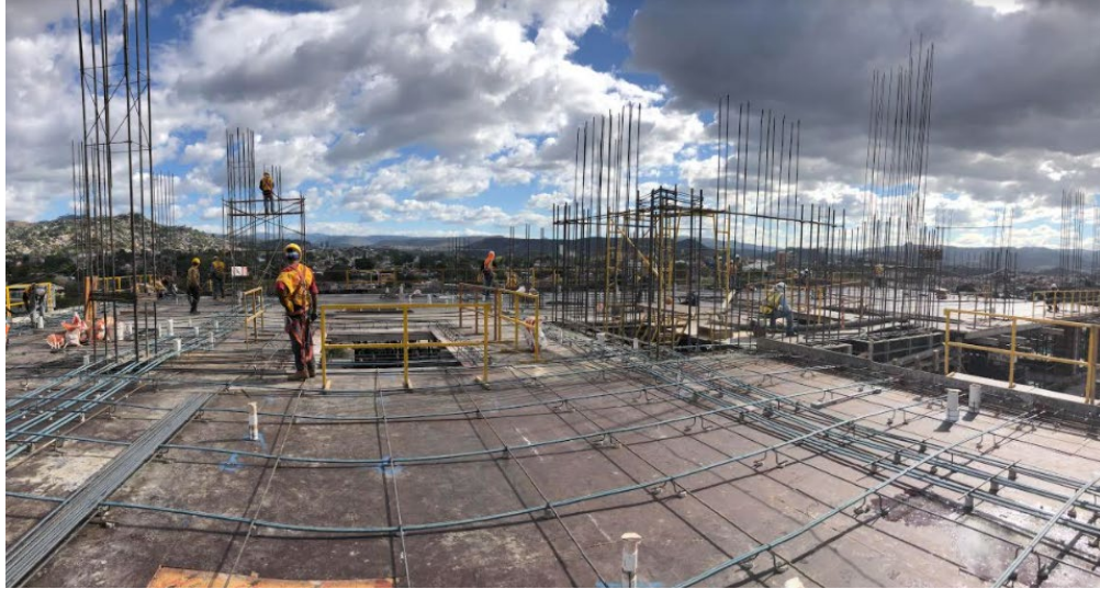
Ilustración 62-Avance en armado de tarima para losa N-09
