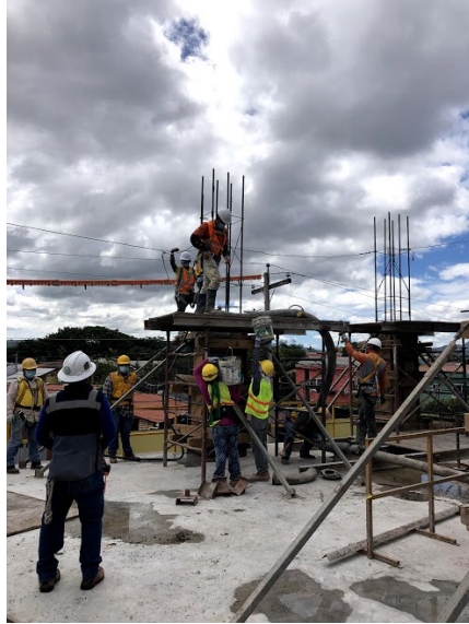
Ilustración 13-Colado de columnas en losa E-03
