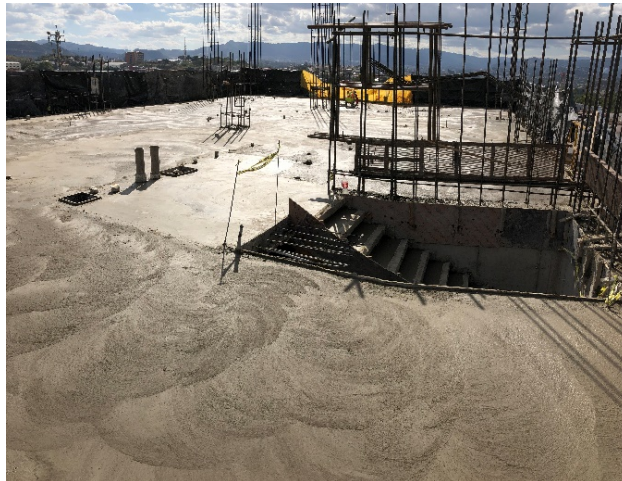
Ilustración 49-Colado de losa N-07
