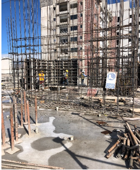
Ilustración 33-Encofrado de muros de la losa N-05
