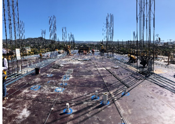
Ilustración 42-Avance en cables de presfuerzo en tarima de losa N-07
