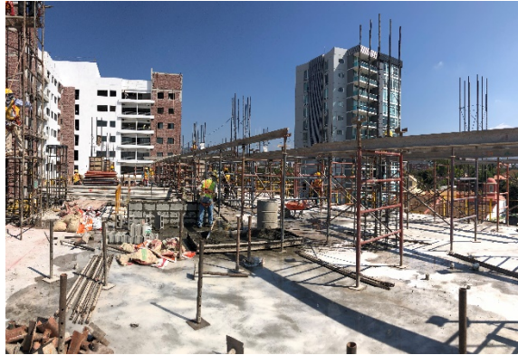
Ilustración 50-Avance en encofrado y armado de tarima para losa N-08
