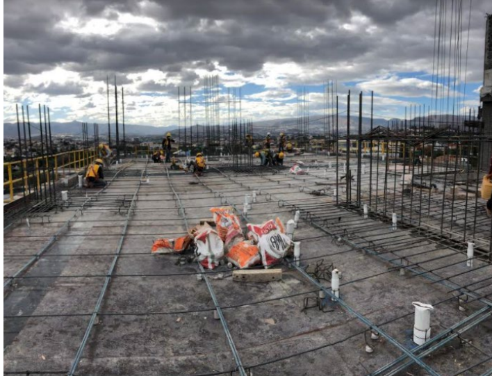
Ilustración 64-Avance en armado en la tarima para losa N-09
