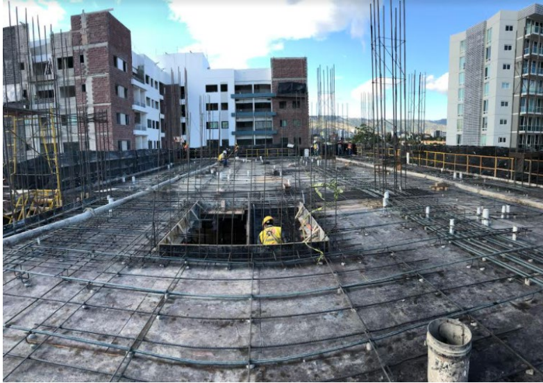
Ilustración 66-Últimos avances en tarima para la losa N-09
