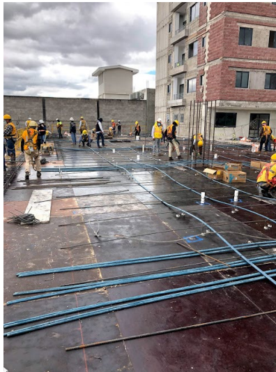
Ilustración 14-Avance primera parte de tarima para losa N-04
