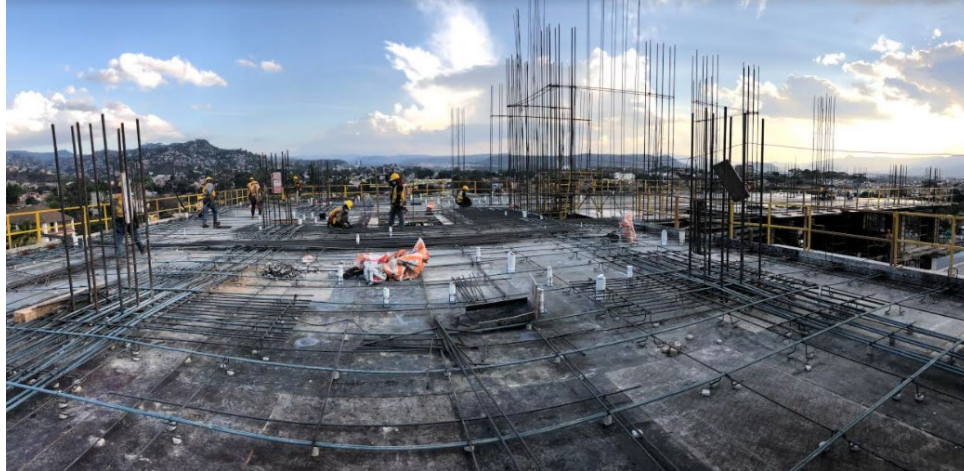
Ilustración 53-Avance en armado de tarima de losa N-08
