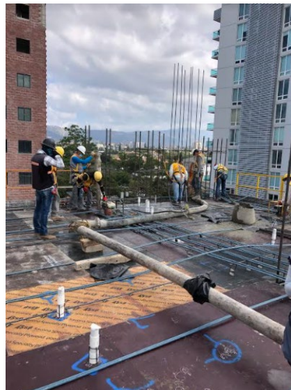
Ilustración 52-Inicio de colado en muros y columnas de losa N-07
