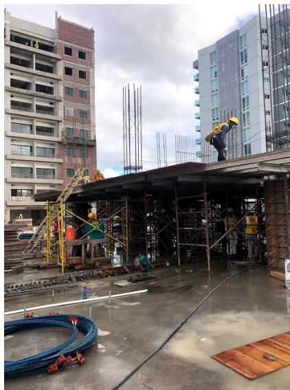
Ilustración 27-Avance en tarima de la losa N-05
