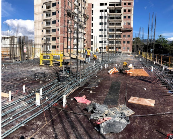
Ilustración 30-Primera parte completada de losa N-05
