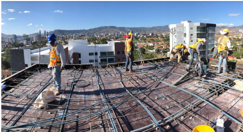
Ilustración 93-Últimos detalles de armado en tarima para tapadera N-14
