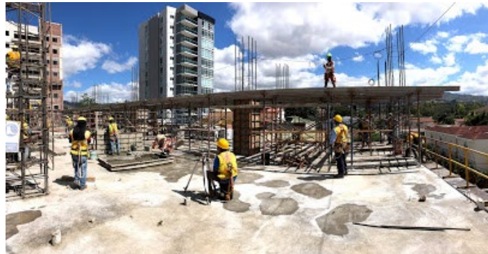
Ilustración 32-Encofrado de elementos en losa N-05 y avance en tarima de losa N-06
