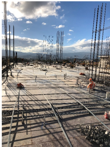
Ilustración 36-Avance en armado de tarima de losa N-06
