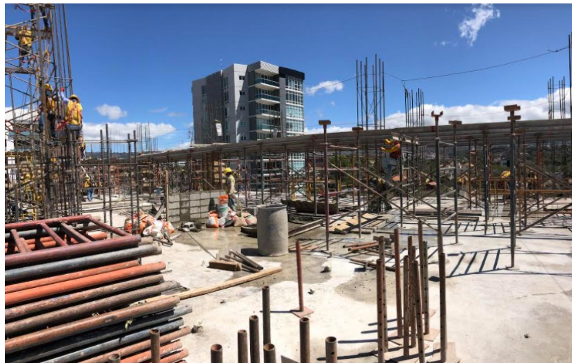
Ilustración 69-Armado de tarima para losa N-10
