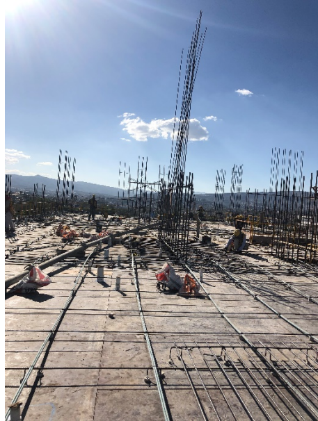
Ilustración 46-Colado de columnas y muros restantes de losa N-06
