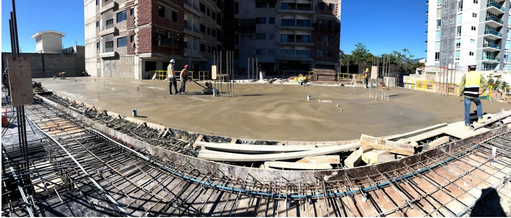
Ilustración 19-Colado de la primera parte de la losa N-04
