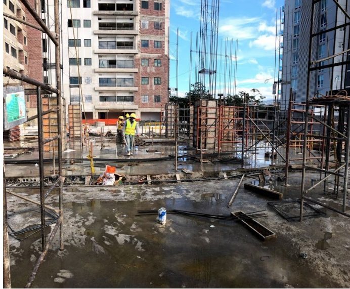
Ilustración 23-Encofrado de elementos en la losa N-04
