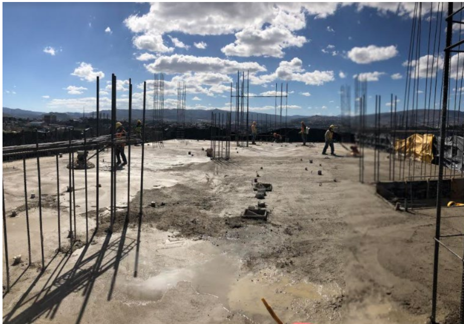
Ilustración 67-Uso de allanadoras en losa N-09
