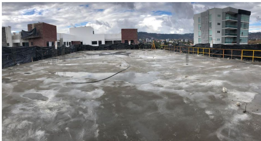
Ilustración 87-Colado de losa N-12
