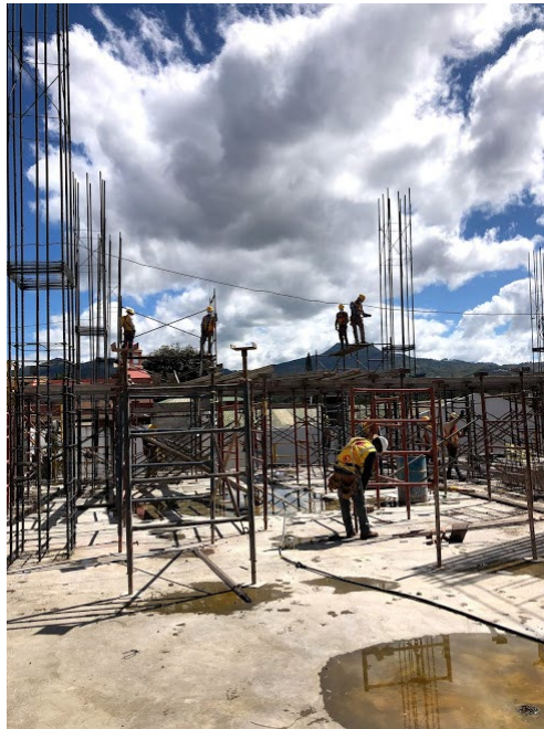
Ilustración 24-Avance en armado de tarima para la losa N-05
