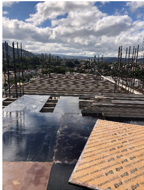
Ilustración 34-Avance en tarima de losa N-06
