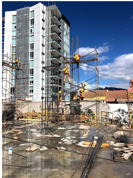
Ilustración 22-Montaje de andamios para empalmes en primera parte de la losa N-04
