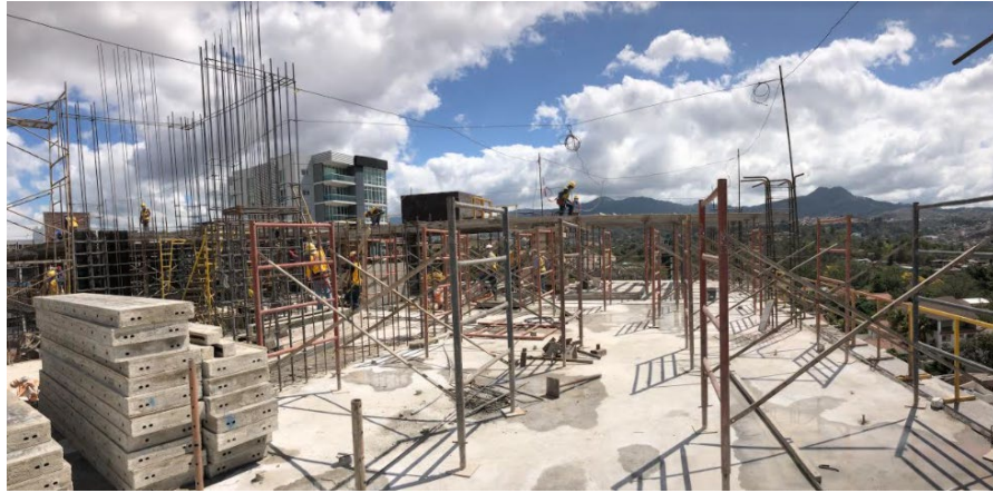
Ilustración 83-Cotinación de armado de tarima para losa N-12
