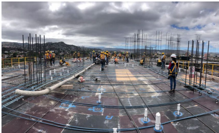
Ilustración 72-Avance en armado de tarima para losa N-10
