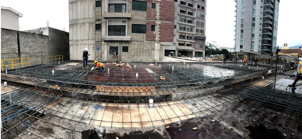
Ilustración 17-Primer parte de losa N-04 lista para ser colada
