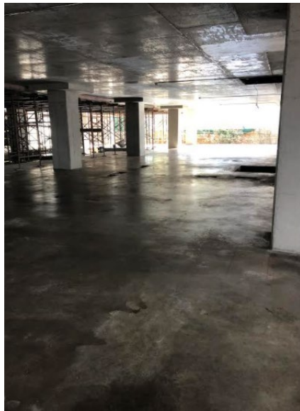
Ilustración 65-Acabado con Ashford en losa E-03
