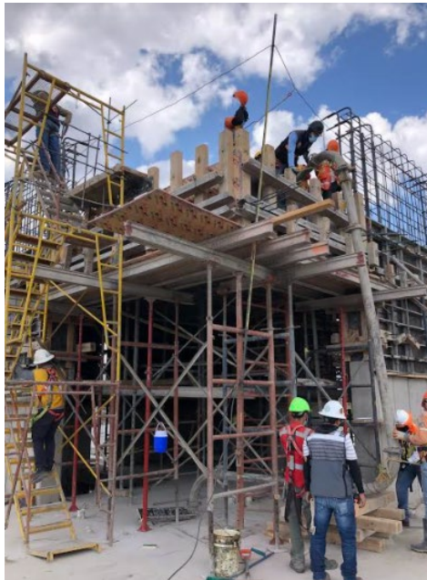
Ilustración 91-Colado de tapadera N-13
