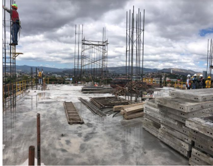
Ilustración 59-Avance para encofrados y armado de tarima
