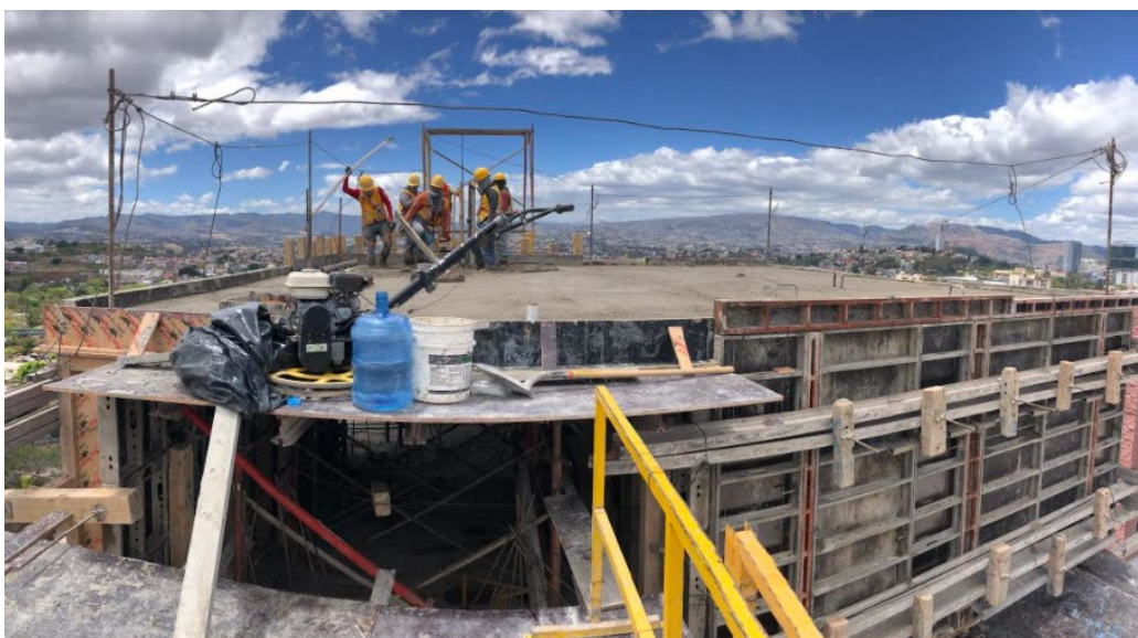
Ilustración 94-Colado de tapadera N-14
