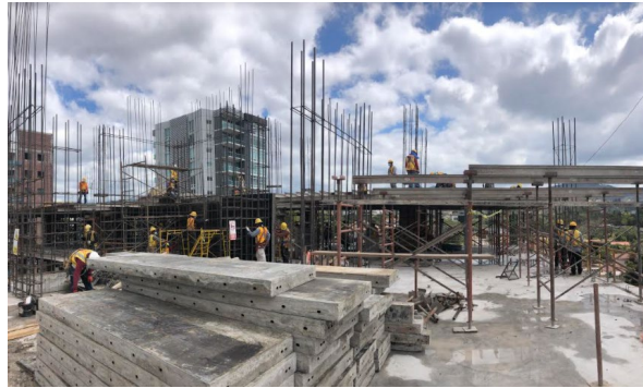
Ilustración 60-Avance en tarima de losa N-09
