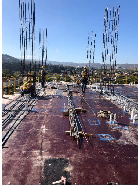
Ilustración 44-Colocación de acero de refuerzo en tarima para losa N-07
