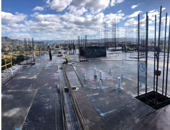
Ilustración 71-Avance en armado de tarima para losa N-10
