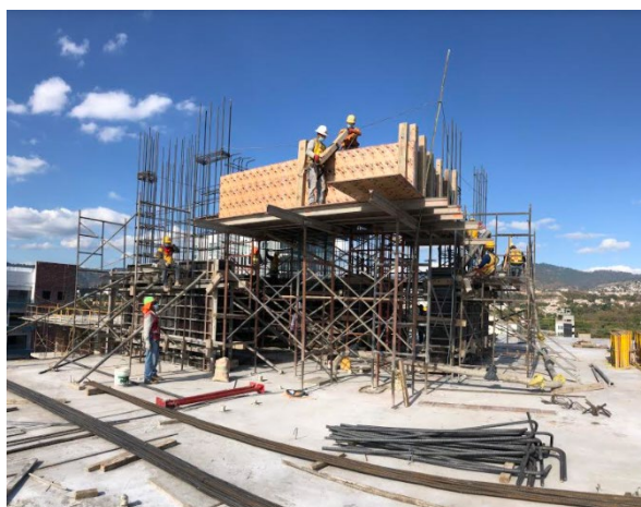
Ilustración 89-Avance en construcción de tarima para tapadera N-13
