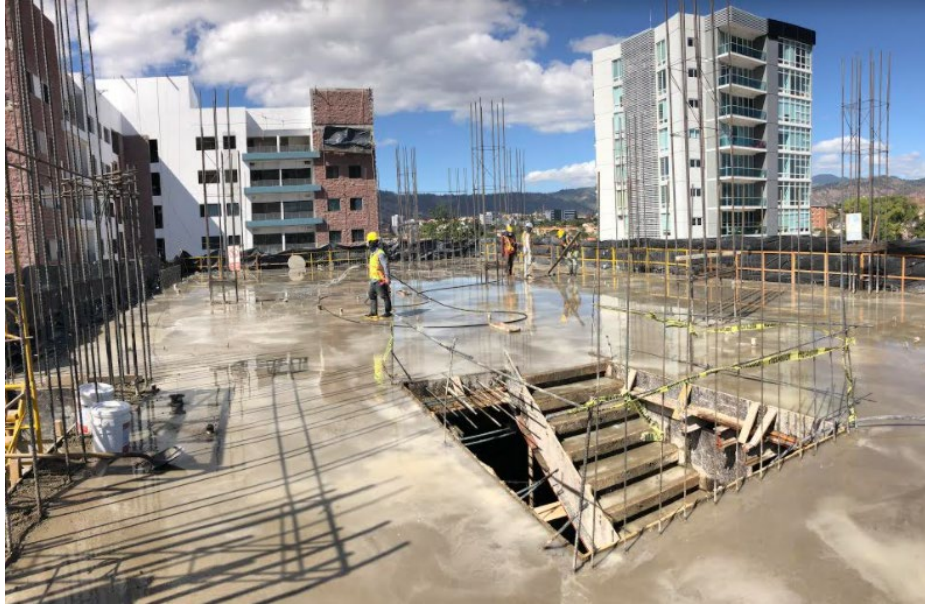
Ilustración 68-Acabado final en losa N-09
