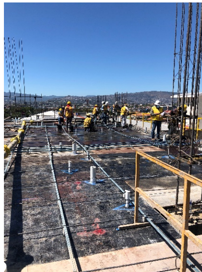
Ilustración 38-Colado de columnas y muros restantes de losa N-05
