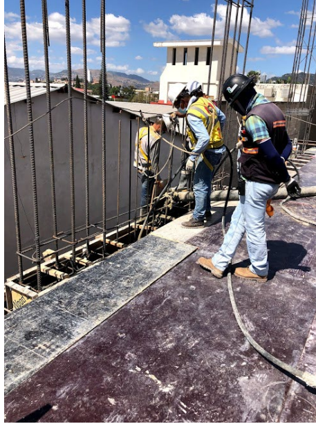
Ilustración 28-Colado de elementos restantes en losa N-04
