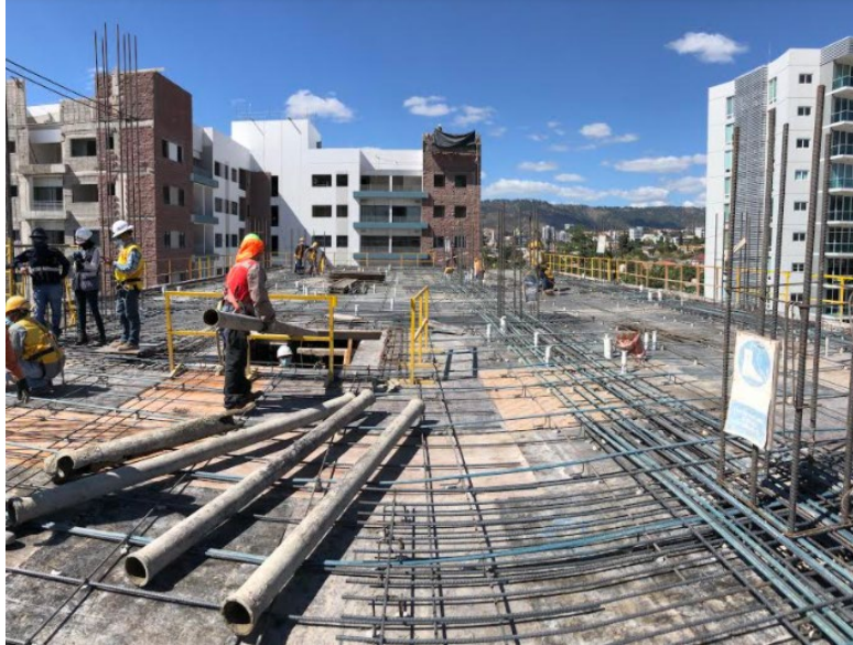
Ilustración 73-Seguimineto de armado de tarima en losa N-10
