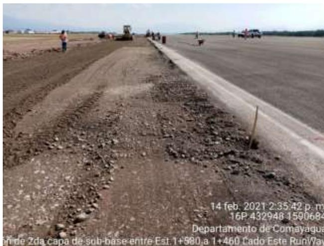
**Ilustración 55. Conformación de segunda capa de sub-base**
