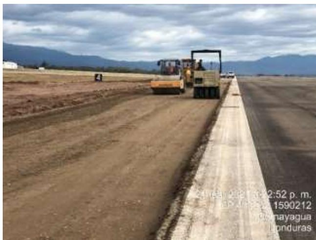
**Ilustración 61. Conformación de sub-base**
