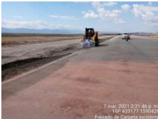
**Ilustración 73. Fresado de carpeta existente**
