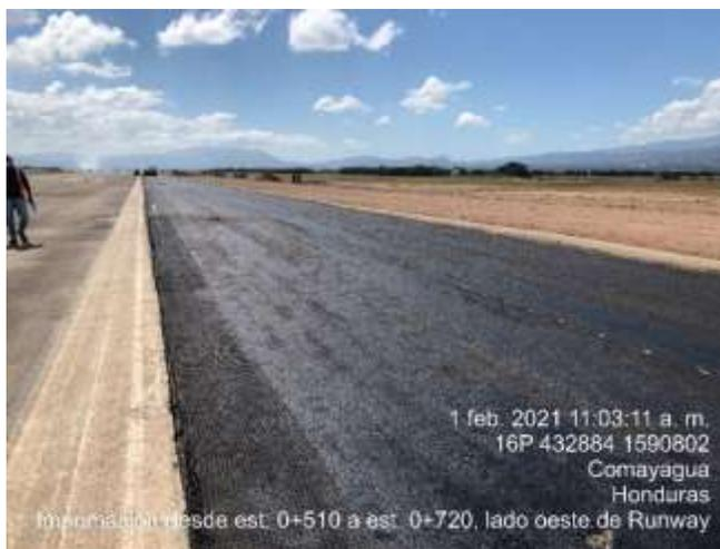
**Ilustración 44. Imprimación de sub-base**
