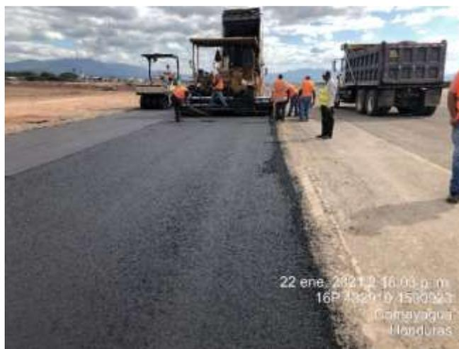
**Ilustración 35. Colocación de carpeta asfáltica**
