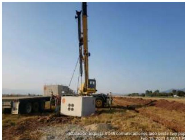
**Ilustración 56. Instalación de caja de registro**
