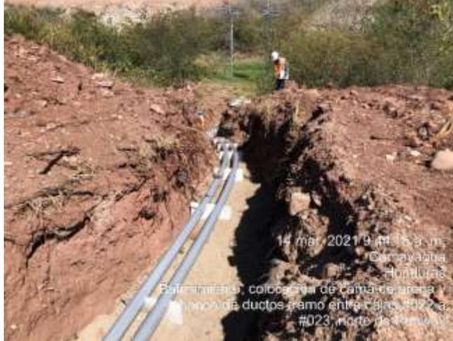
**Ilustración 79. Instalación de banco de ductos**
