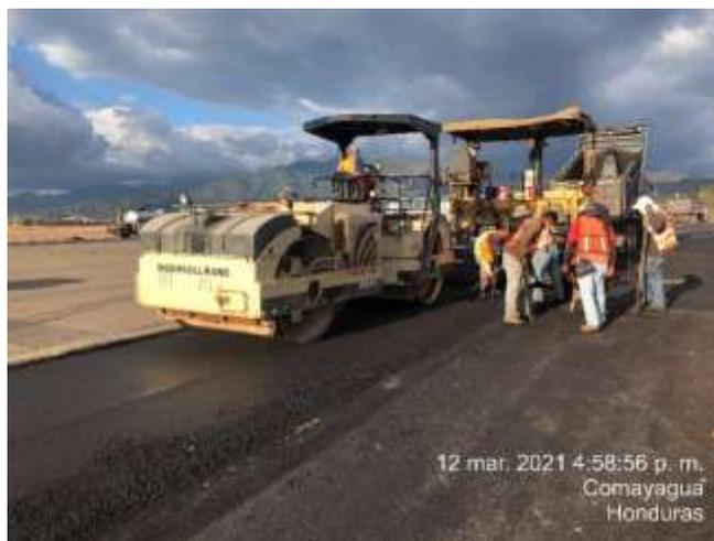
**Ilustración 77. Colocación de mezcla asfáltica**
