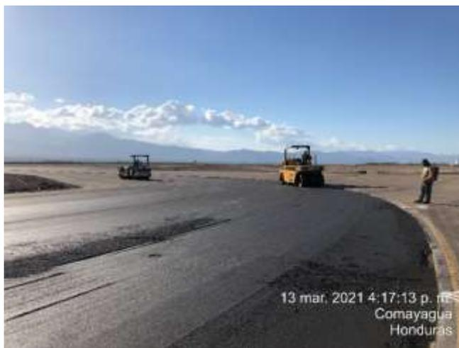
**Ilustración 78. Compactación de mezcla asfáltica**
