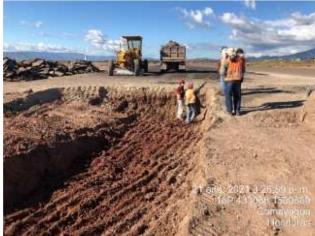
**Ilustración 34. Sub-excavación de sub-rasante**
