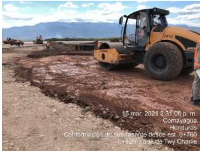
**Ilustración 80. Conformación de sub-rasante**
