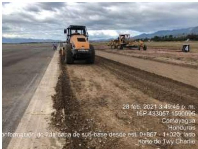
**Ilustración 67. Conformación de sub-base**
