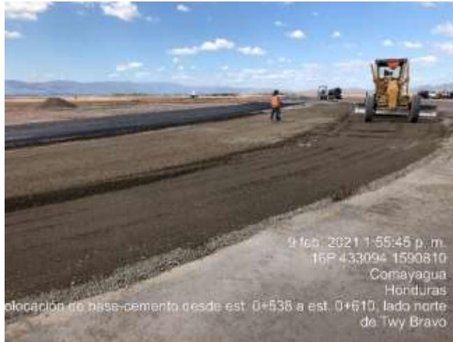
**Ilustración 51. Conformación de base-cemento**
