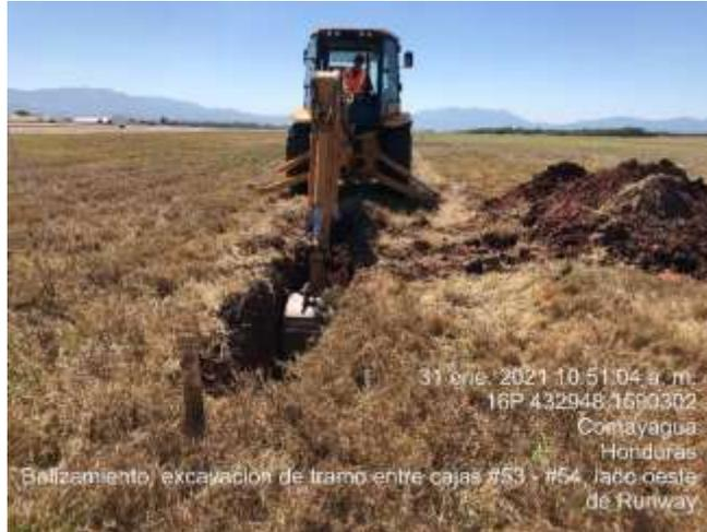
**Ilustración 43. Excavaciones para balizamiento**
