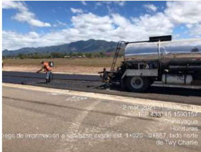
**Ilustración 69. Riego de imprimación**
