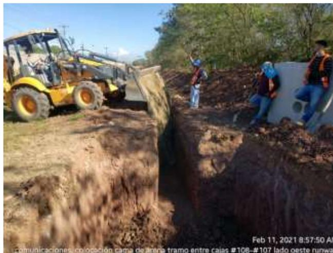
**Ilustración 52. Colocación de cama de arena**
