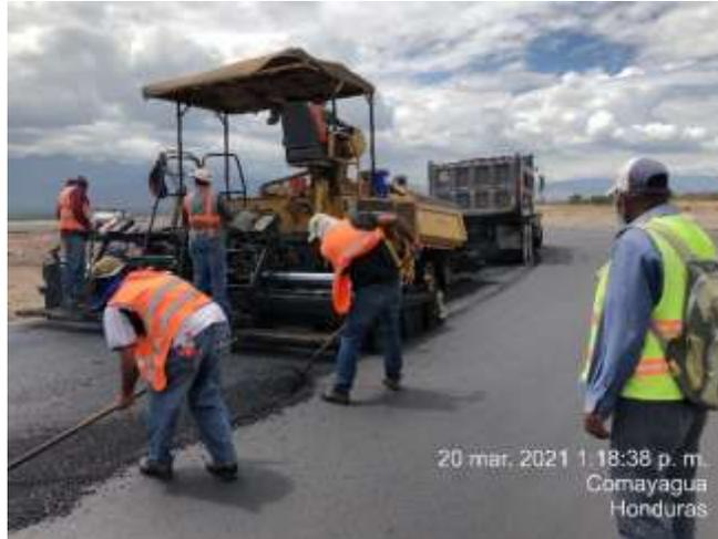
**Ilustración 84. Colocación de mezcla asfáltica**
