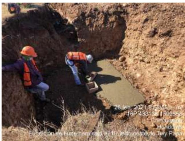
**Ilustración 65. Fundición de firme de concreto**
