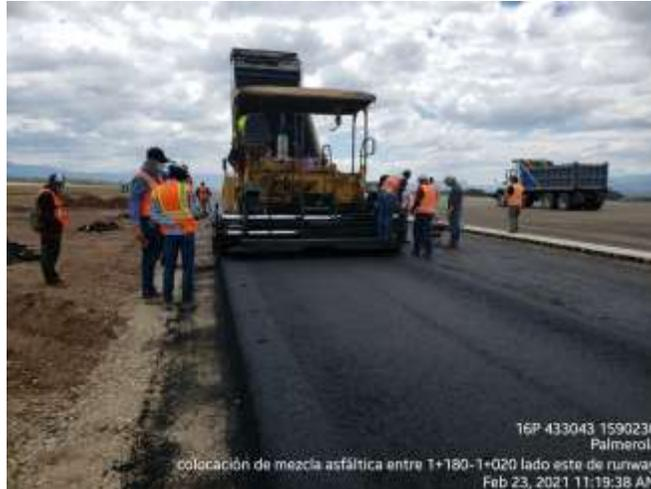
**Ilustración 63. Colocación de mezcla asfáltica**
