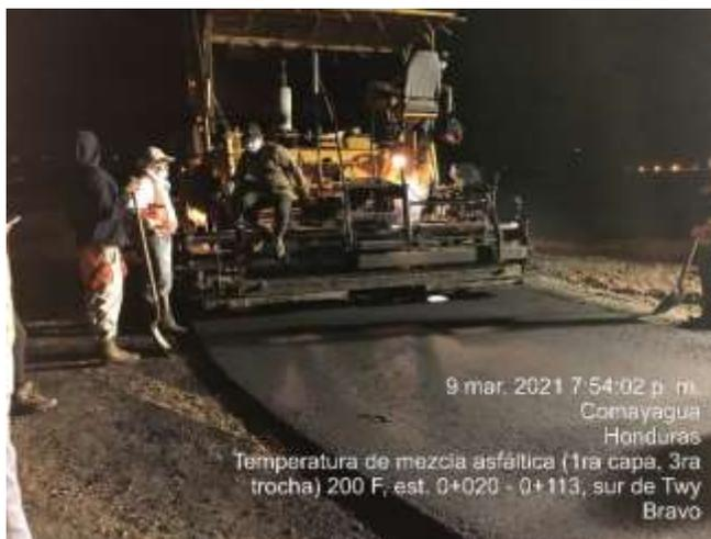
**Ilustración 75. Colocación de mezcla asfáltica**
