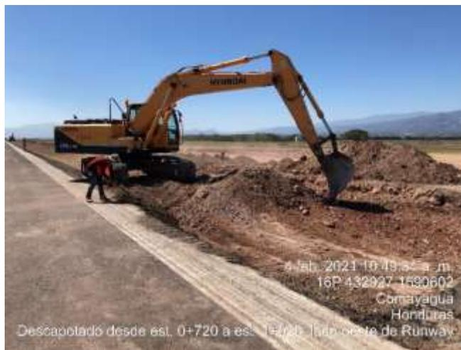
**Ilustración 46. Descapotado de sub-rasante**
