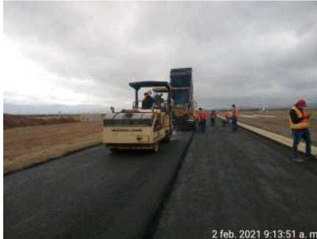
**Ilustración 45. Colocación de mezcla asfáltica**
