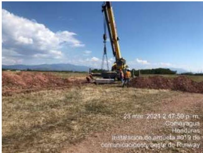
**Ilustración 87. Instalación de caja de registro**
