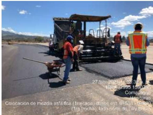
**Ilustración 66. Colocación de mezcla asfáltica**
