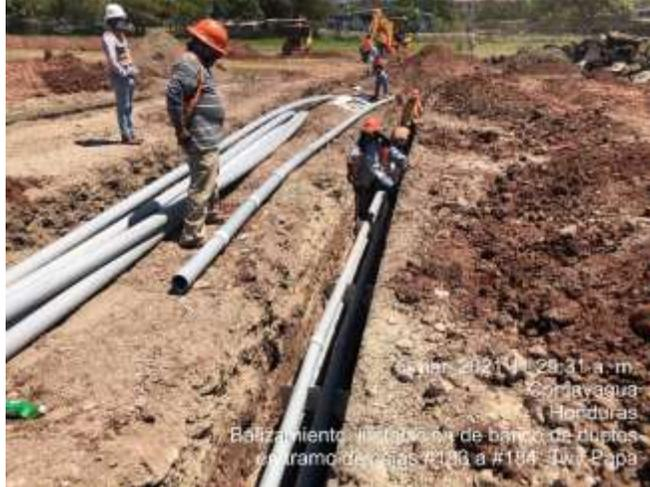
**Ilustración 72. Colocación de banco de ductos**
