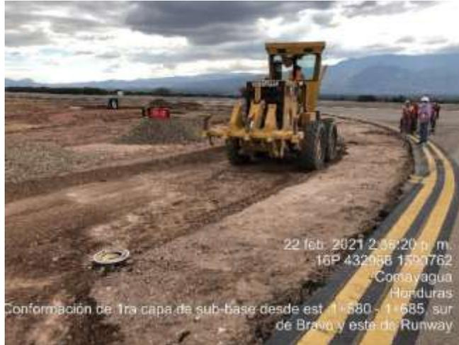
**Ilustración 62. Conformación de sub-base**
