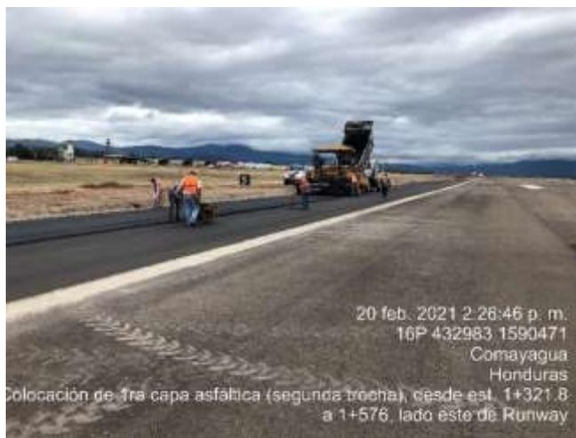
**Ilustración 60. Colocación de mezcla asfáltica**
