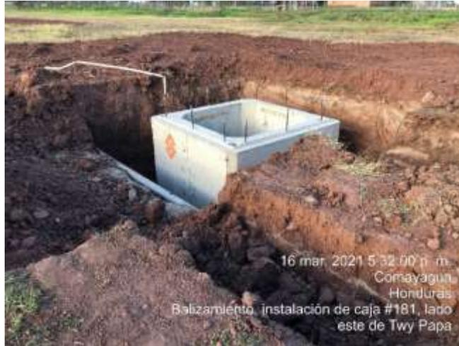
**Ilustración 81. Instalación de caja de registro**
