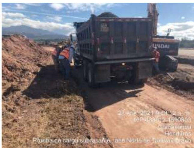
**Ilustración 36. Prueba de carga a sub-rasante**
