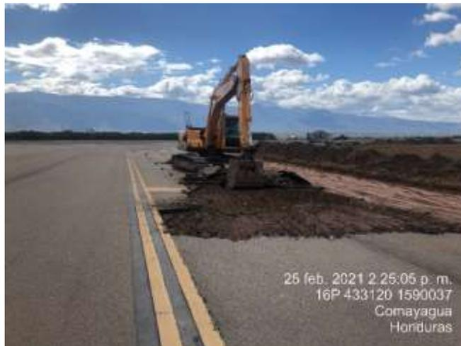
**Ilustración 64. Demolición de carpeta existente**
