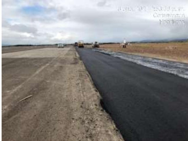
**Ilustración 32. Compactación de carpeta asfáltica**
