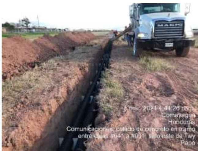
**Ilustración 71. Fundición de banco de ductos**
