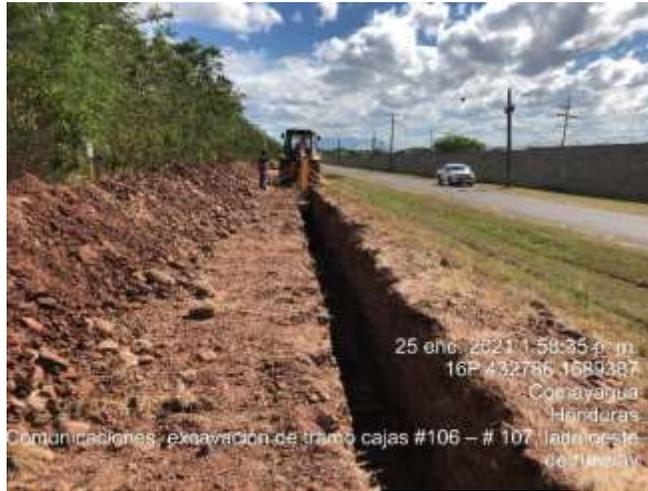
**Ilustración 38. Excavación de tramo de comunicaciones**
