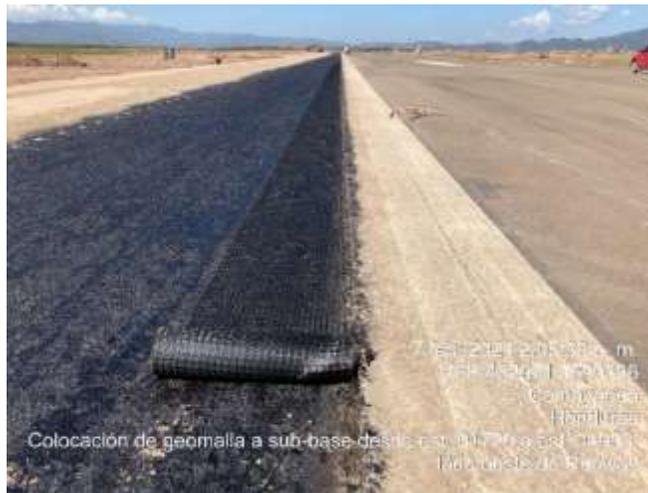
**Ilustración 49. Colocación de geomalla**
