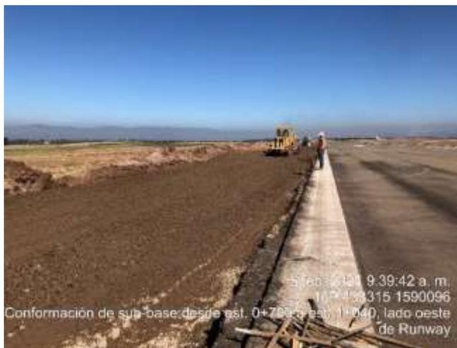
**Ilustración 47. Conformación de sub-base**
