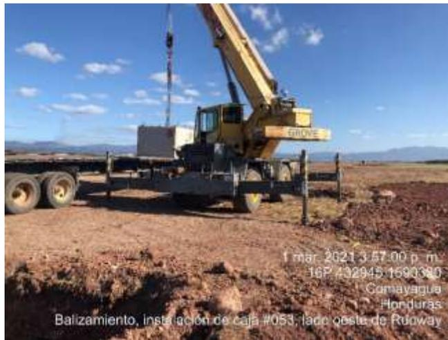
**Ilustración 68. Instalación de caja de registro**
