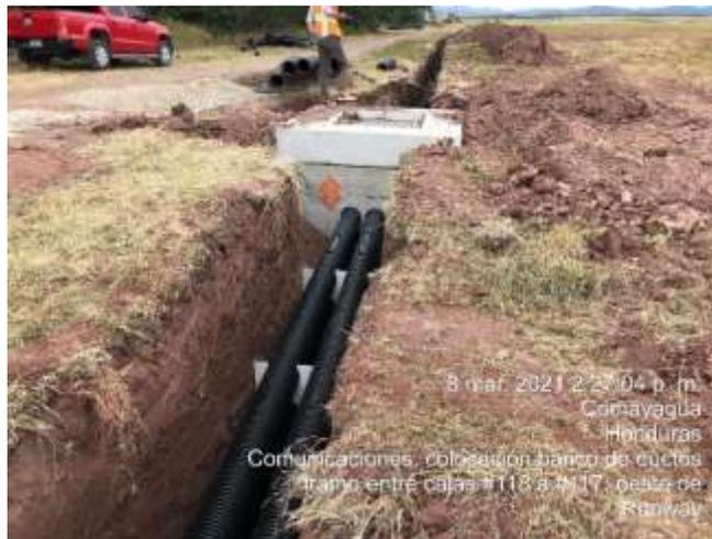
**Ilustración 74. Instalación de banco de ductos**
