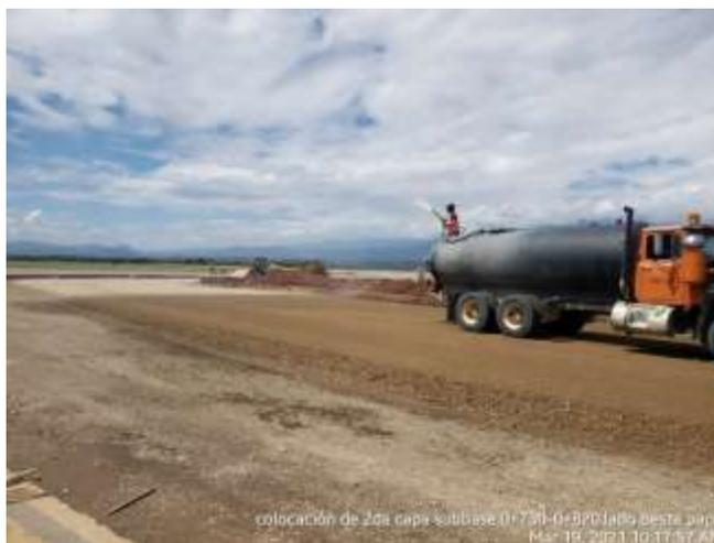
**Ilustración 83. Conformación de sub-base**
