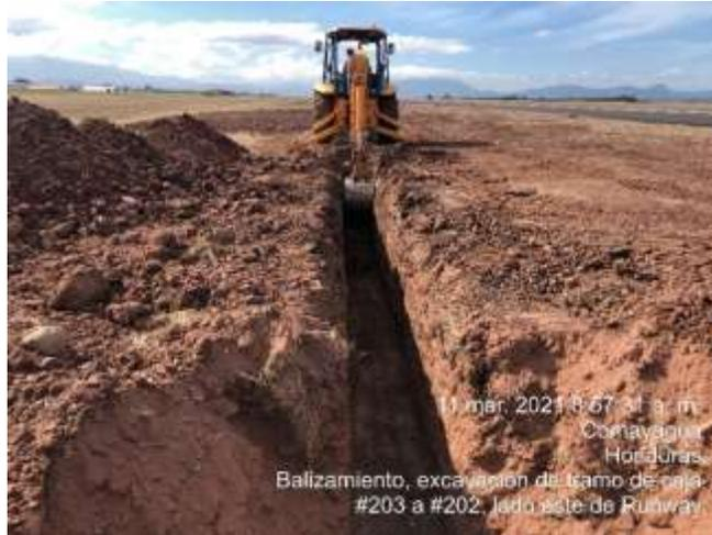
**Ilustración 76. Excavación de tramo de balizamiento**
