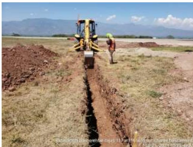
**Ilustración 88. Excavación de tramo de balizamiento**
