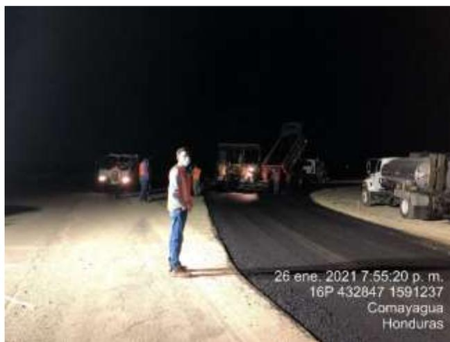
**Ilustración 39. Colocación de carpeta asfáltica**
