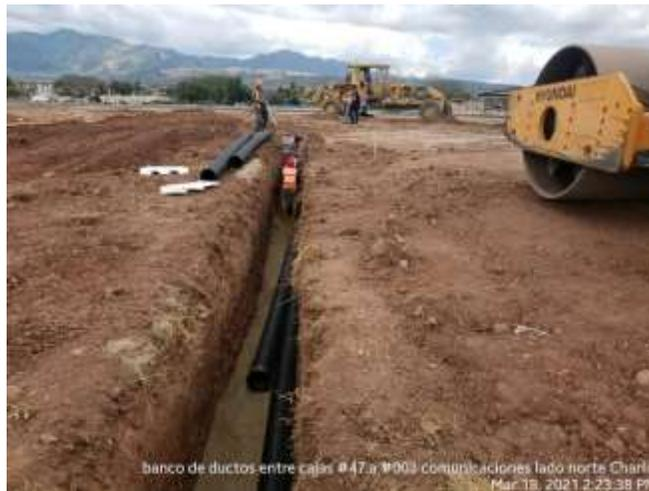
**Ilustración 82. Instalación de banco de ductos**
