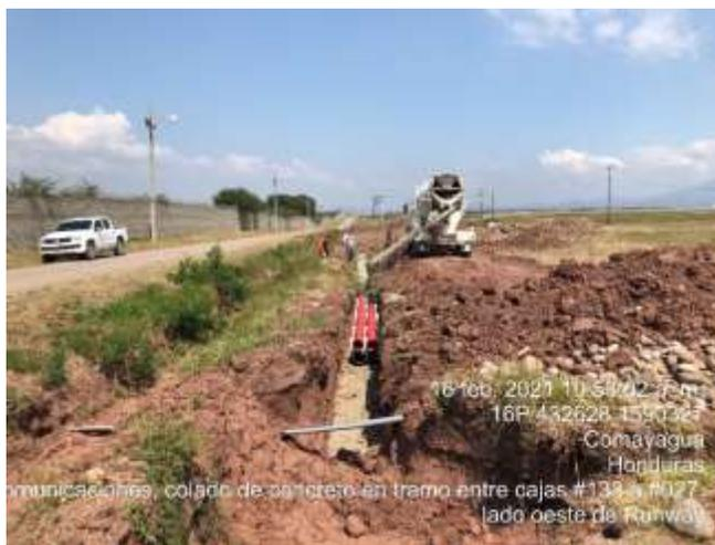
**Ilustración 57. Fundición de banco de ductos**
