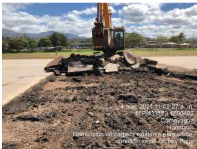
**Ilustración 70. Demolición de carpeta existente**
