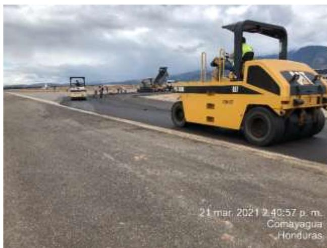
**Ilustración 85. Compactación de mezcla asfáltica**
