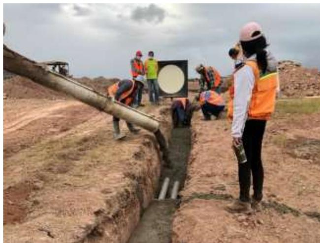
**Ilustración 33. Fundición de tramo de balizamiento**
