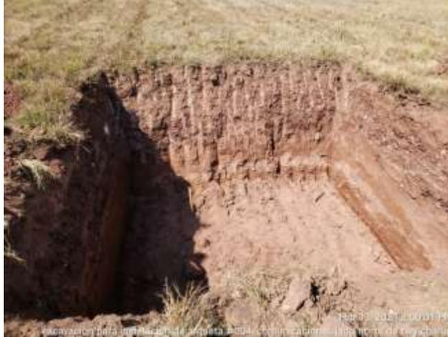
**Ilustración 54. Excavación para caja de registro de comunicaciones**
