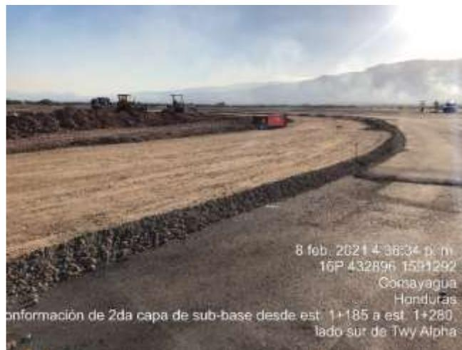
**Ilustración 50. Conformación de sub-base**
