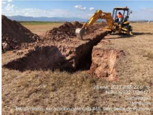
**Ilustración 41. Excavaciones para balizamiento**
