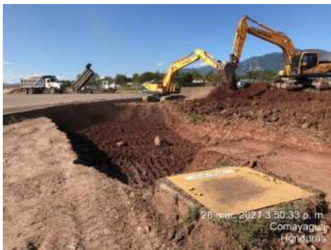
**Ilustración 89. Sub-excavación de sub-rasante**
