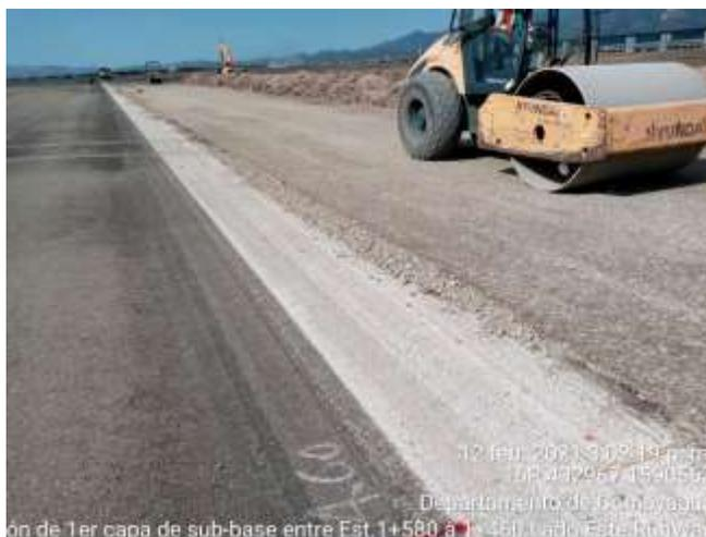
**Ilustración 53. Conformación de sub-base (Primera capa)**
