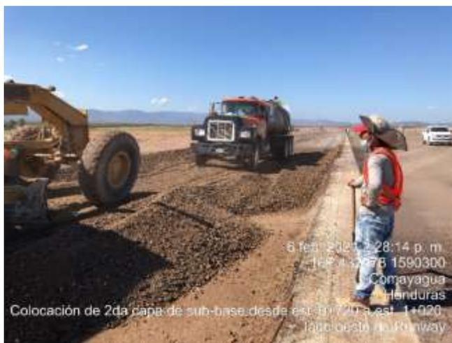
**Ilustración 48. Conformación de sub-base**
