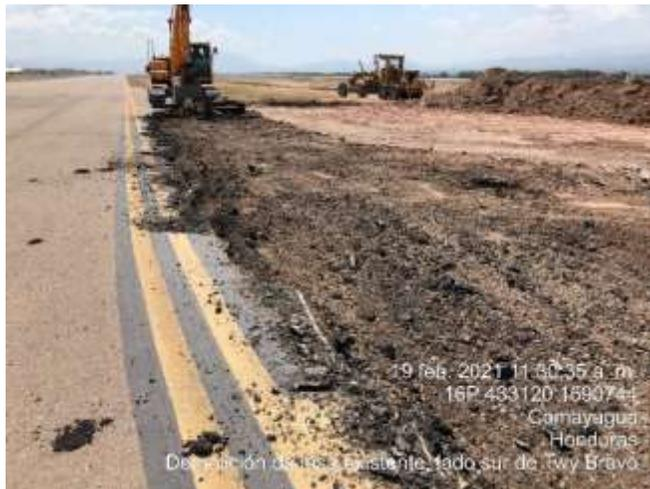
**Ilustración 59. Demolición de losa existente**
