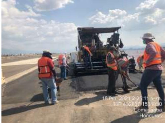
**Ilustración 58. Colocación de mezcla asfáltica**
