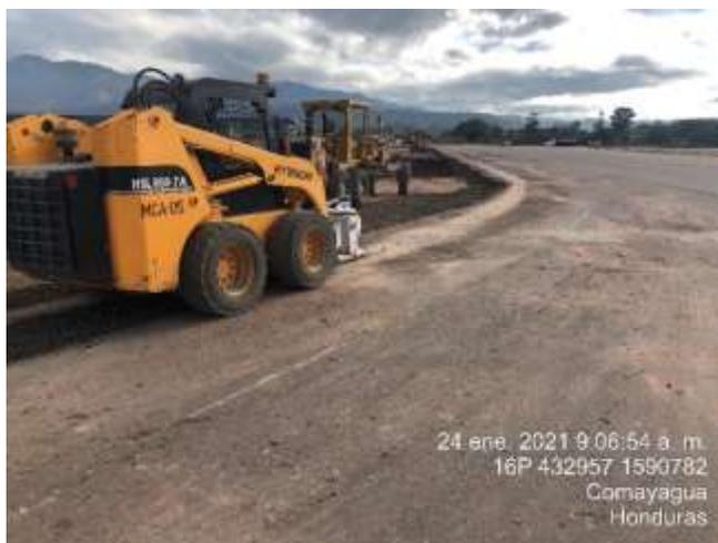
**Ilustración 37. Fresado de carpeta asfáltica existente**
