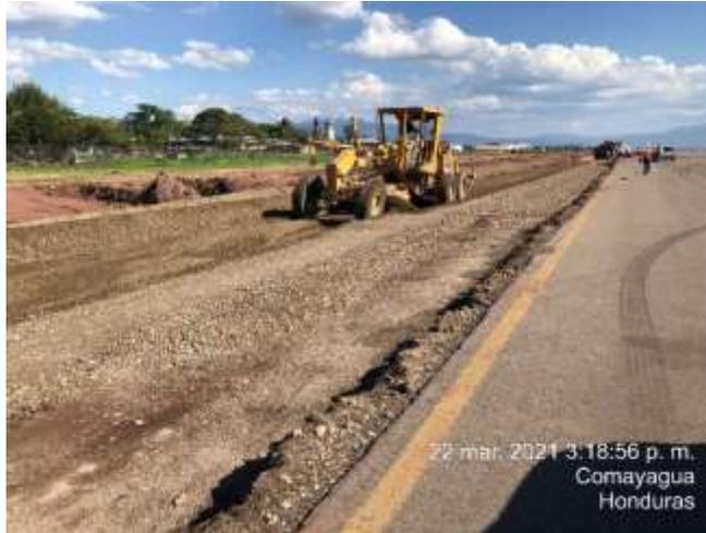
**Ilustración 86. Conformación de sub-base**
