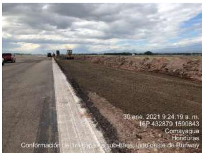
**Ilustración 42. Conformación de sub-base**
