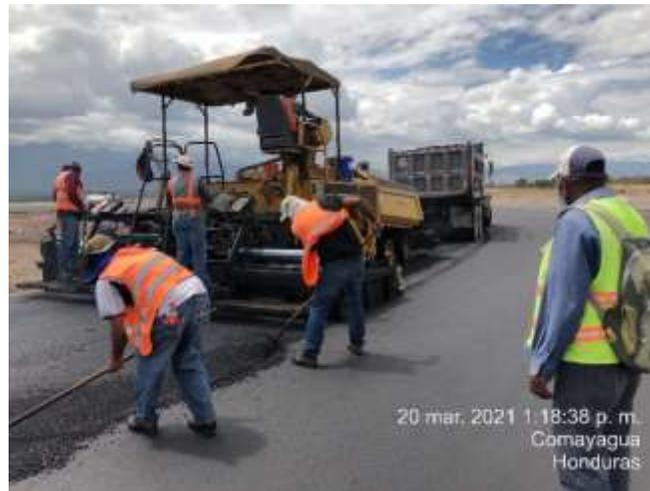
**Ilustración 91. Colocación de mezcla asfáltica**
