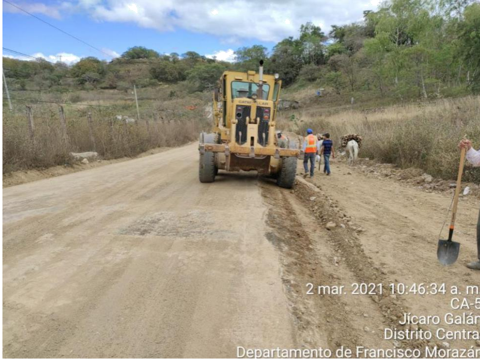
Ilustración 43. Afinamiento de tramo y perfilación de cunetas desde la est.1+040 a est.1+140
