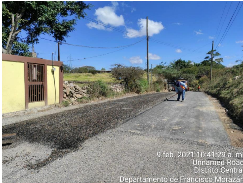
Ilustración 28. Aplicación de doble tratamiento sobre tramo, desde la estación 0+420 hasta la estación 0+592
