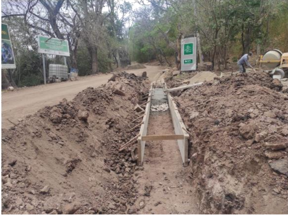
Ilustración 65. Fundición de base para cuneta con concreto 3000 psi
