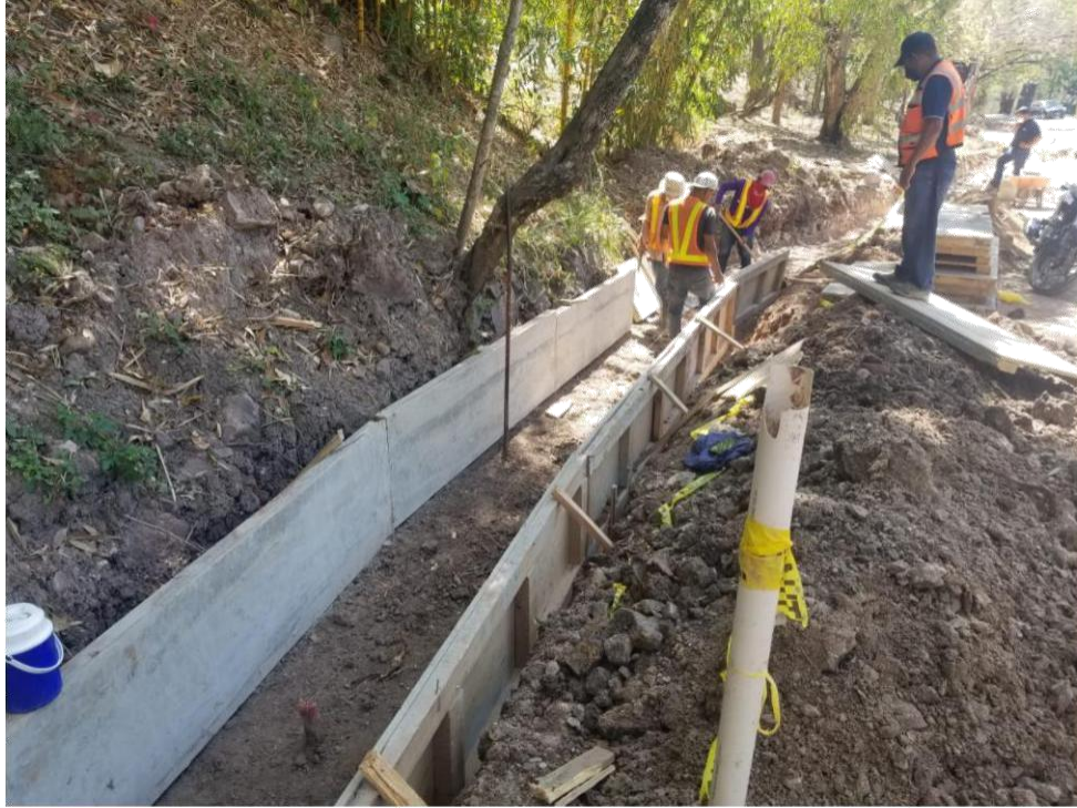
Ilustración 26. Colocación de encofrado para cunetas de concreto ciclópeo
