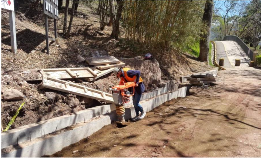
Ilustración 61. Compactación de material selecto para relleno de cuneta, desde la est.0+350 a la est.0+400
