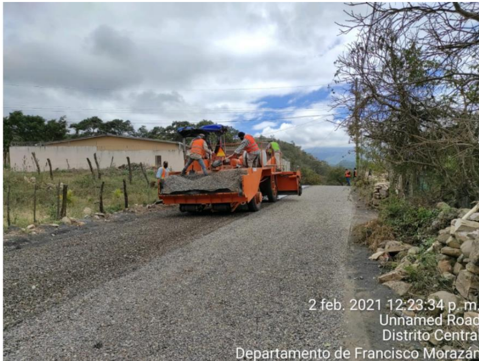
Ilustración 23. Aplicación de doble tratamiento de la estación 0+004 a la estación 0+198
