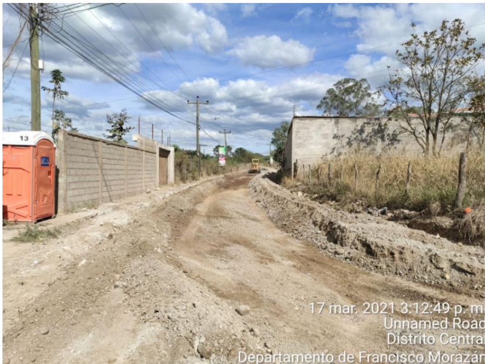
Ilustración 53. Mezcla en seco de material suelo-cemento sobre tramo, desde la est.1+550 hasta la est.1+710
