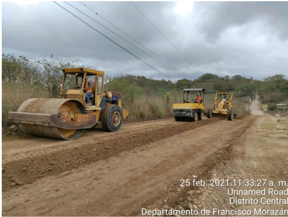
Ilustración 41. Estabilización y afinamiento del tramo, desde la estación 0+940 hasta la estación 1+040
