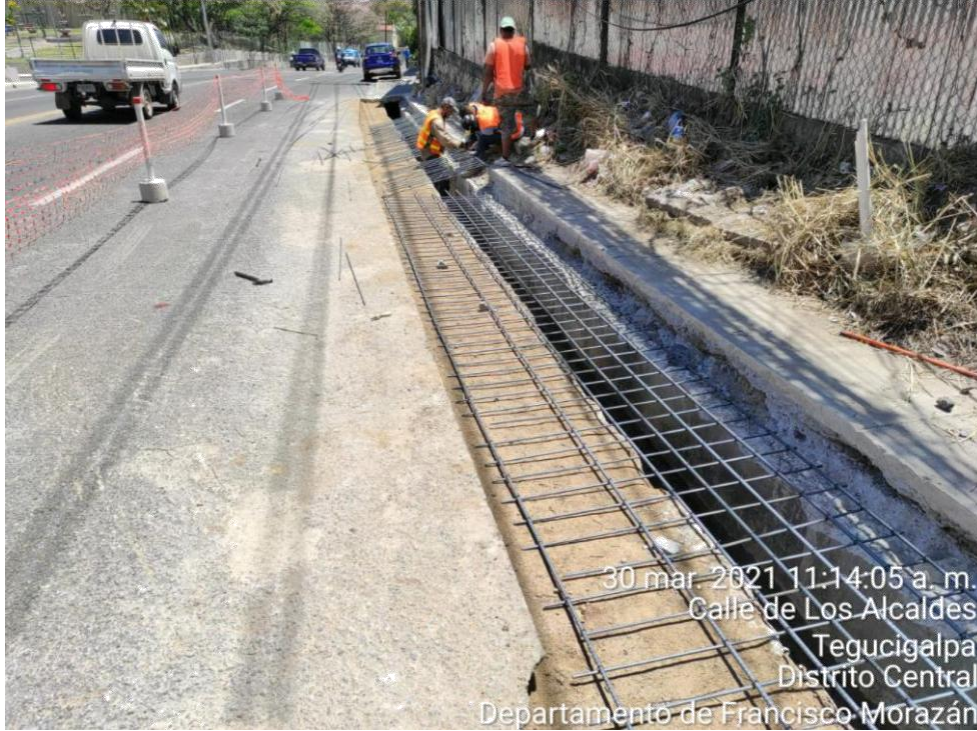
Ilustración 63. Arreglo de acero sobre ampliación de carril en la Calle los Alcaldes
