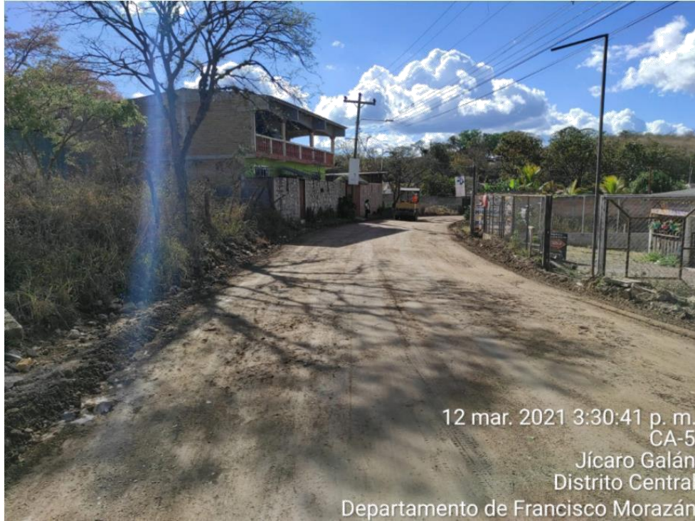
Ilustración 50. Afinamiento de tramo estabilizado con el 3% de cemento desde la estación 1+410 a 1+560
