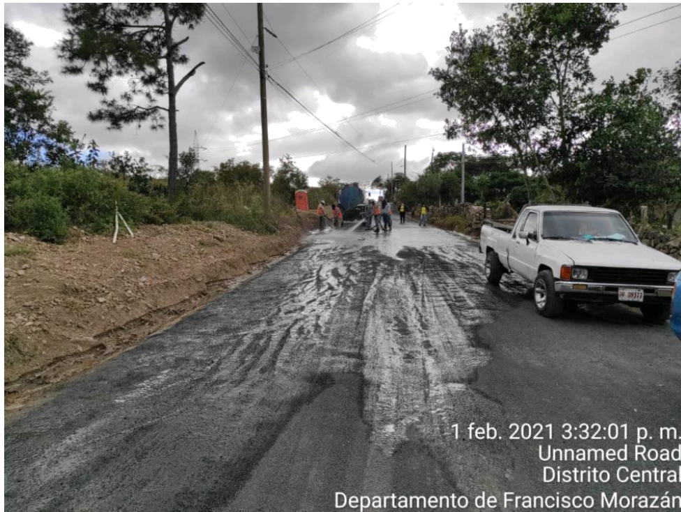
Ilustración 22. Limpieza y remoción del suelo desde la estación 0+004 hasta la estación 0+600
