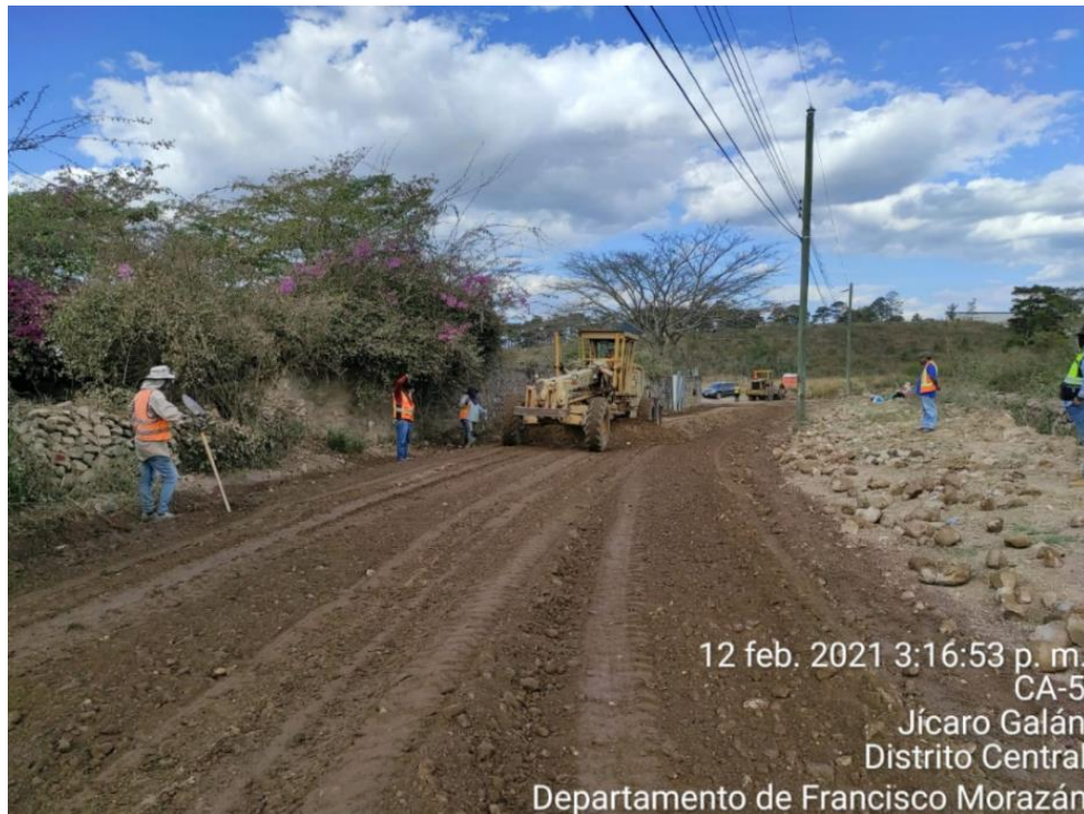
Ilustración 31. Estabilización de tramo con el 2% y 3%
