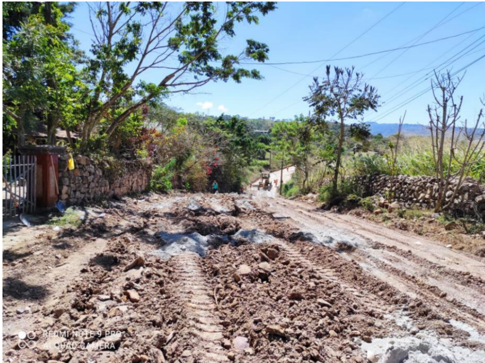
Ilustración 19. Estabilización del tramo, desde la estación 0+495 hasta estación 0+600
