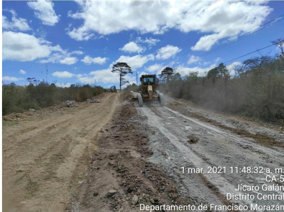
Ilustración 42. Estabilización de subbase con cemento, desde la est.1+040 a est.1+140
