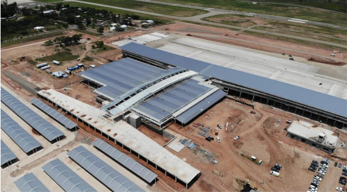
Ilustración 2. Supervisión Aeropuerto Internacional de Palmerola, Comayagua.
