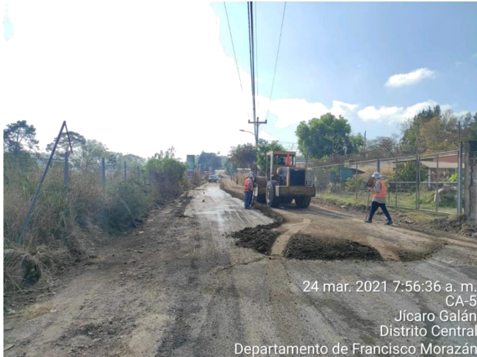
Ilustración 58. Afinamiento de tramo estabilizado, desde la estación 1+710 a la estación 1+890
