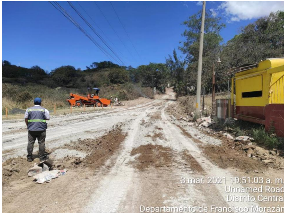
Ilustración 44. Estabilización con el 3% de cemento de tramo, desde la est. 1+140 a est.1+260
