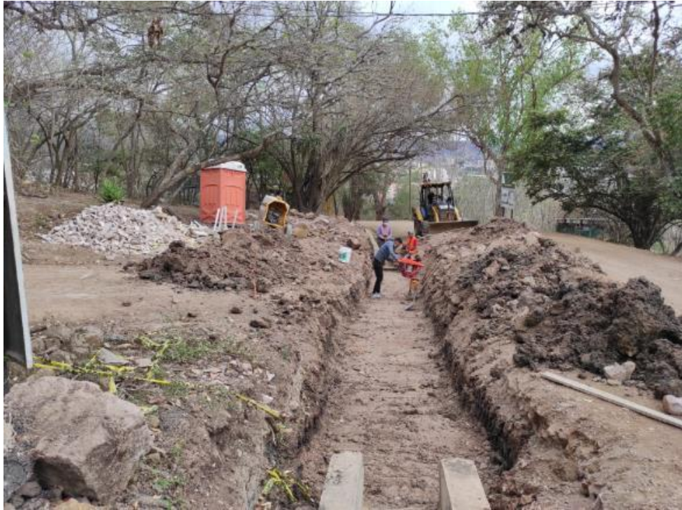
Ilustración 64. Compactación de suelo para cuneta sobre segundo acceso al SANAA
