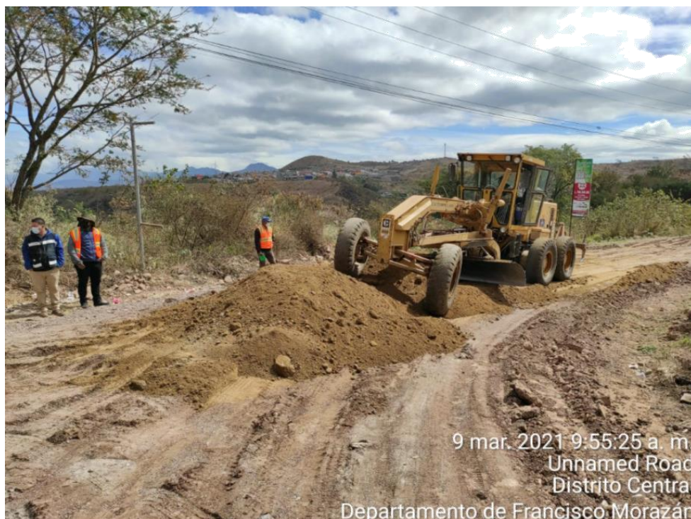
Ilustración 47. Tendido de material selecto sobre tramo desde la est.1+330 a est. 1+360
