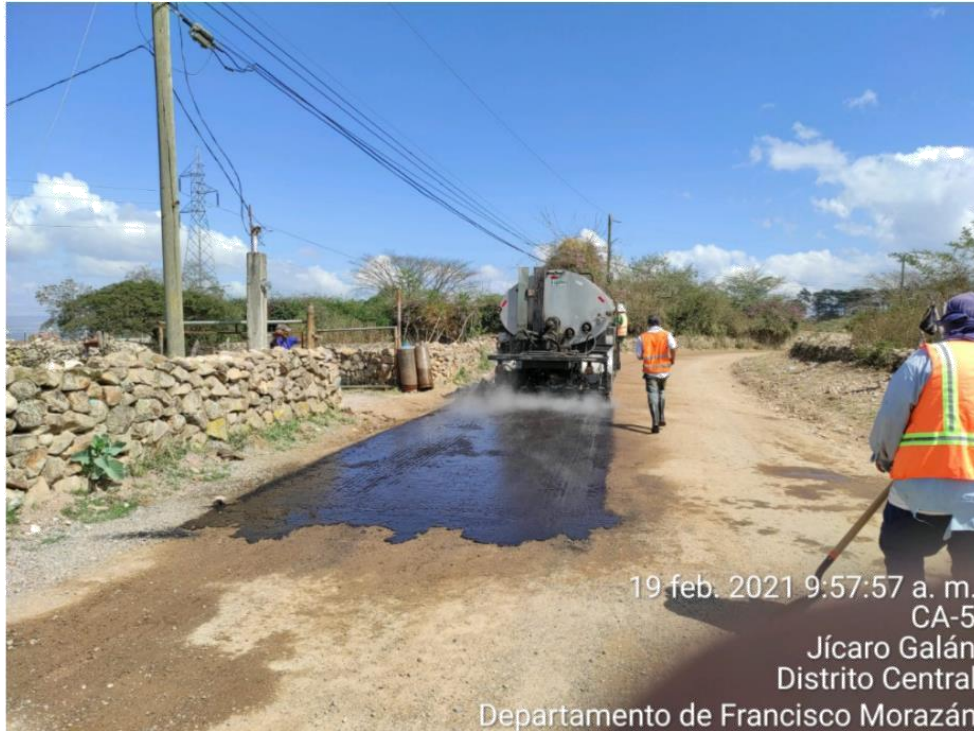
Ilustración 36. Imprimación de protección sobre superficie est. 0+600 a est. 0+850
