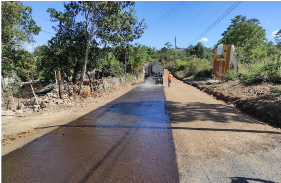
Ilustración 21. Imprimación sobre el tramo, desde la estación 0+350 hasta la estación 0+600
