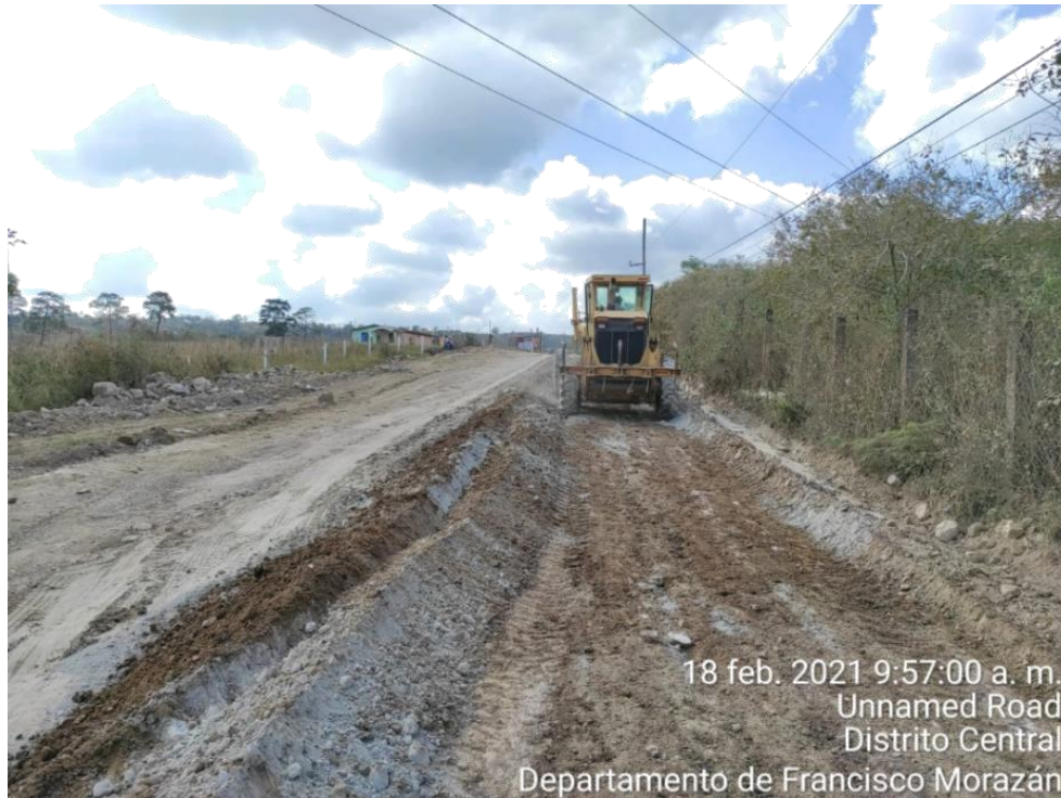
Ilustración 35. Estabilización de subbase con el 3% de cemento, est. 0+850 a est. 0+940
