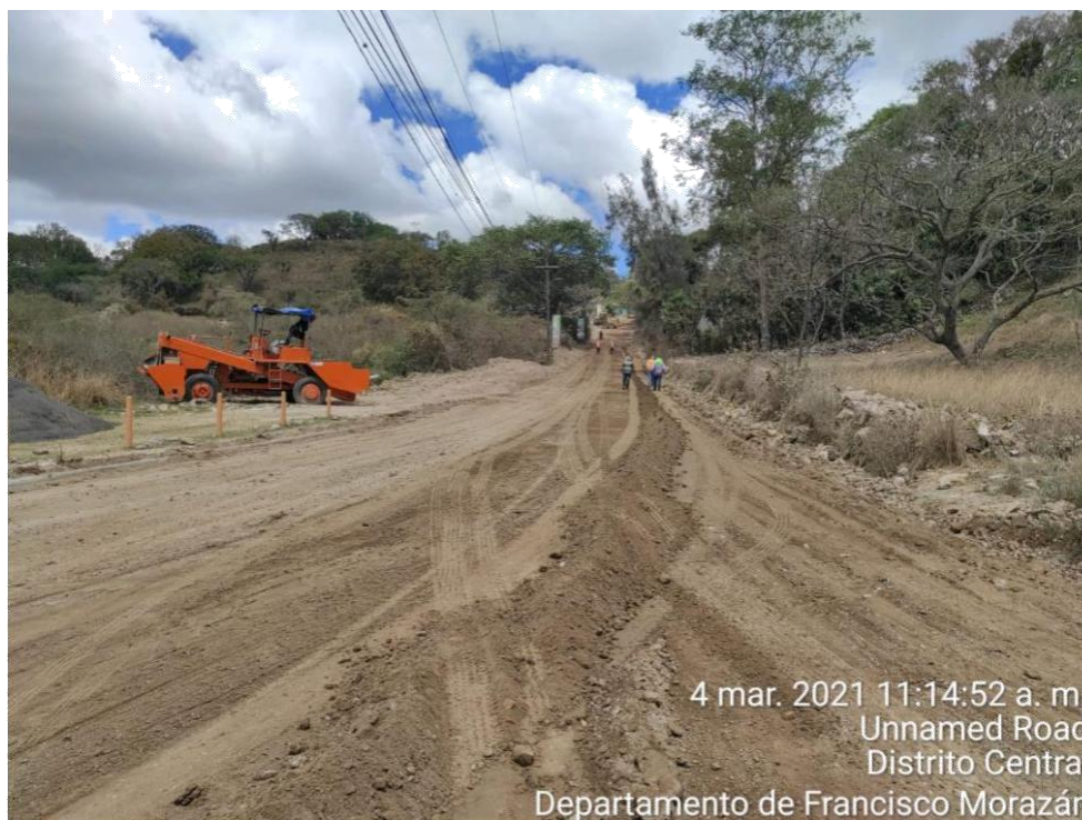
Ilustración 45. Afinamiento de tramo estabilizado, desde la est. 1+140 a est.1+260
