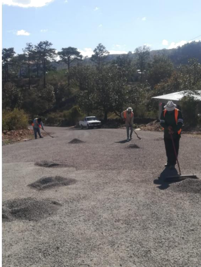
Ilustración 29. Limpieza y barrido de agregado de 3/8 suelto
