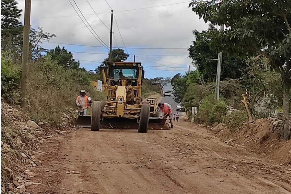
Ilustración 18. Nivelación de subbase del tramo 0+400 hasta 0+490
