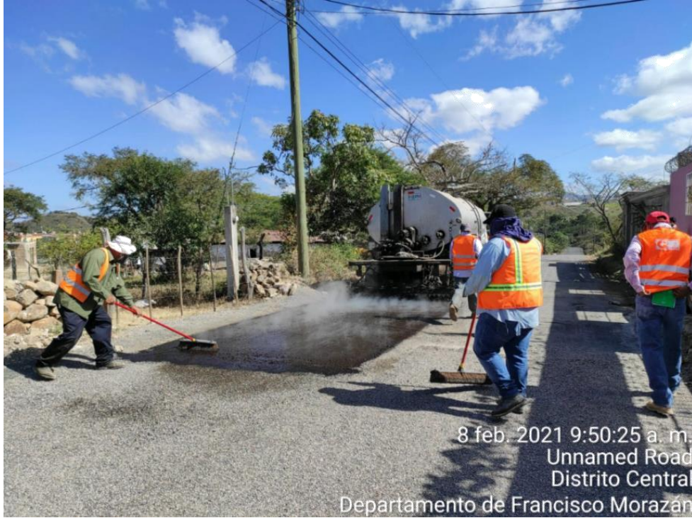
Ilustración 27. Aplicación de doble tratamiento de la estación 0+198 a la estación 0+420
