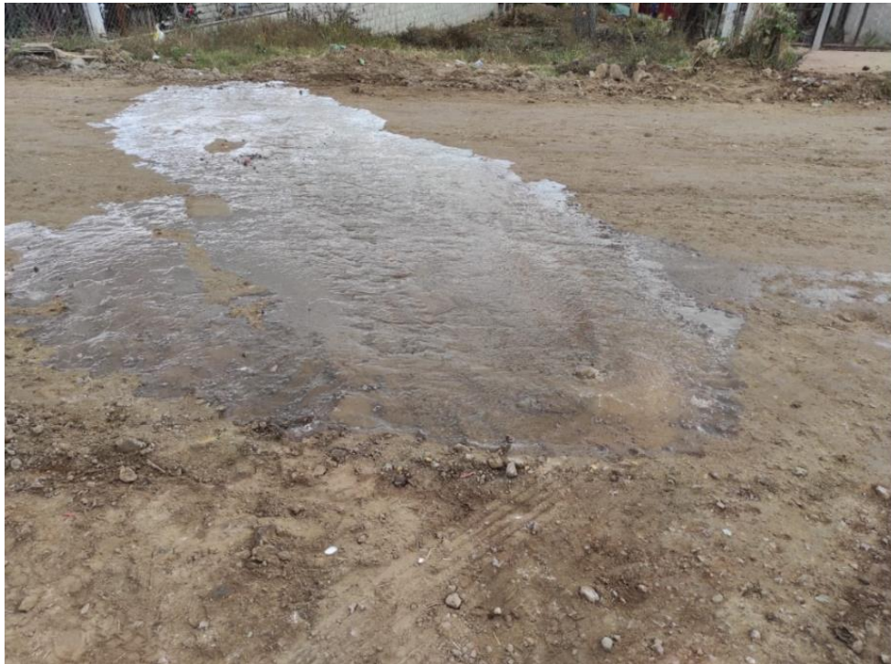
Ilustración 51. Reparación de tubería de 1/2 pulgada sobre la estación 1+445
