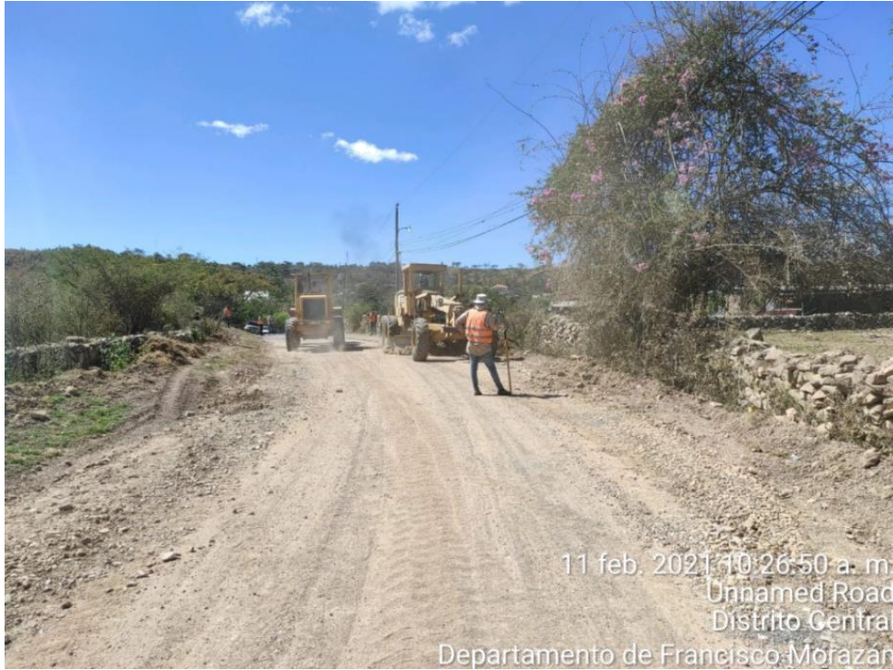
Ilustración 30. Conformación o nivelación de tramo previo a la estabilización
