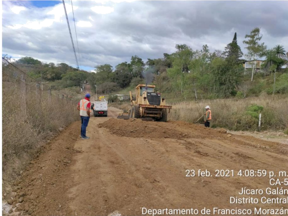
Ilustración 39. Colocación y tendido de material selecto sobre las estaciones 0+940 hasta la estación 1+040
