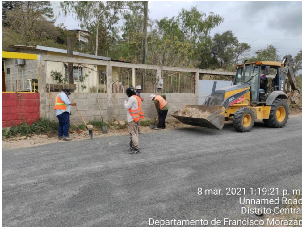
Ilustración 46. Limpieza de material de desperdicio sobre cunetas desde la est. 1+140 a est. 1+260
