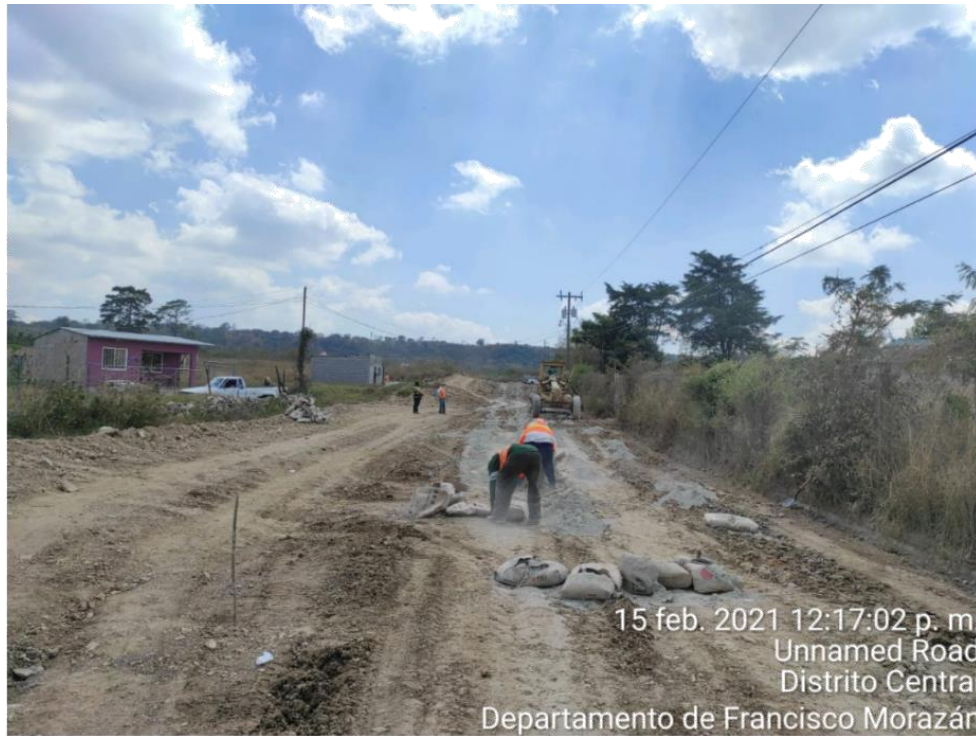
Ilustración 32. Estabilización de subbase con el 3% cemento, est. 0+700 a est.0+850
