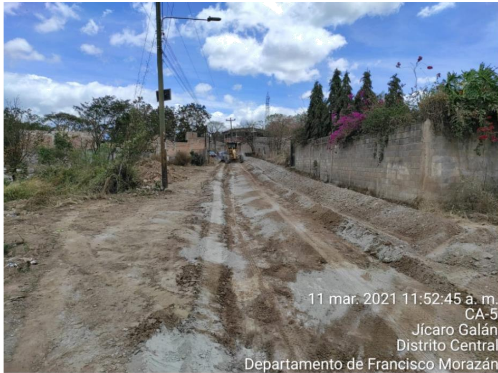
Ilustración 49. Estabilización de tramo con el 3% de cemento, desde la est.1+410 a est.1+550
