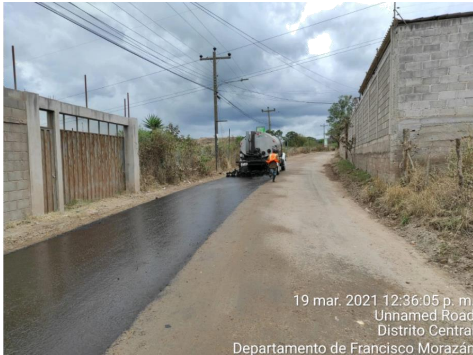
Ilustración 55. Imprimación de trocha lado izquierdo con emulsión desde la estación 1+545 a 1+705
