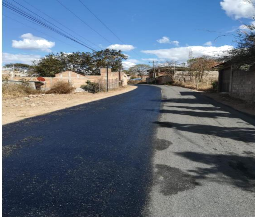
Ilustración 52. Imprimación de tramo con emulsión asfáltica desde la est. 1+260 hasta la est.1+545
