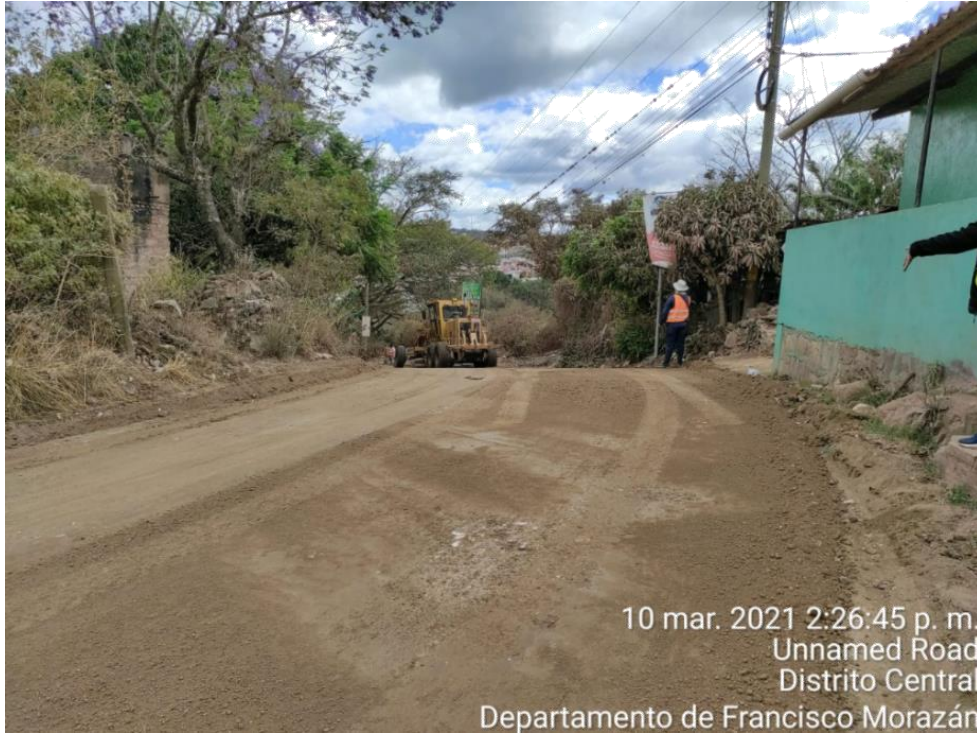
Ilustración 48. Afinamiento de tramo estabilizado desde la est. 1+260 hasta la est.1+410
