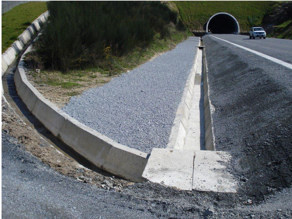
Ilustración 15 Estructuras de drenaje.
