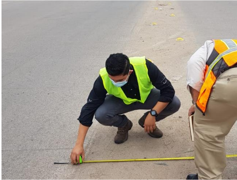
Ilustración 32 Medición de Mediana de pintura termoplástica existente.
