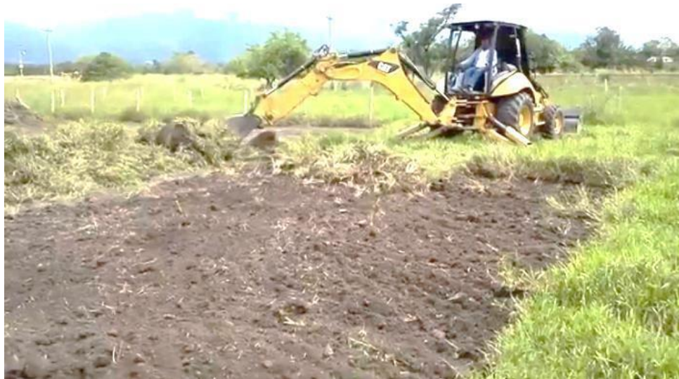
Ilustración 19-Limpieza de terreno con equipo
