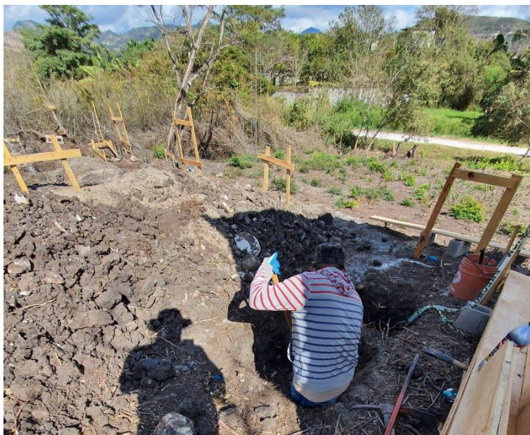
Ilustración 56-Excavación de zapata
