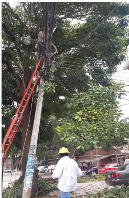
Ilustración 12-Reparación de alumbrado público
