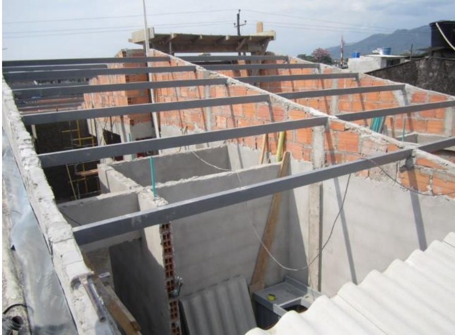
Ilustración 29-Instalación de estructura de techo
