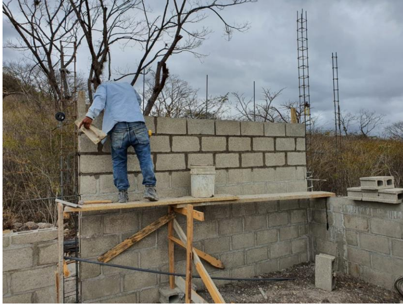
Ilustración 79-Levantamiento de pared de bloque reforzado
