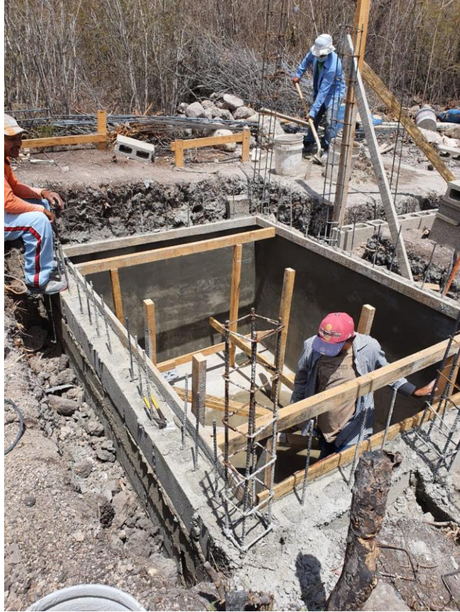
Ilustración 77-Encofrado para losa de cisterna
