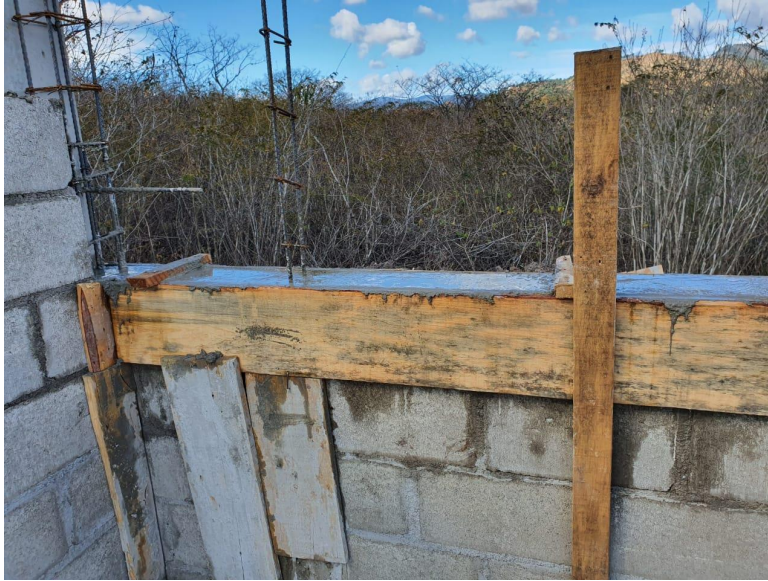
Ilustración 73-Fundición de batiente de ventana
