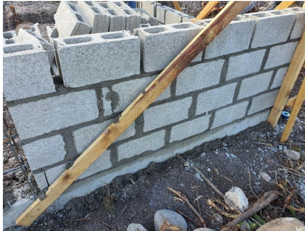
Ilustración 65-Levantamiento de pared de bloque reforzado
