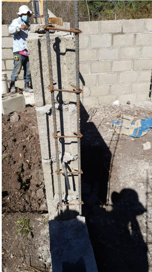
Ilustración 67-Levantamiento de pared y jamba de 10 x 15 cm
