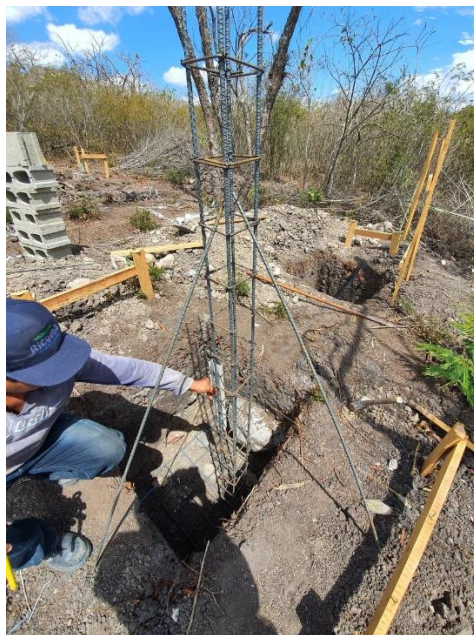
Ilustración 53-Colocación de castillos
