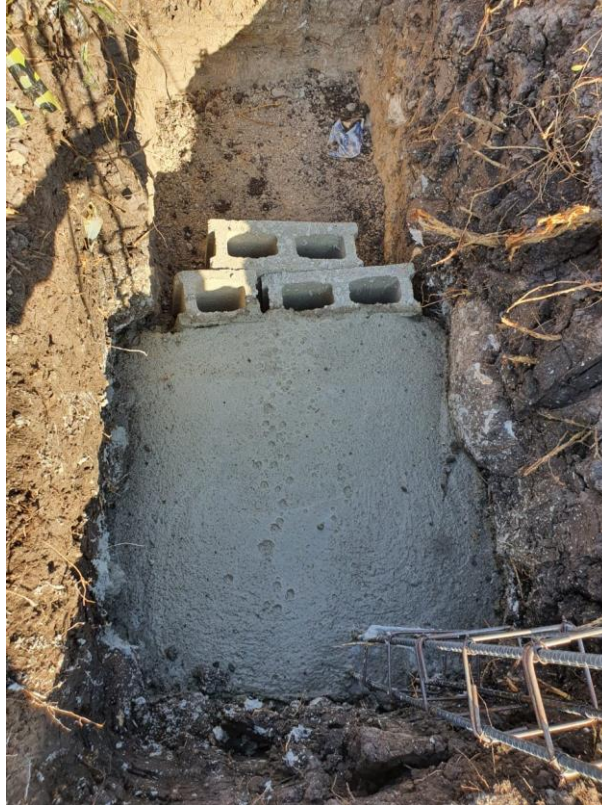
Ilustración 54-Fundición de zapata aislada
