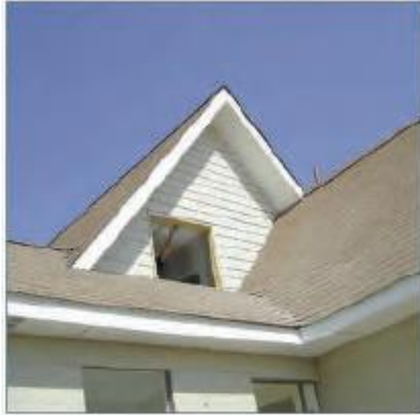
Ilustración 30-Cubierta de techo de vivienda
