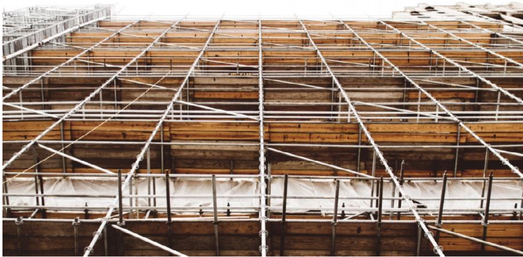
Ilustración 36-Encofrado con madera
