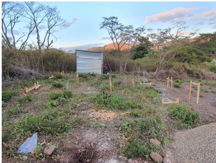
Ilustración 44-Trazado y Marcado del Terreno
