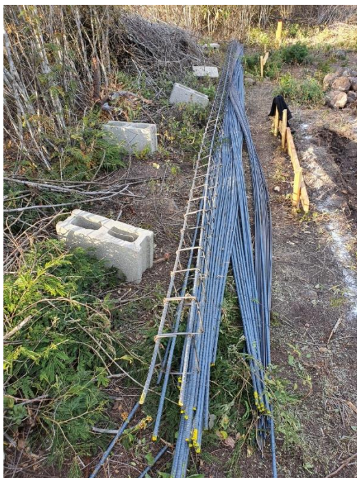
Ilustración 48-Armado de castillo de 15 x 20 cm
