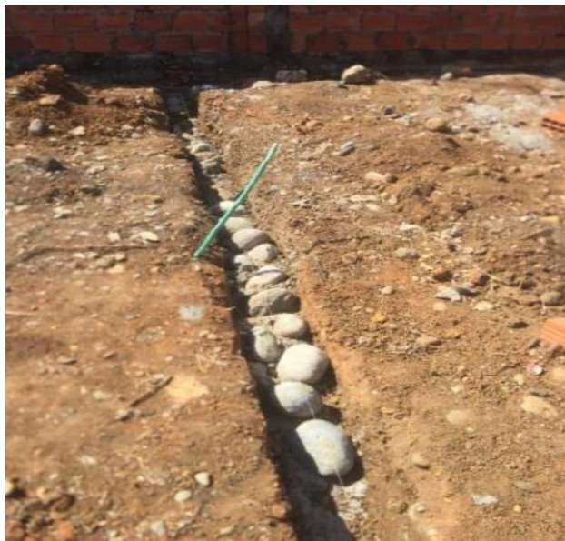
Ilustración 24-Cimentación con concreto ciclópeo
