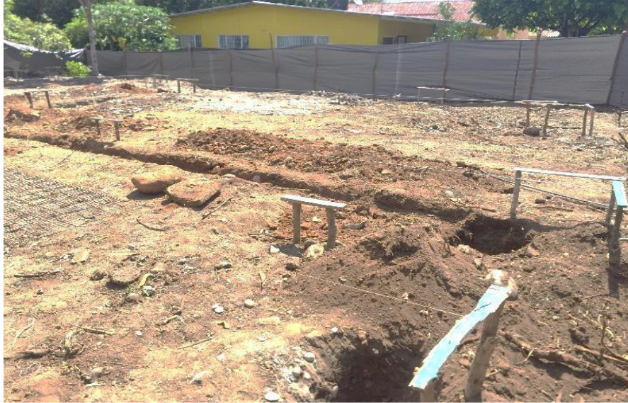
Ilustración 21-Excavación para vigas de cimentación
