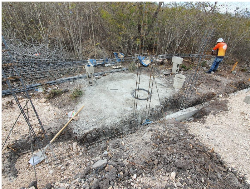
Ilustración 69-Armado para castillo de 15 x 20 cm
