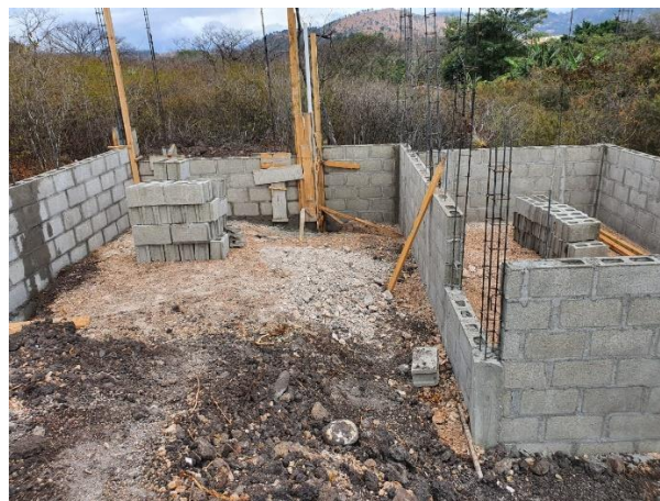
Ilustración 71-Pared de bloque reforzado en vivienda
