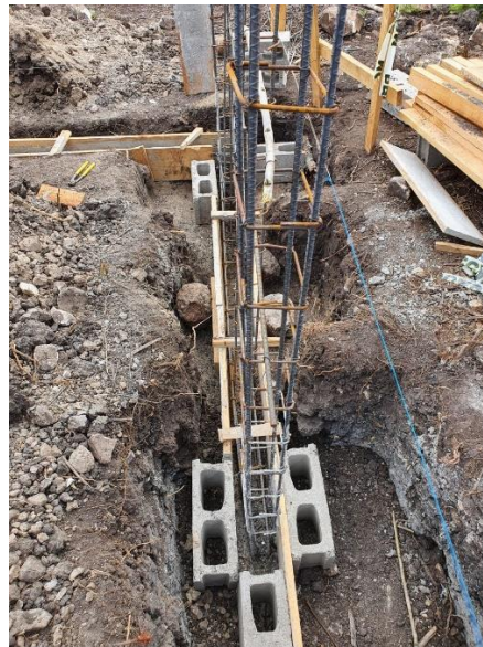
Ilustración 64-Encofrado para fundición de solera inferior
