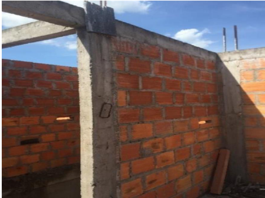
Ilustración 9-Columnas y vigas de concreto reforzado
