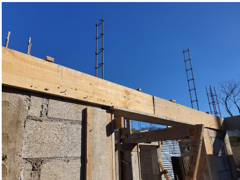
Ilustración 84-Fundición de cargadores de 10 x 15 cm
