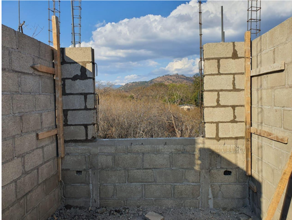
Ilustración 81-Levantamiento de paredes de bloque reforzado
