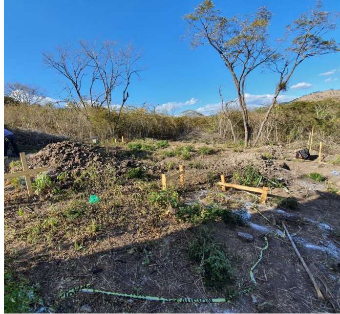
Ilustración 50-Trazado y Marcado de Terreno (2)
