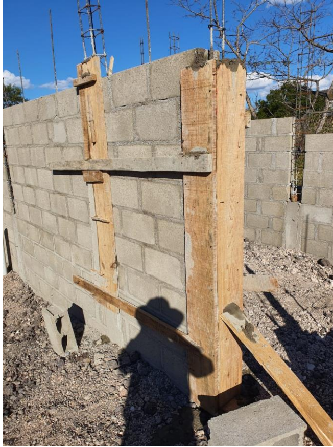
Ilustración 76-Fundición de jambas y castillos
