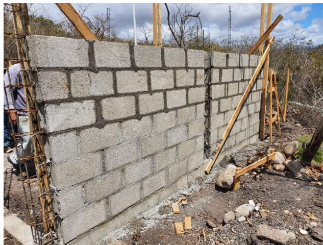
Ilustración 66-Levantamiento de pared de bloque reforzado
