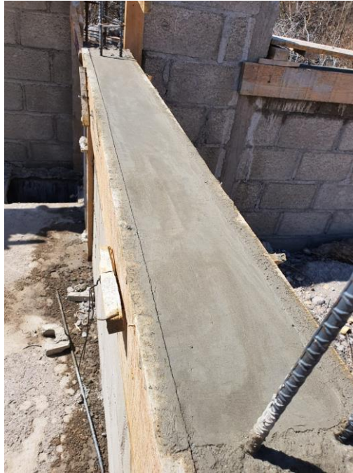
Ilustración 80-Fundición de batiente de 10 x 5 cm
