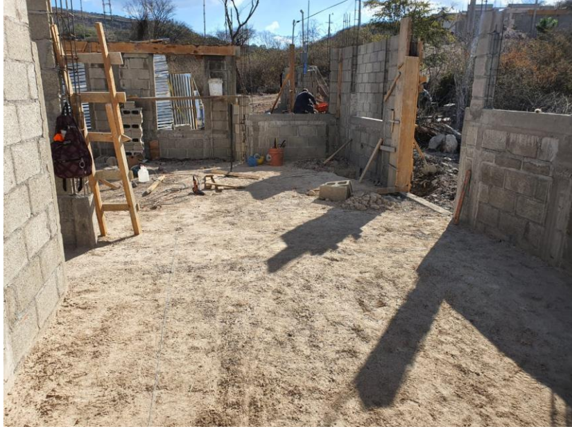
Ilustración 83-Fundición de cargadores de 10 x 15 cm
