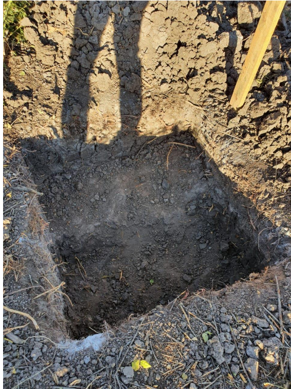
Ilustración 46-Excavación de zapata
