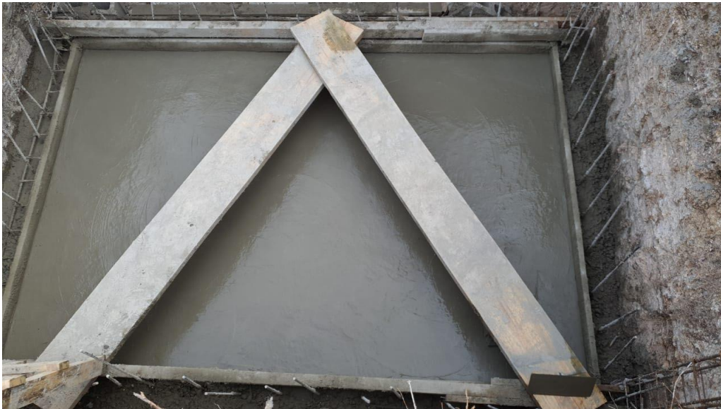
Ilustración 72-Fundición de firme de cisterna con acabado fino
