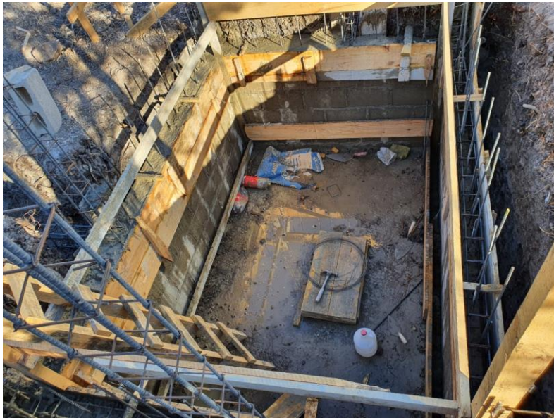
Ilustración 74-Pared de bloque reforzado en cisterna de 2000 galones
