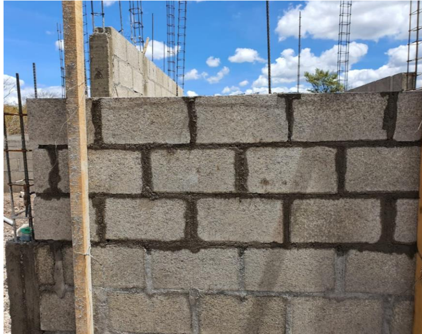
Ilustración 78-Pared de bloque reforzado
