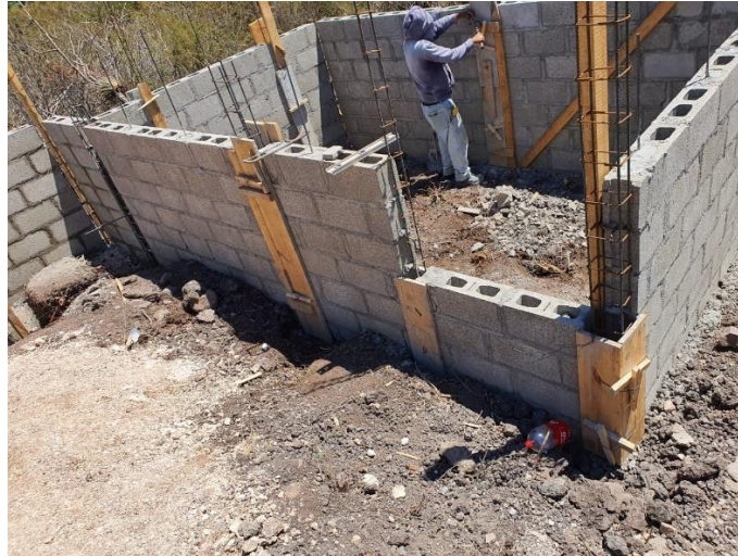
Ilustración 68-Levantamiento de pared en cuarto principal de vivienda
