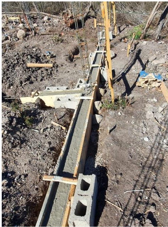
Ilustración 61-Fundición de solera inferior
