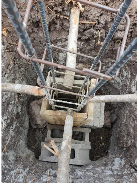
Ilustración 59-Encofrado para fundición de pedestal
