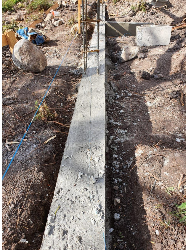
Ilustración 62-Fundición de solera inferior
