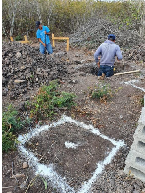
Ilustración 52-Excavación de zapata
