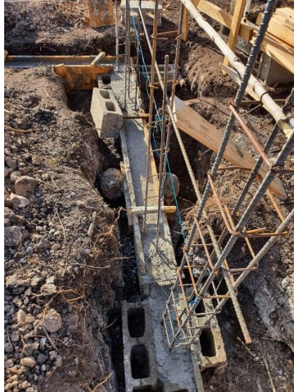
Ilustración 63-Fundición de solera inferior
