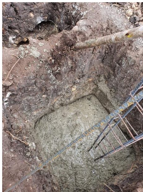
Ilustración 60-Fundición de zapata aislada
