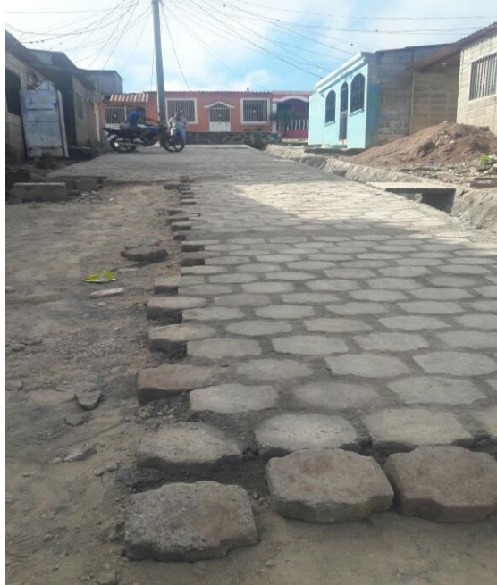
Ilustración 18-Pavimentación de adoquín en calles en colonias del MDC
