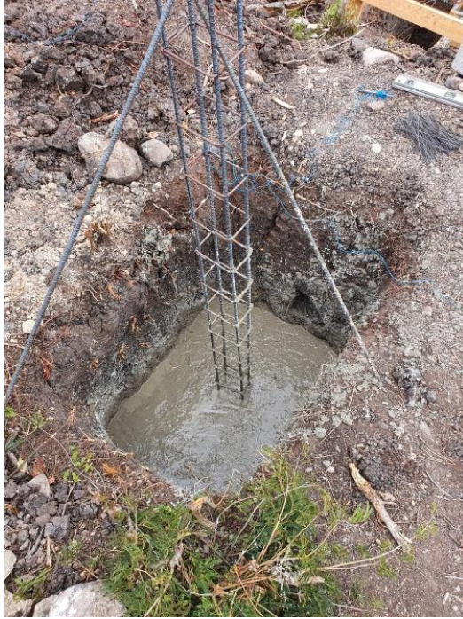
Ilustración 57-Fundición de zapata aislada
