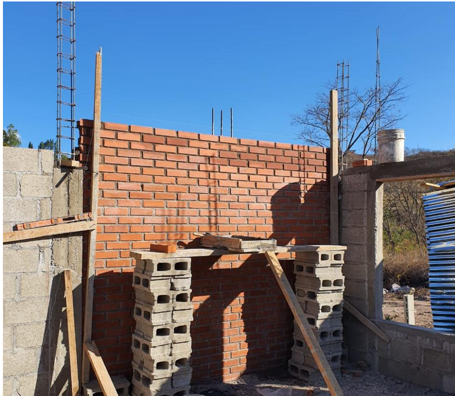
Ilustración 85-Levantamiento de pared de ladrillo reforzado
