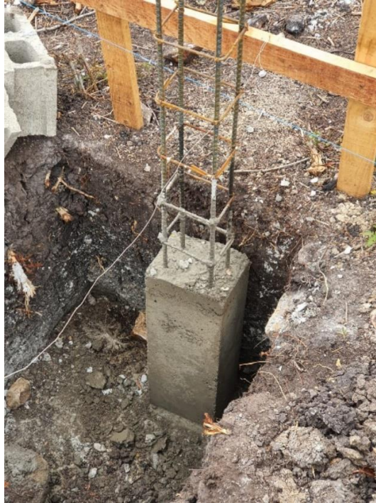
Ilustración 58-Fundición de pedestal de 15 x 20 cm
