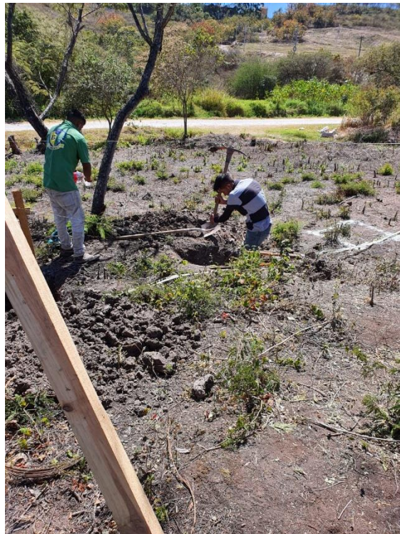
Ilustración 45-Excavación de zapata
