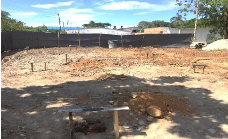
Ilustración 20-Marcado y trazado
