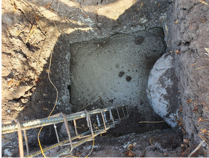
Ilustración 55-Fundición de zapata aislada
