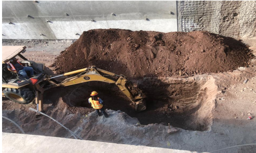
Ilustración 54 Excavación de tubería sistema alcantarillado pluvial.
