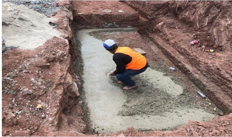
Ilustración 65 Fundición concreto pobre muros de retención.
