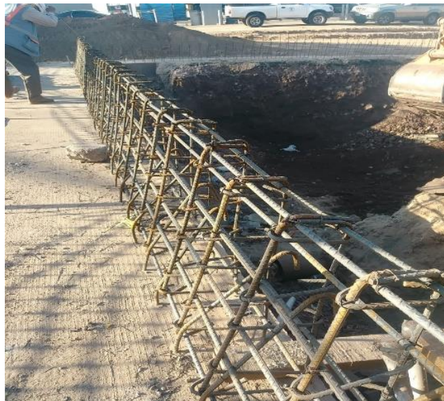
Ilustración 28 Armado de barrera New Jersey.
