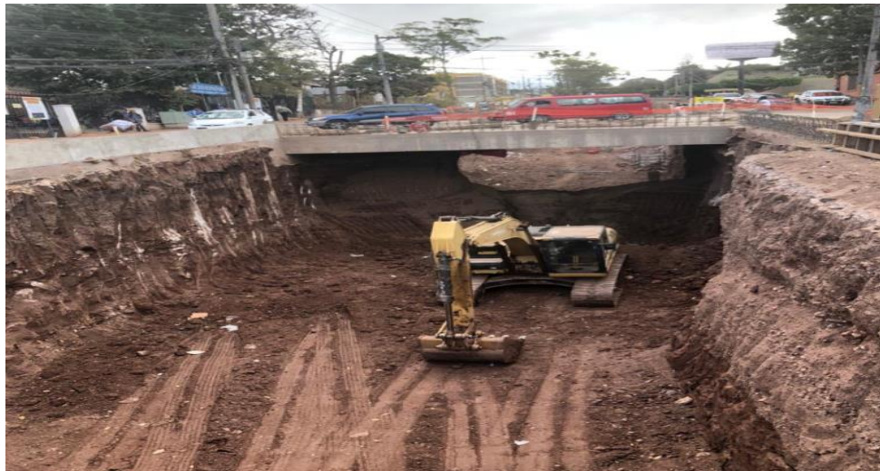
Ilustración 40 Excavación del túnel semana 4
