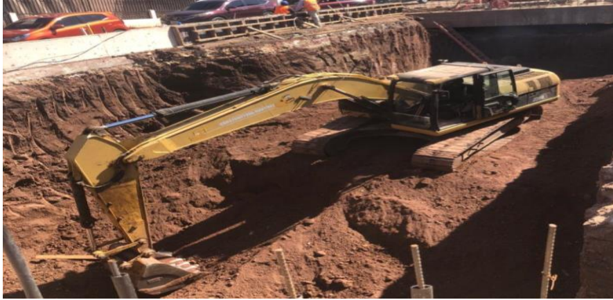
Ilustración 35 Excavación del túnel
