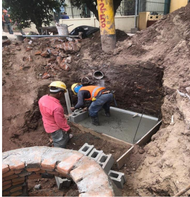
Ilustración 39 Construcción de pozo de inspección y tragante.
