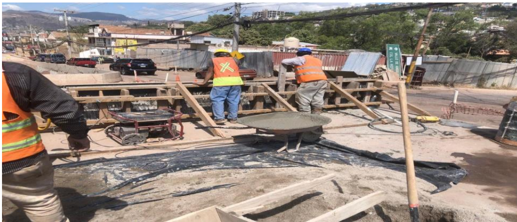
Ilustración 60 Fundición de barreras centrales.
