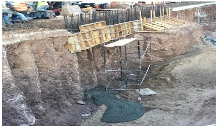
Ilustración 53 Primera parte de fundición encepado
