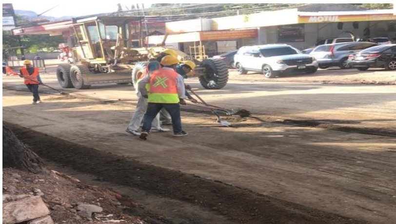
Ilustración 25 Estabilización con suelo cemento
