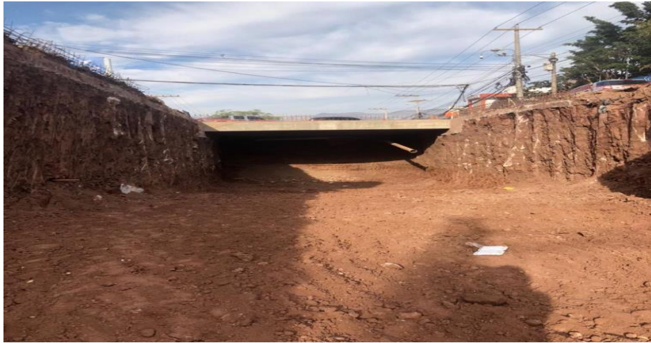
Ilustración 32 Excavación de túnel de la Avenida La Paz.
