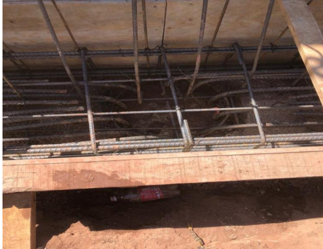
Ilustración 23 Armado de viga de remate.
