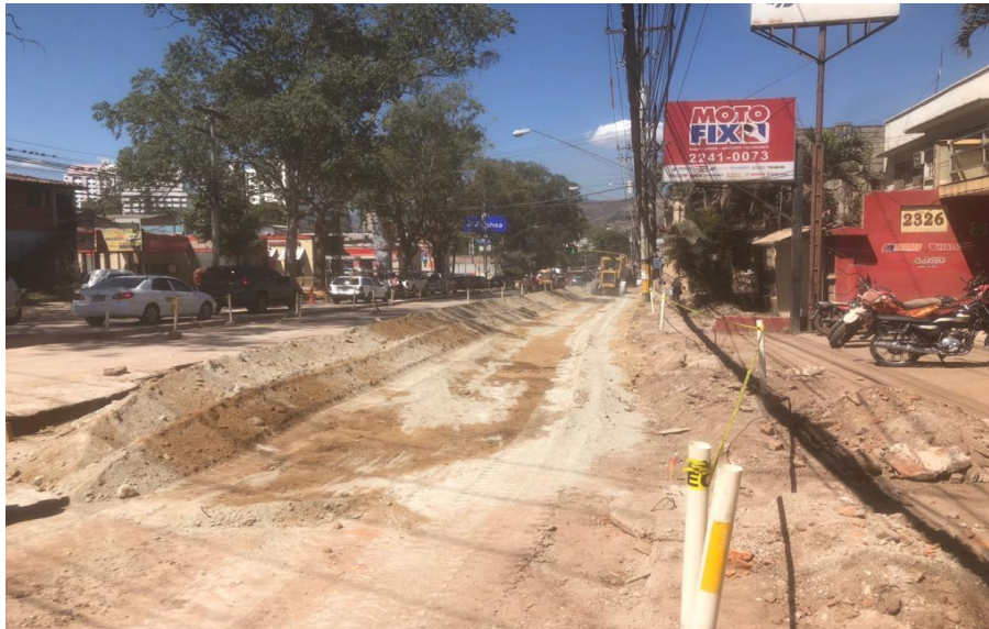
Ilustración 49 Suelo cemento Est. 0+168 – 0+ 234
