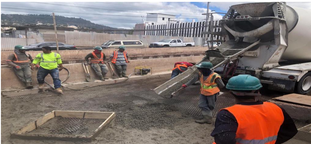
Ilustración 43 Pavimentación concreto f'c = 6000 psi con geomalla.
