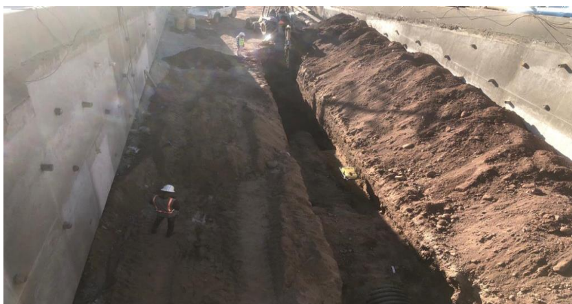
Ilustración 56 Instalación de tubería sistema alcantarillado pluvial
