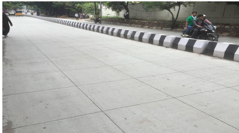
Ilustración 16 Concreto Whitetopping.
