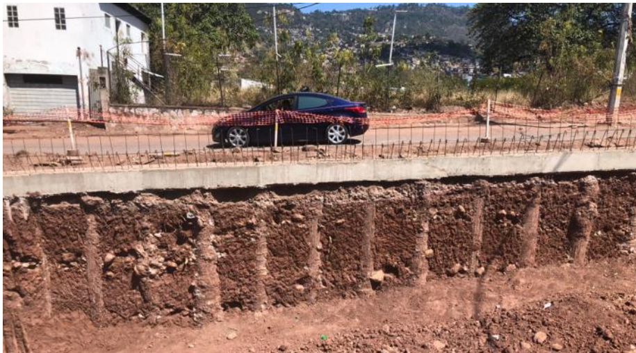
Ilustración 10 Pilotes perforados.
