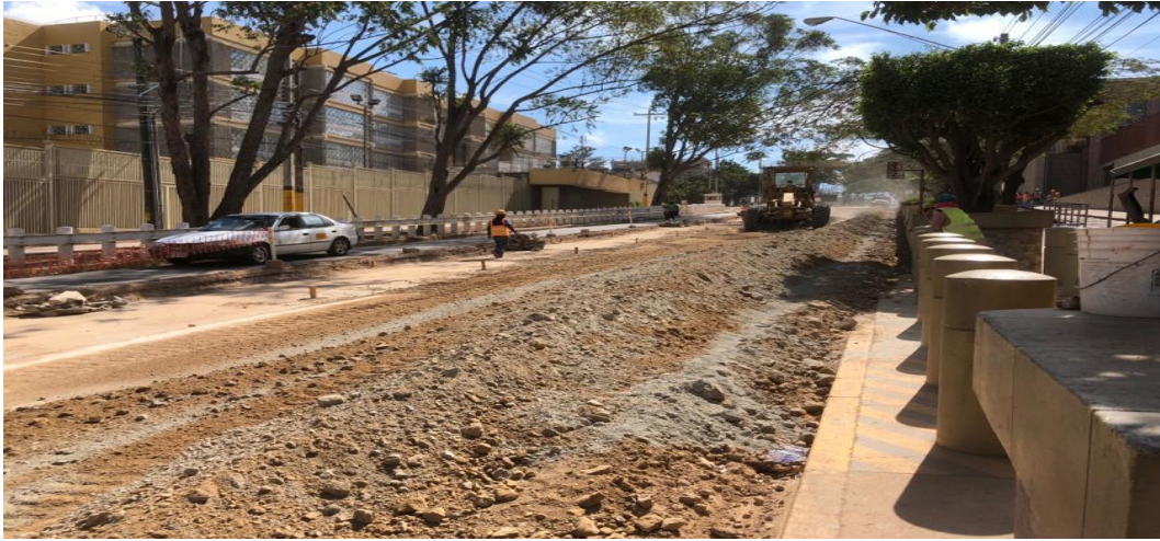
Ilustración 68 Suelo cemento Est. 0+480 – 0+ 570
