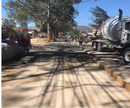
Ilustración 33 Fundición de pavimento con concreto MR 650.
