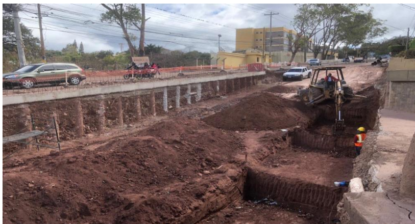
Ilustración 55 Excavación de tubería sistema alcantarillado pluvial.
