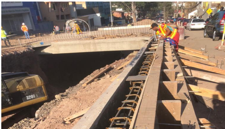
Ilustración 36 Armado de barrera New Jersey
