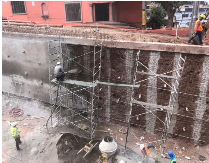
Ilustración 67 Lanzado de concreto Est. 0+394 – 0+ 388
