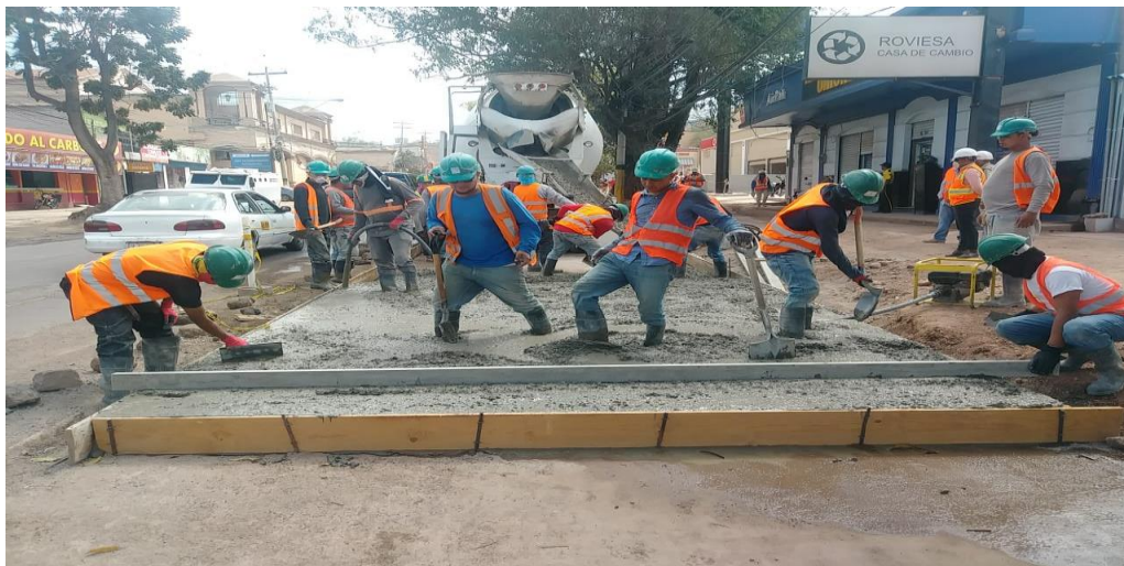
Ilustración 48 Pavimentación concreto MR 650
