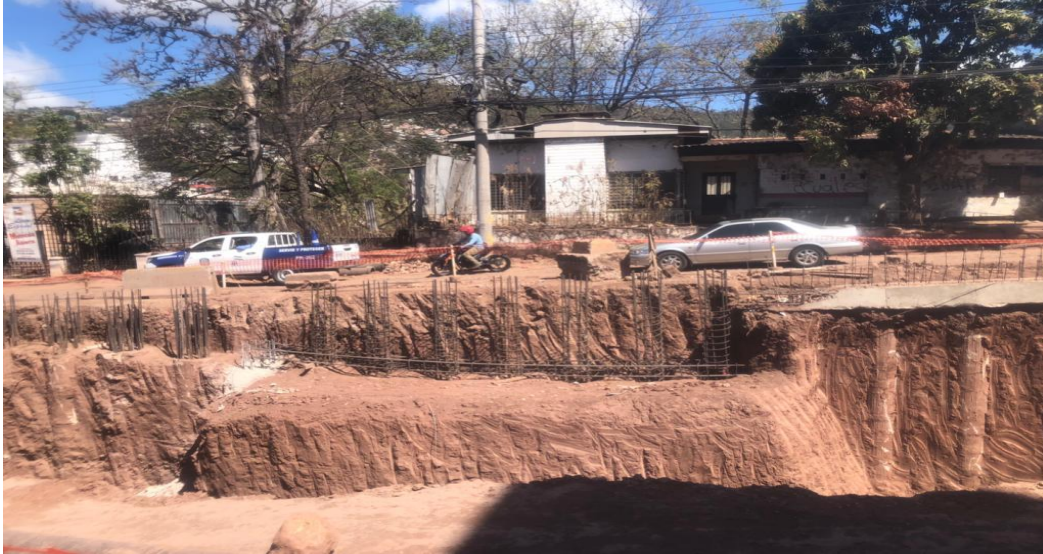
Ilustración 47 Armado de acero en pilotes.
