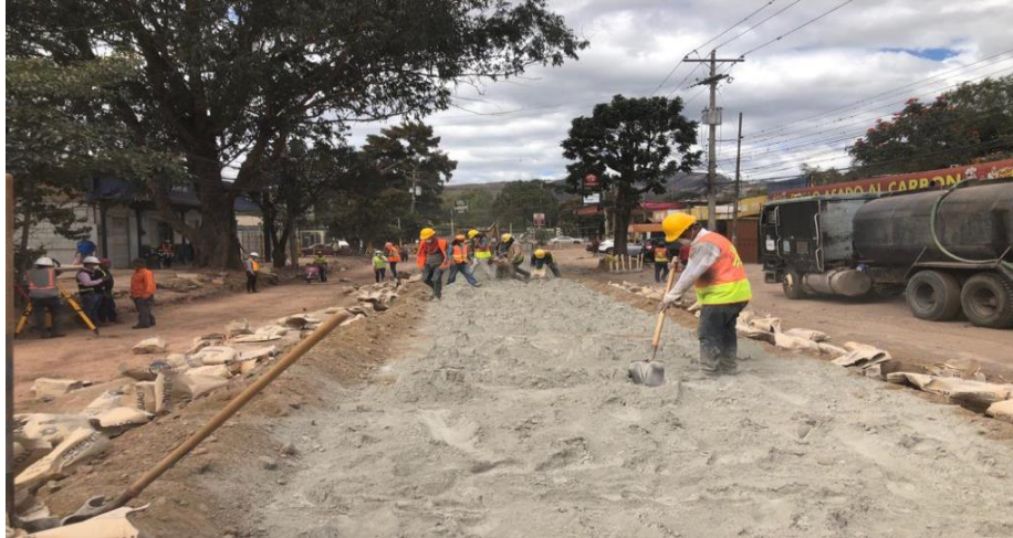
Ilustración 38 Estabilización con suelo cemento.
