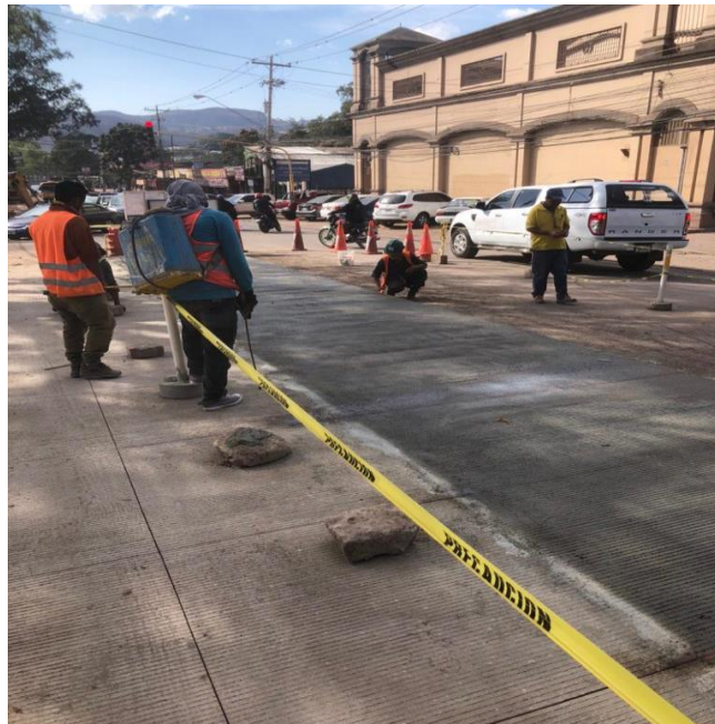
Ilustración 37 Aplicación de curador en Whitetopping.
