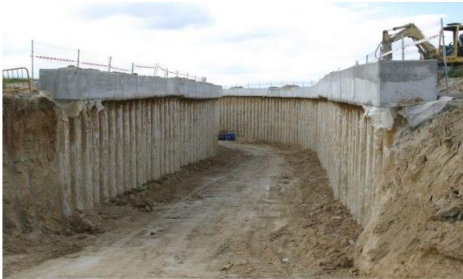
Ilustración 9 Túnel a base de pilotes.
