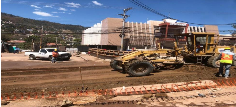
Ilustración 57 Afinamiento de la subrasante
