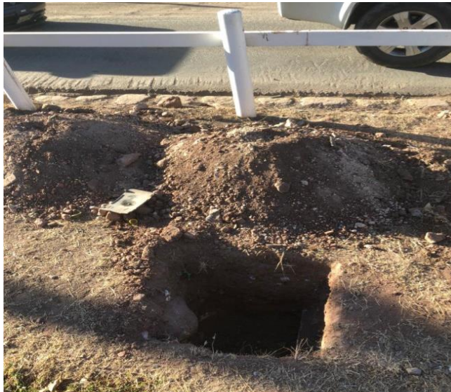
Ilustración 24 Excavación para postes consulado de la Embajada Americana
