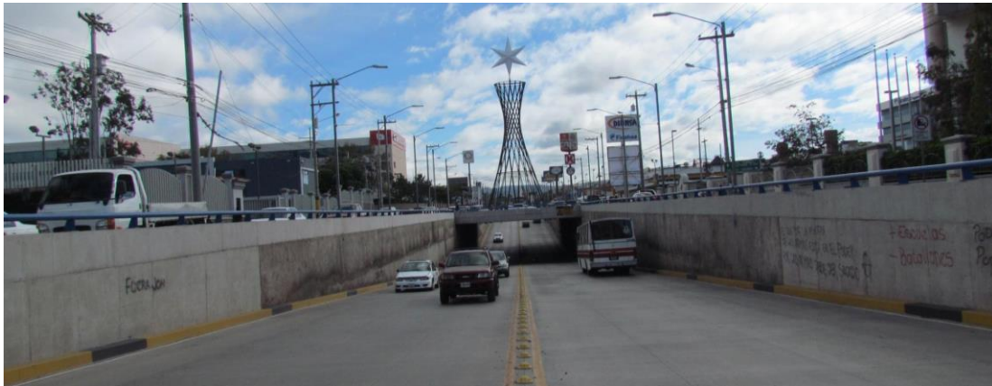
Ilustración 5 Túnel paso a desnivel “Diunsa – Tres Caminos”.
