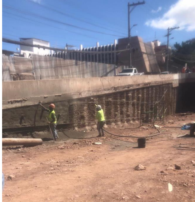
Ilustración 45 Concreto lanzado estacionamiento 0+240 a 0+248
