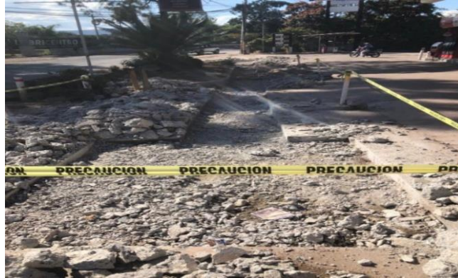
Ilustración 27 Demolición de pavimento de concreto hidráulico.
