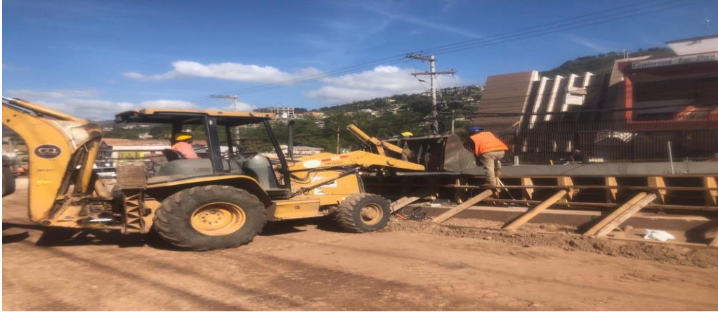
Ilustración 42 Fundición de barrera estación 0+347 - 0+357.
