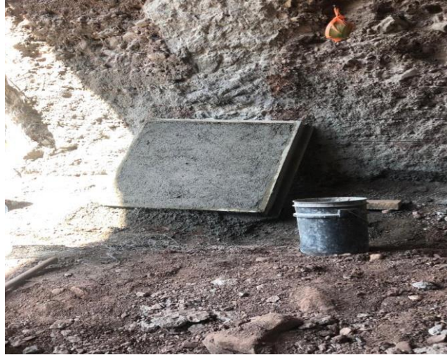
Ilustración 51 Muestra de concreto lanzado.
