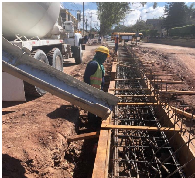
Ilustración 26 Fundición de viga de remate.
