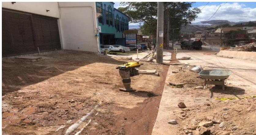
Ilustración 64 Elaboración de aceras.
