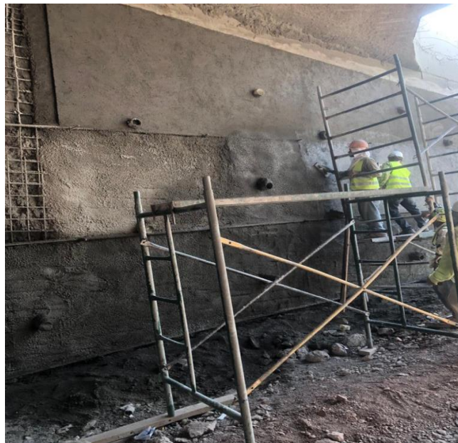
Ilustración 50 Lanzado de concreto de la pantalla.
