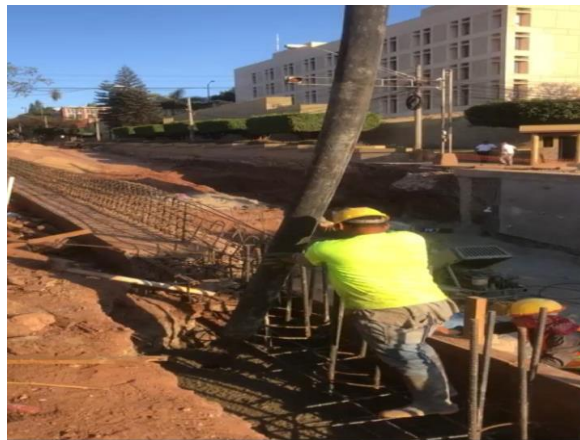
Ilustración 59 Segunda parte fundición encepado.
