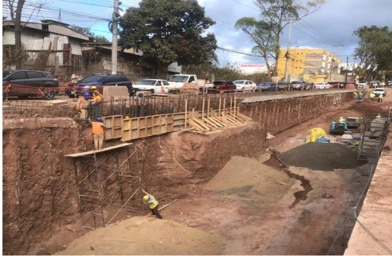
Ilustración 52 Finalización de armado y encofrado de encepado.
