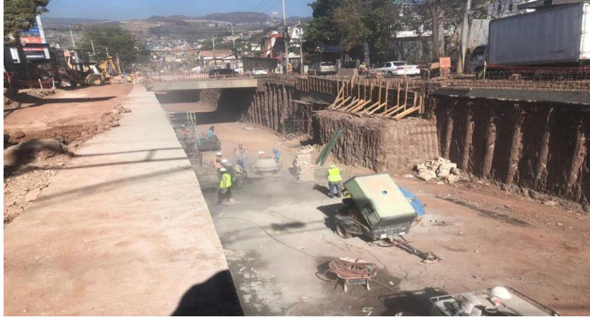
Ilustración 58 Lanzado de concreto Est. 0+395 – 0+ 400
