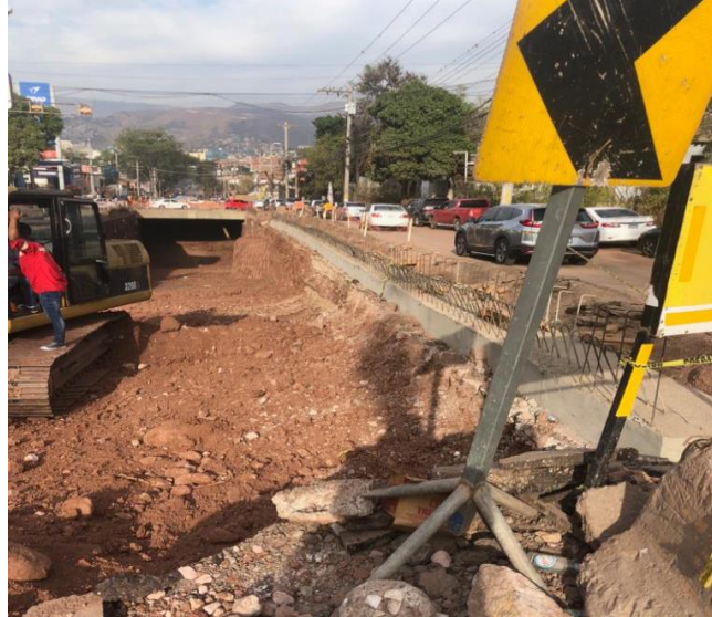
Ilustración 22 Excavación de túnel.
