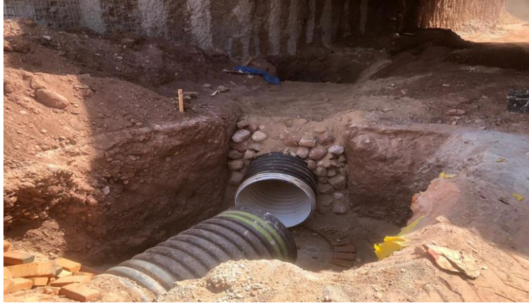
Ilustración 63 Instalación de tubería tragante 1 túnel
