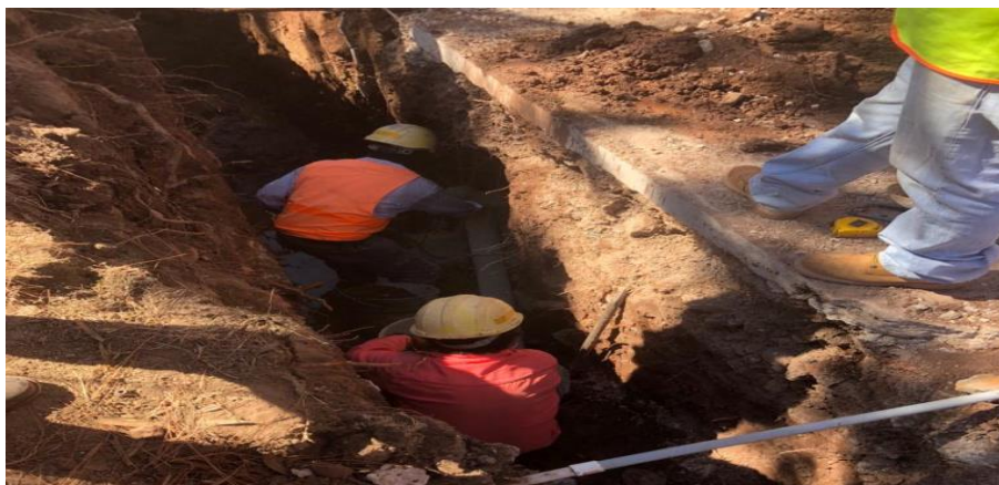
Ilustración 34 Instalación de tubería del sistema de alcantarillado
