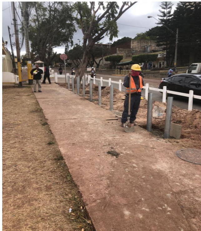
Ilustración 31 Fundición de postes de protección
