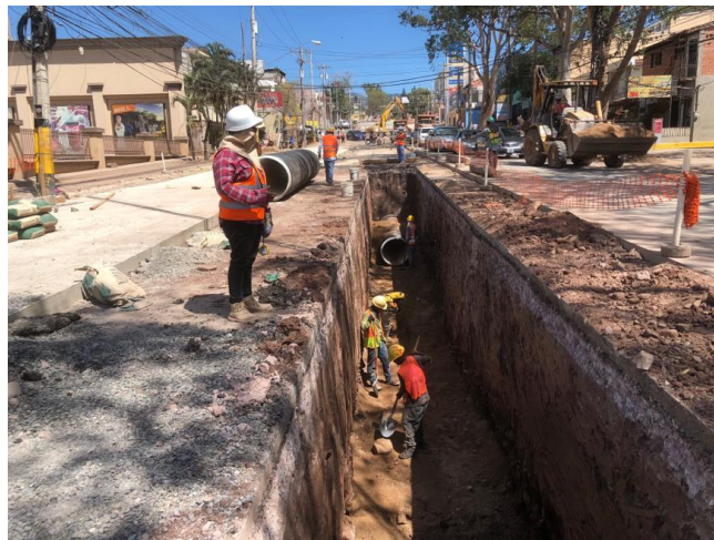
Ilustración 69 Instalación de tubería alcantarillado pluvial.
