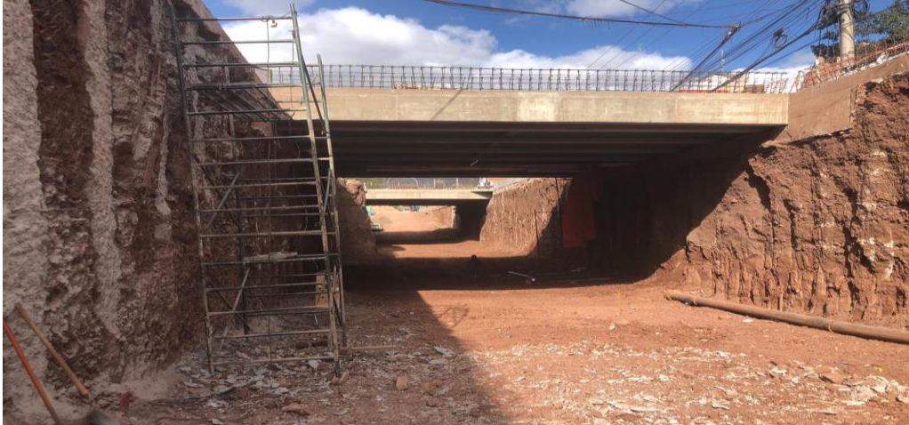
Ilustración 41 Excavación del túnel (90%)
