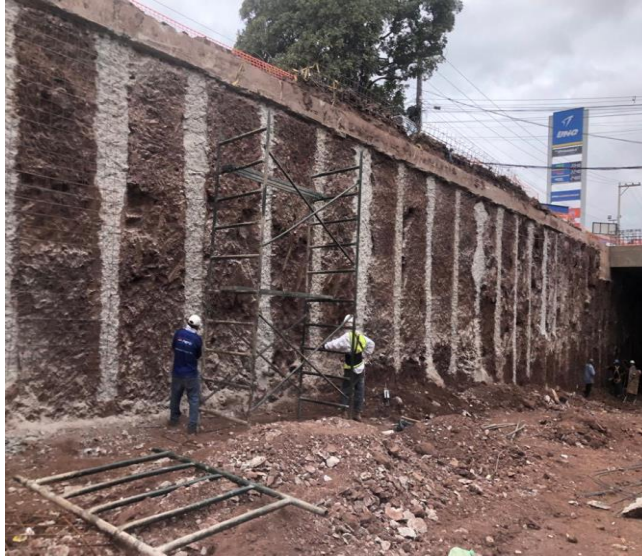
Ilustración 46 Armado de malla electrosoldada pantalla.
