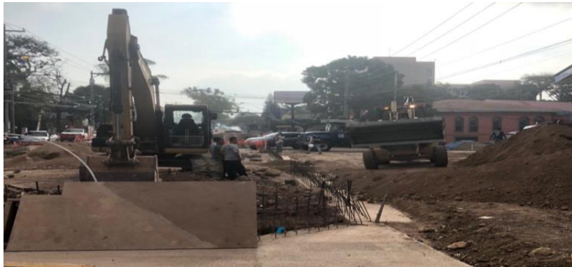
Ilustración 29 Inicio de excavación central del túnel
