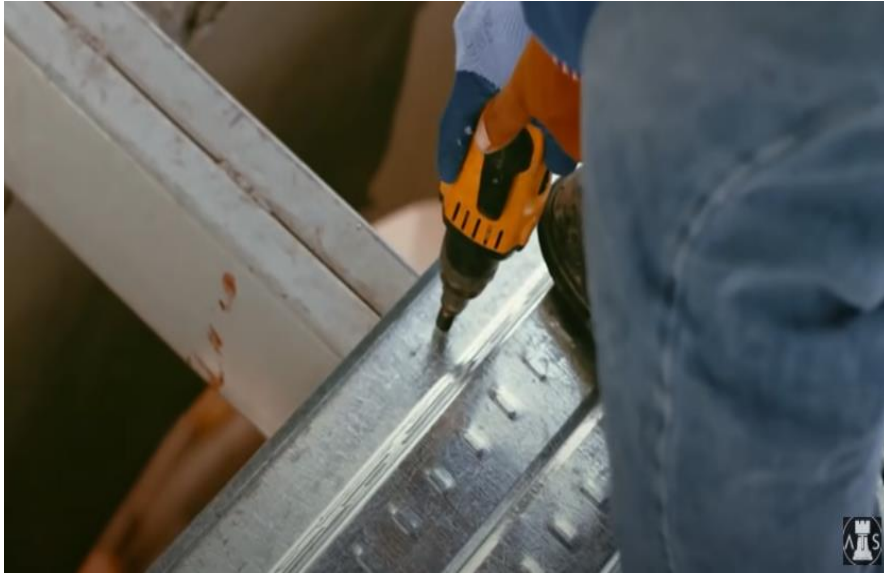
Ilustración 19 Sujeción por medio de Pernos
