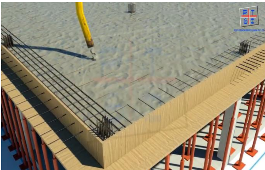
Ilustración 22 Colado del Concreto
