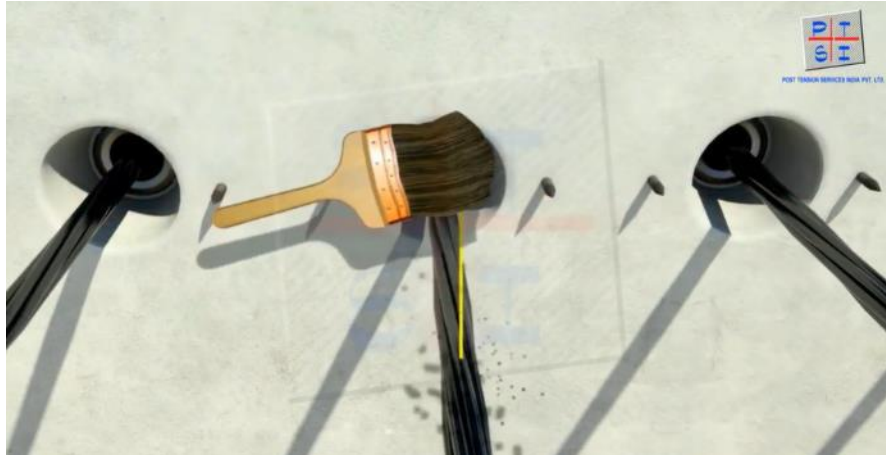
Ilustración 36 Limpieza de los Anclajes
