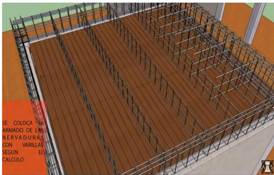
Ilustración 24 Armado de Nervaduras
