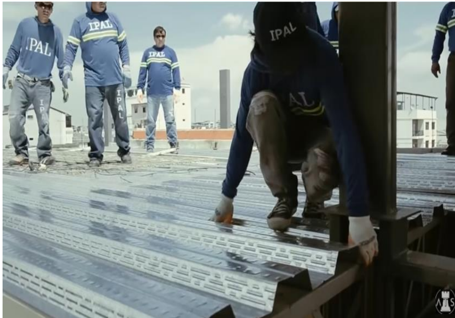
Ilustración 18 Colocación de la Lámina
