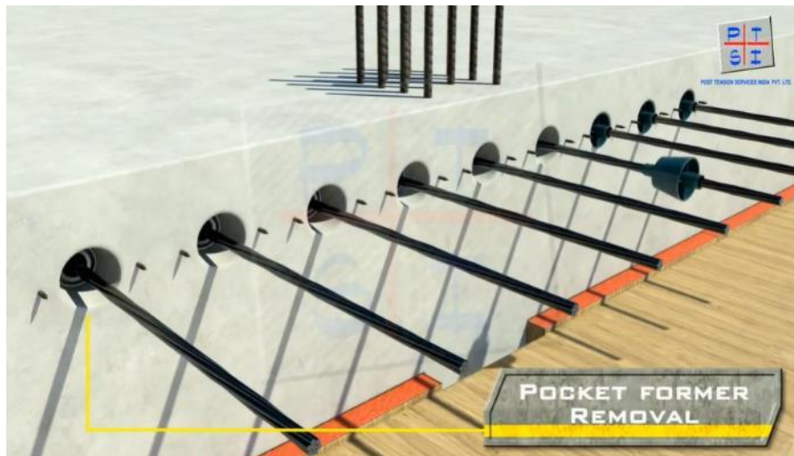
Ilustración 35 Removido de Bloques de Postensado
