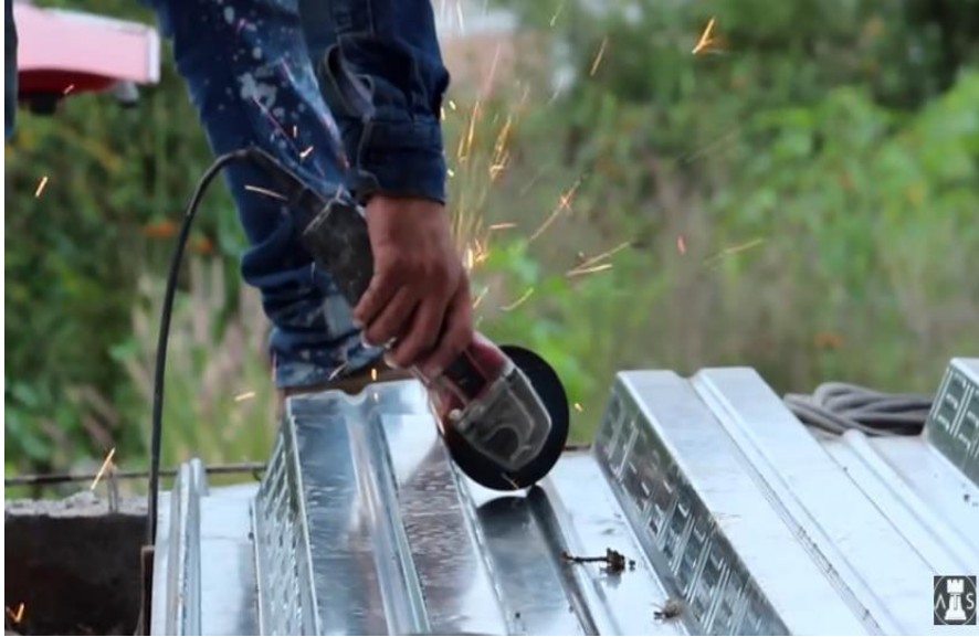
Ilustración 17 Cortado de Lámina Estructural
