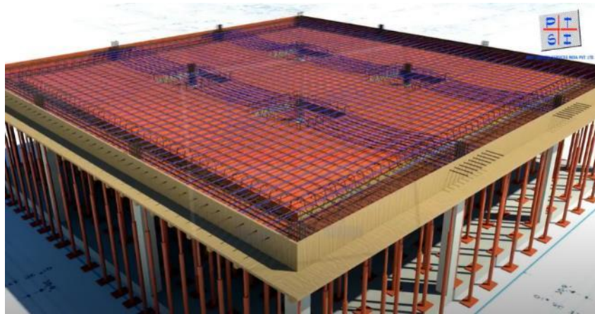
Ilustración 31 Colocación de Cables de la Losa
