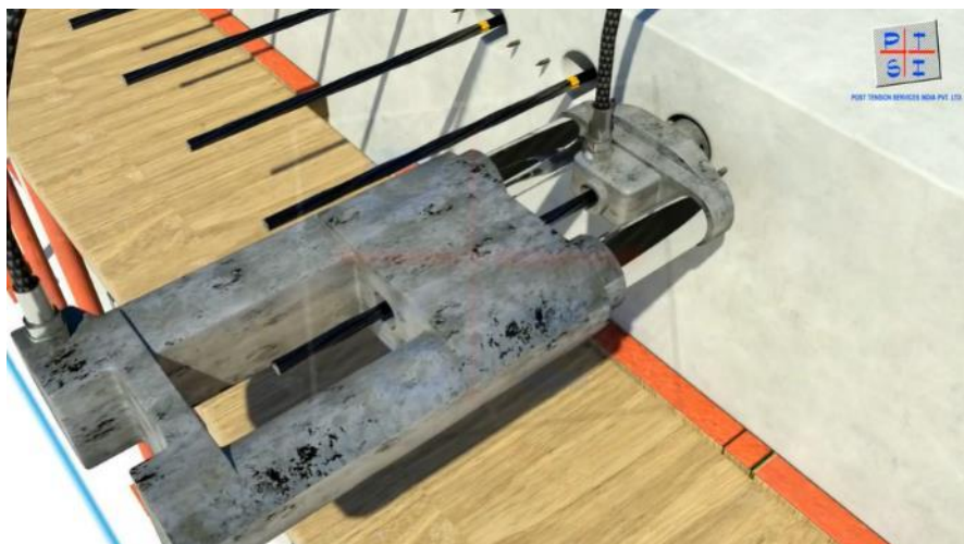
Ilustración 38 Tensado de Cables con Gato Hidráulico
