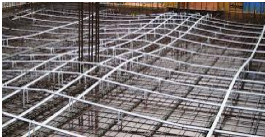
Ilustración 6 Losa Postensada
