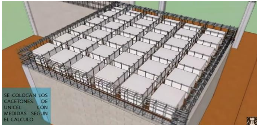
Ilustración 25 Colocación de Casetones
