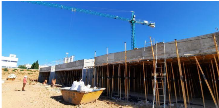
Ilustración 19- Construcción edificio Zero Kömmerling
