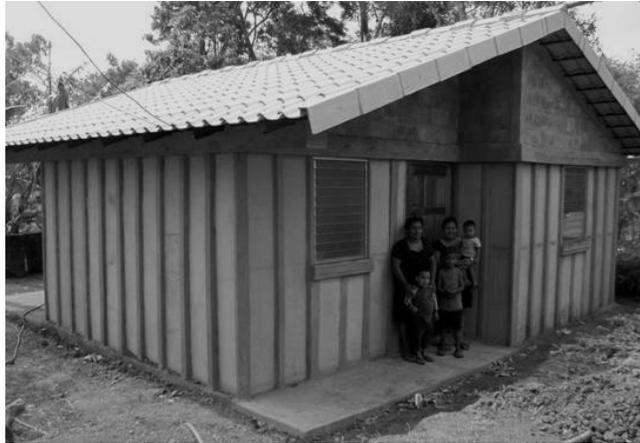
**Ilustración 7. Casa construida con paneles de ferrocemento.**
