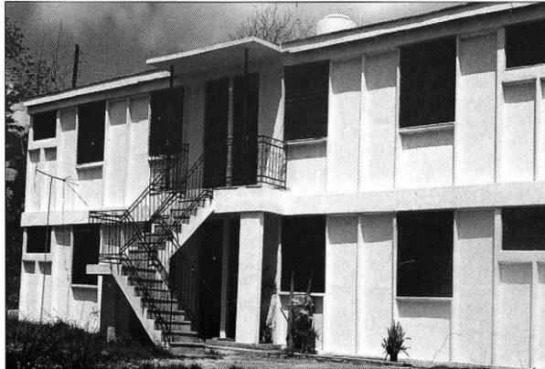
**Ilustración 5 Edificio prefabricado de ferrocemento para viviendas. Pinar del Río, Cuba**
