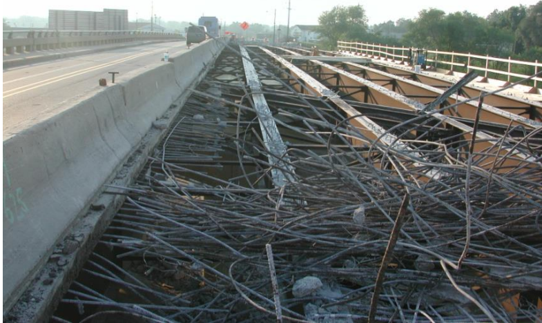
Ilustración 19 Demolición de la plataforma del puente
