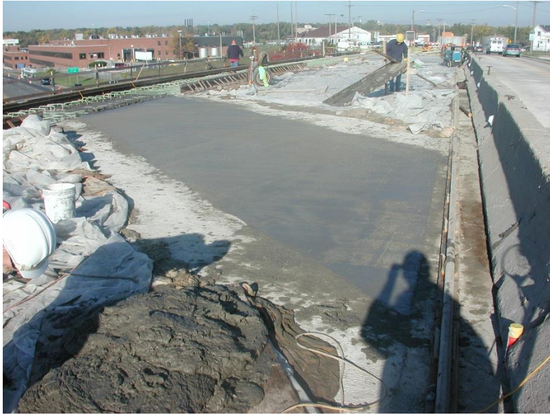
Ilustración 23 Fundición de losa de enlace
