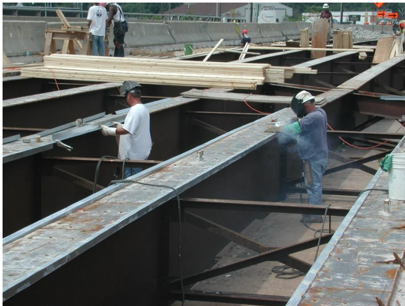
Ilustración 20 Limpieza de vigas e instalación de nuevas conexiones
