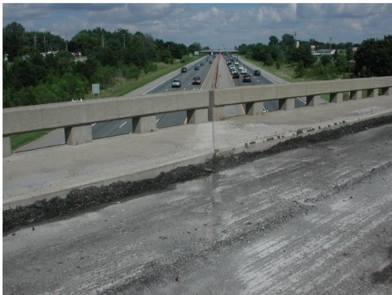
Ilustración 18 Remoción de superficie de rodadura de asfalto
