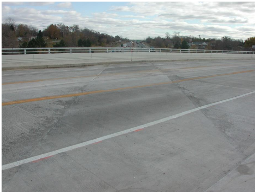
Ilustración 24 Estructura actual del puente de Grove Street, Michigan, USA
