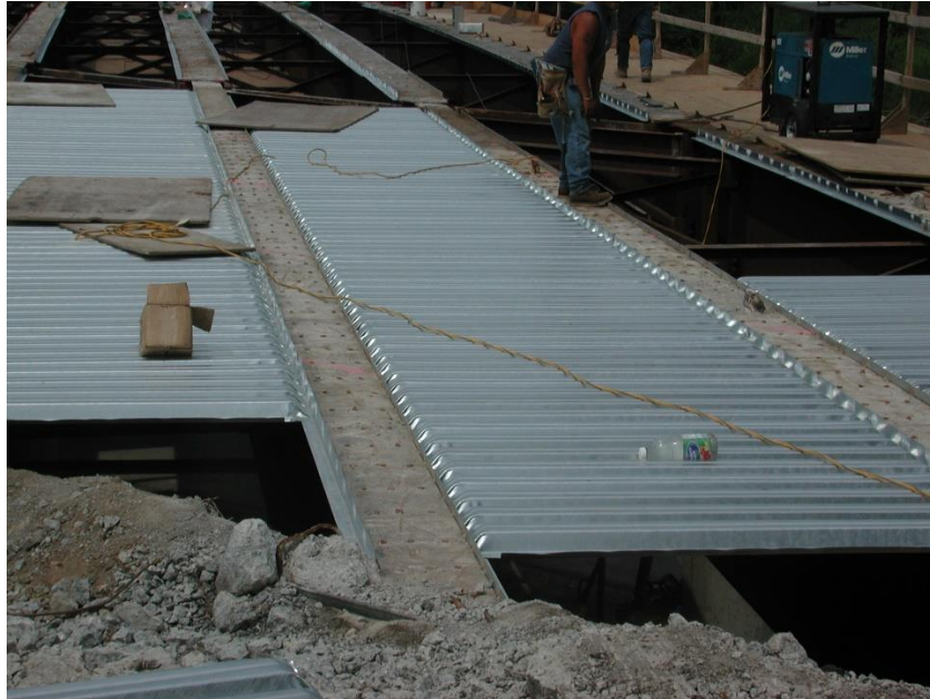
Ilustración 21 Instalación de encofrado fijo
