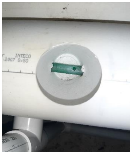
Figura 8.14 Corte y cruce de manguera por recipiente plástico (Elaboración propia, 2021)
