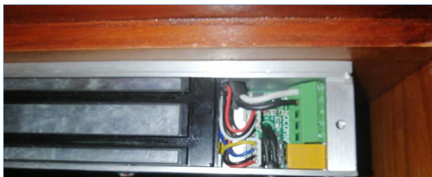
Figura 8.29 Conexión de voltaje de llave.
