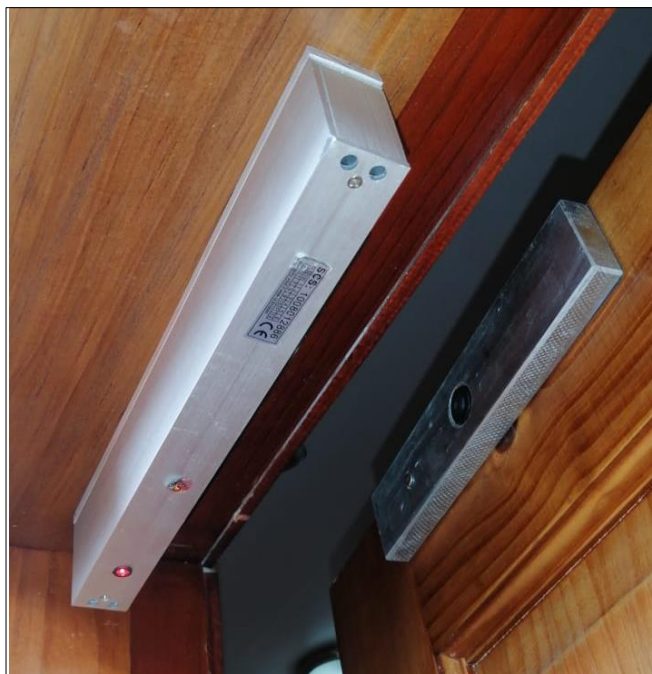
Figura 8.21 Cerradura electromagnética abierta (elaboración propia, 2021)
