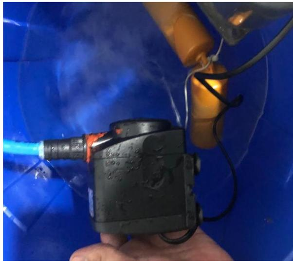
*Figura 8.16* Bomba sumergible en el tanque (Elaboración propia, 2021)
