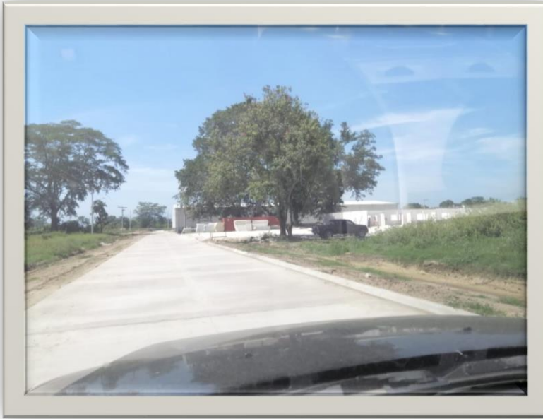
Fotografía del Ingreso a ZEDE Morazán, calle pavimentada, ubicada en el Sector Bejucales, Los Caraos, Choloma, Cortés.
