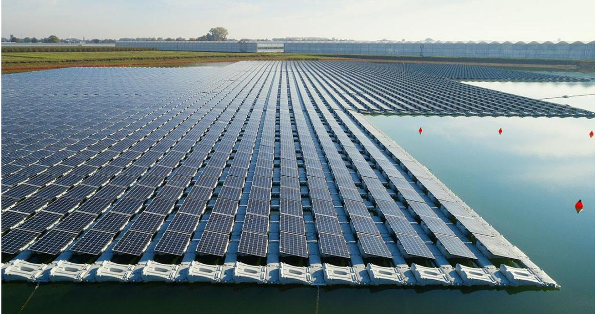
**Ilustración 30. Vista de planta de sistema fotovoltaico flotante con sistema Ciel & Terre.**
