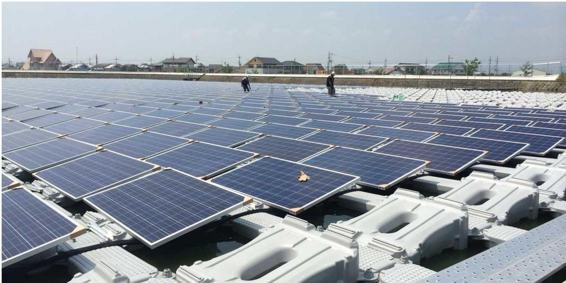
**Ilustración 24. Sistema fotovoltaico flotante instalado por en Ciel y Terre con sistema Hydrelío en Japón**
