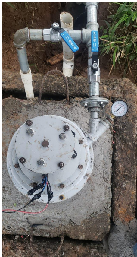
Ilustración 52: Instalación de la microturbina en la estación reductora de presión
