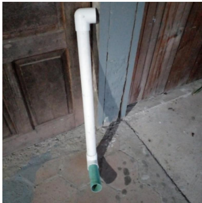
Ilustración 33-Instrumento para la redirección del caudal en el acueducto
