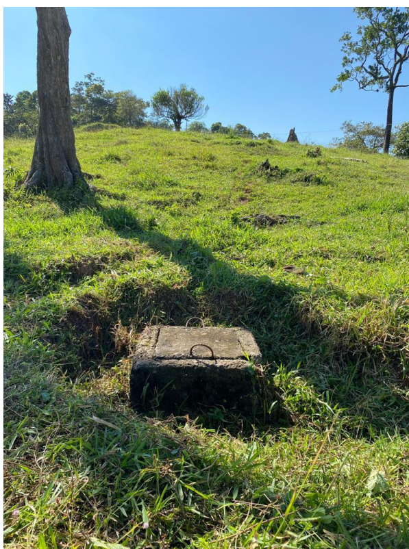
Ilustración 50: Estación reductora de presión #3
