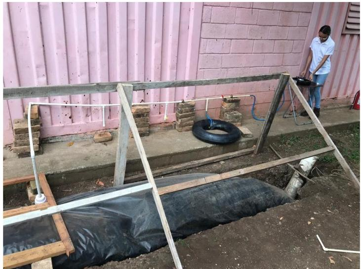
**Ilustración 39 Sistema de distribución de biogás**
