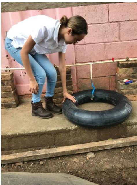
**Ilustración 41 Neumático para almacenamiento de biogás**
