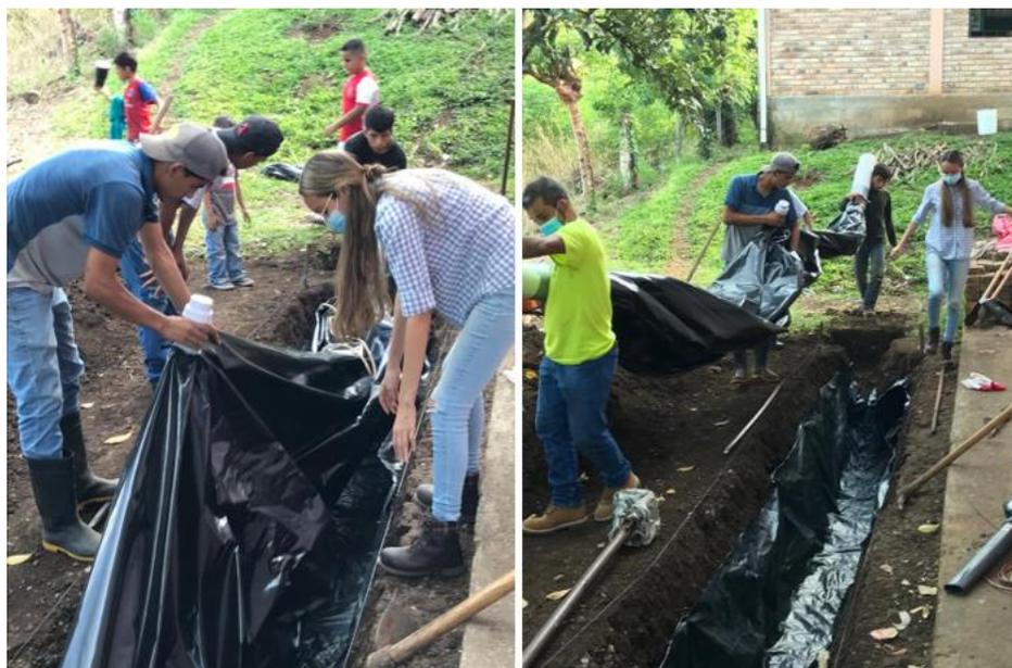
**Ilustración 30 Instalación y montaje de biodigestor dentro de la zanja**
