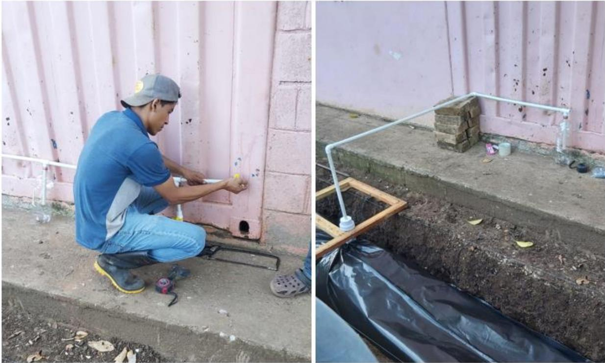
**Ilustración 31 Instalación de tubería para conducción de biogás**
