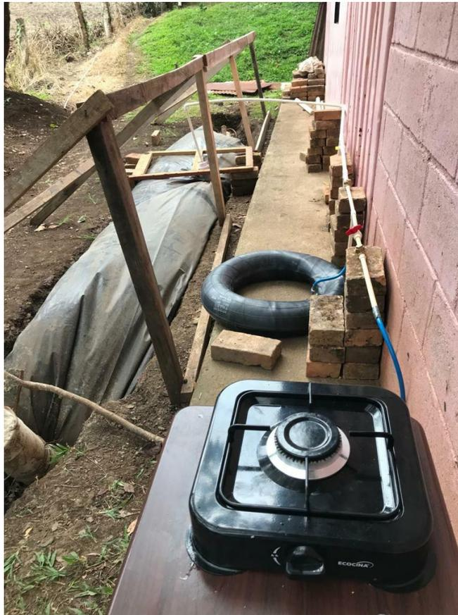
**Ilustración 33 Conexión de biodigestor a estufa**
