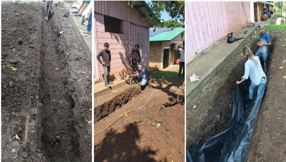
**Ilustración 26 Preparación de zanja para instalación de biodigestor**
