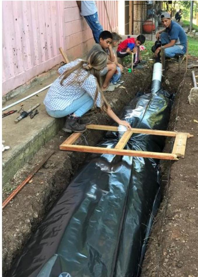
**Ilustración 32 Prueba de fuga de aire en biodigestor instalado**
