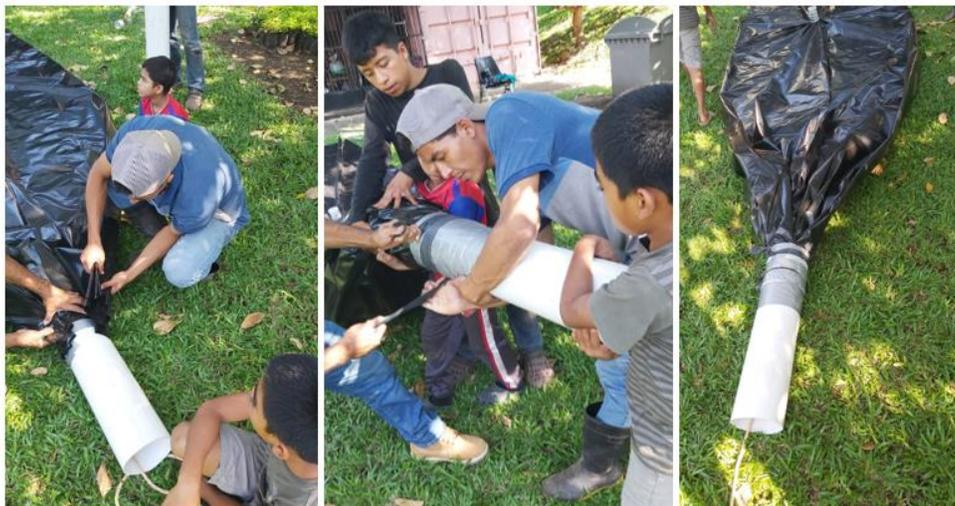
**Ilustración 28 Instalación de tubería PVC para la carga y descarga en la manga tubular**
