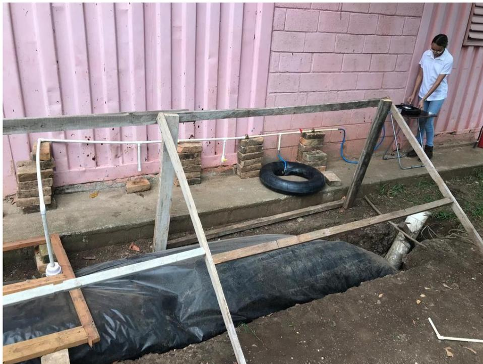
**Ilustración 36 Resultado de biodigestor instalado**
