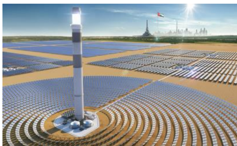
Ilustración 15. Tecnología de Torre Central
