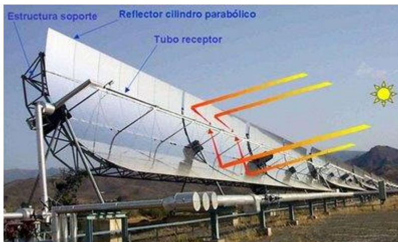
Ilustración 13. Tecnología Colectores Cilindros Parabólicos
