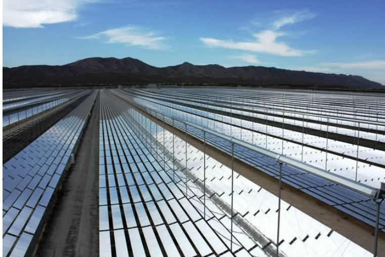
Ilustración 12. Tecnología Colector Lineal Fresnel.
