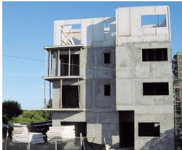
**Ilustración 4- Sistema de construcción utilizado por EMMEDUE en Nicaragua**
