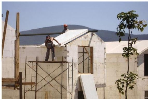
**Ilustración 1- Proceso de construcción de una casa con poliestireno expandido**
