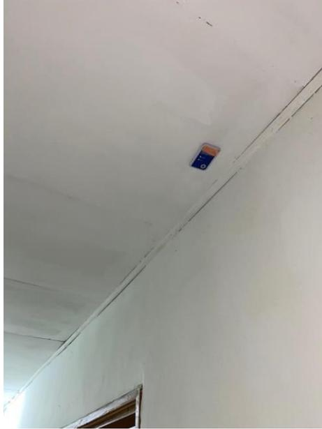
**Ilustración 18- Sensor de temperatura instalado en la parte interior del techo en residencia construida con bloque de concreto.**
