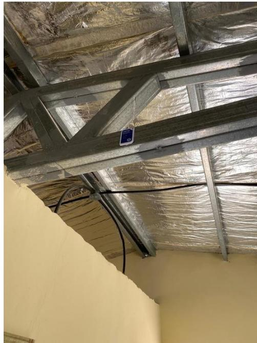
**Ilustración 15 – Sensor instalado en la parte superior interior de la casa construida con poliestireno expandido (29 de octubre).**
