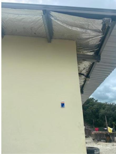
**Ilustración 28- Sensor de temperatura instalando en pared oeste exterior de residencia construida de poliestireno expandido (1 de noviembre).**
