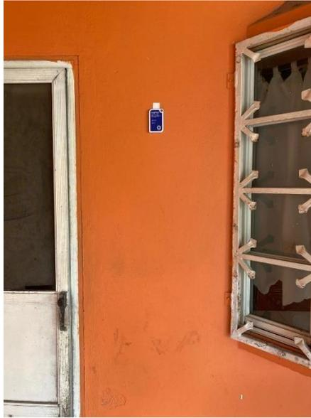
**Ilustración 22 - Sensor de temperatura instalado en pared sur exterior en residencia construida con bloque de concreto (30 de octubre).**
