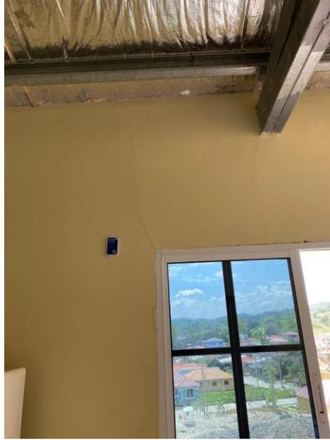
**Ilustración 20 - Sensor de temperatura instalando en pared sur interior en la residencia construida con poliestireno expandido (30 de octubre).**
