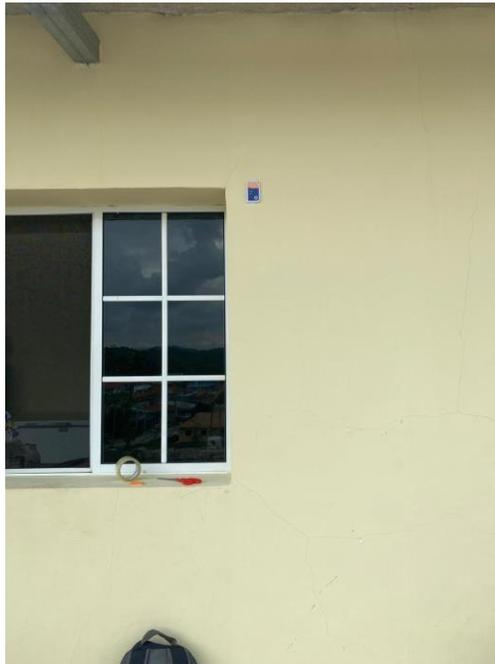
**Ilustración 24- Sensor de temperatura instalado en pared este exterior en residencia construida con poliestireno expandido (31 octubre).**
