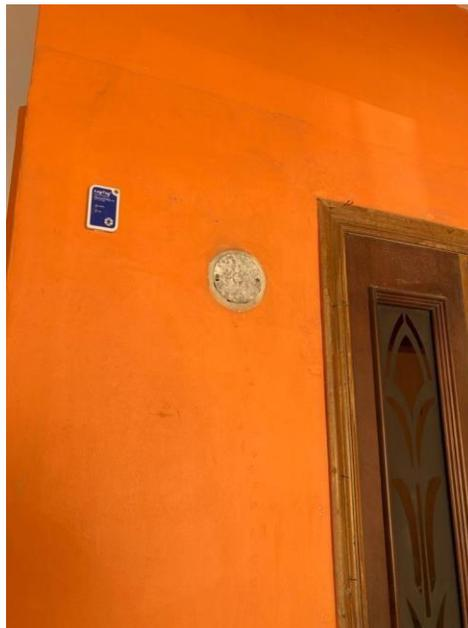
**Ilustración 17 – Sensor de temperatura instalado en la pared norte exterior de la residencia construida con bloque de concreto (29 de octubre).**
