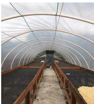
**Ilustración 13. Interior de un secador solar**
