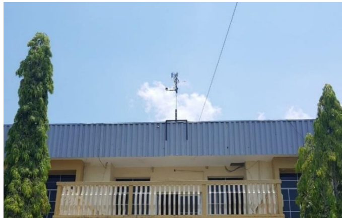
Ilustración 20: Estación meteorológica en el edificio de la Municipalidad de Puerto Cortés
