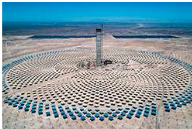
Ilustración 4. Proyecto Termosolar Cerro Dominador
