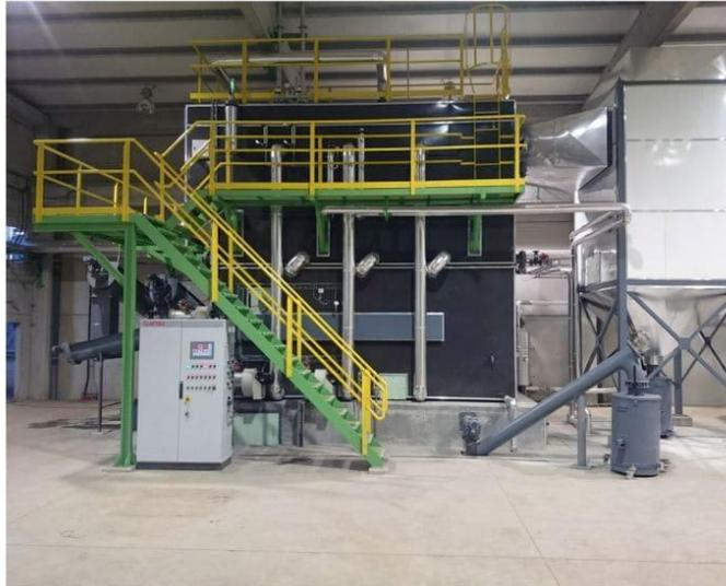
**Ilustración 33: Montaje de caldera ATTSU**
