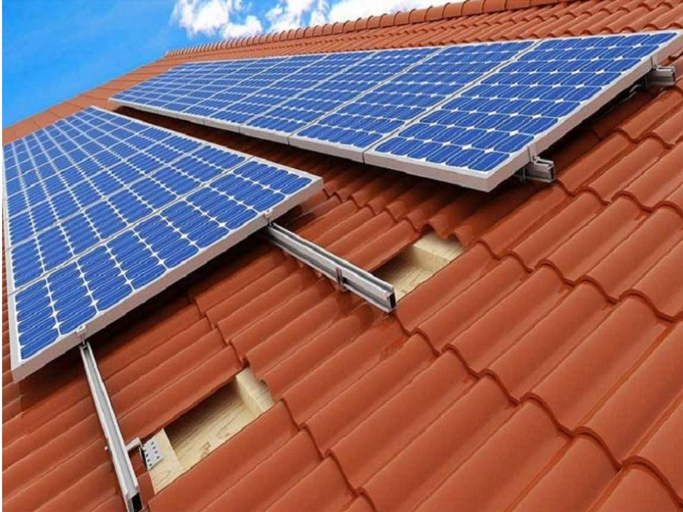
**Ilustración 9: Ejemplo de montaje empotrado**
