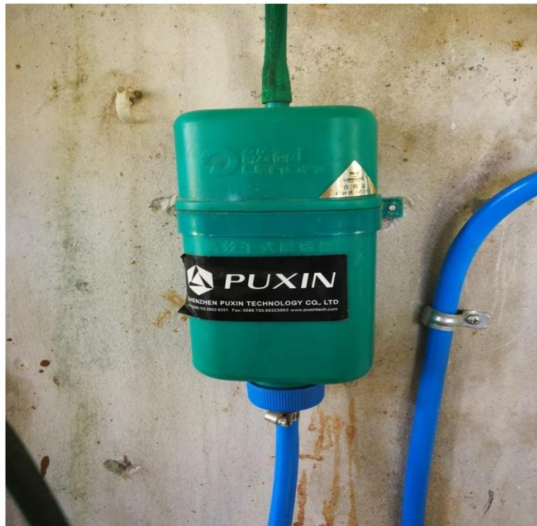
Ilustración 8: Filtro seco para el ácido sulfhídrico
