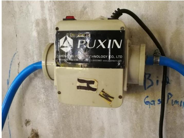
Ilustración 21: Bomba extractora
