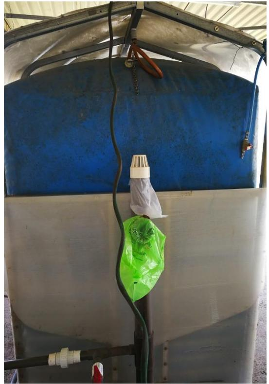
Ilustración 14: Biodigestor Utilizado modelo Puxin 1.2m<sup>3</sup>
