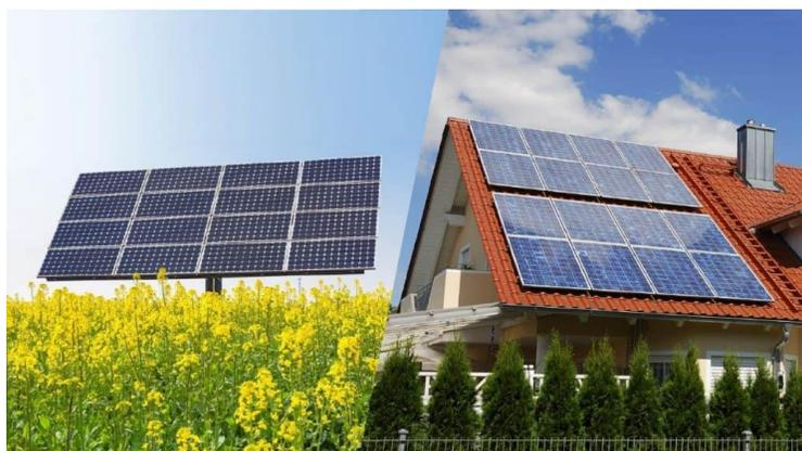
**Ilustración 2. Diferentes tipos de montajes de paneles fotovoltaicos; fixed tilted (izquierda), flush mounted (derecha).**
