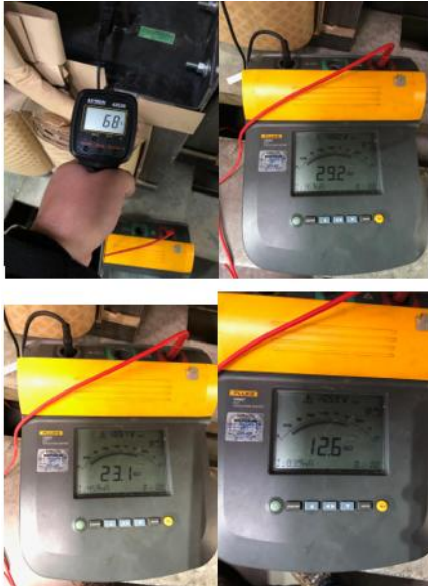
Ilustración 46: Prueba de Resistencia de Aislamiento 3542-1
