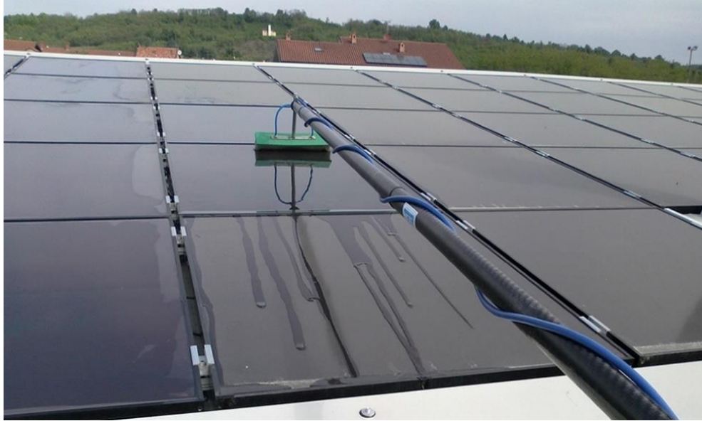
Ilustración 22: Limpieza de Colectores
