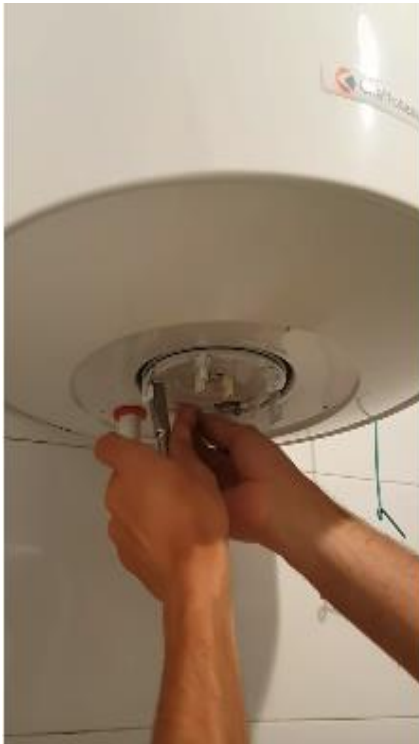
Ilustración 27: Procedimiento para el mantenimiento del ánodo de sacrificio
