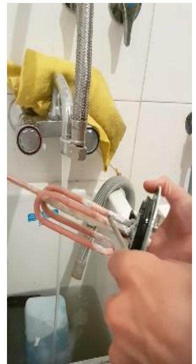
Ilustración 27: Procedimiento para el mantenimiento del ánodo de sacrificio
