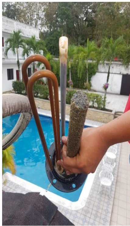
Ilustración 27: Procedimiento para el mantenimiento del ánodo de sacrificio
