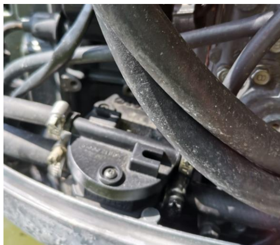
Ilustración 22: Filtro de gas fijado en Motor Marino Yamaha
