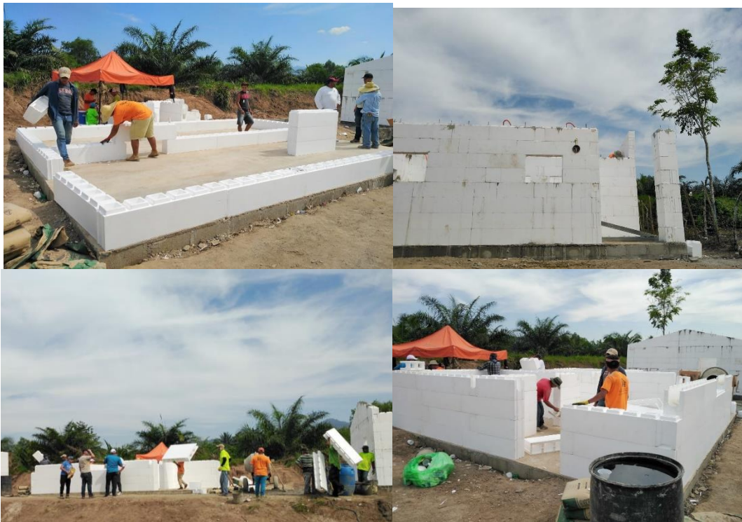
Ilustración 5.2 Desarrollo de viviendas sociales con bloque ICF en la Cuchilla Yoro.
