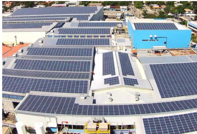
**Ilustración 6. Sistema fotovoltaico de autoconsumo en EMSULA.**
