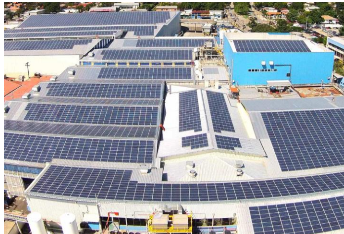
Ilustración 6. Sistema fotovoltaico de autoconsumo en EMSULA.
