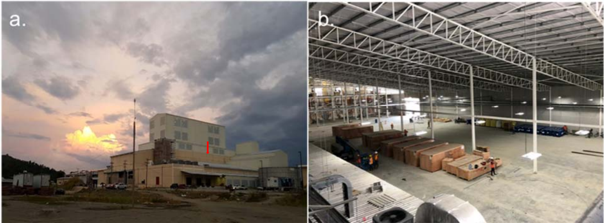
Ilustración 13. a. Vista frontal del edificio. b. Interior del Raw Chip Storage.
