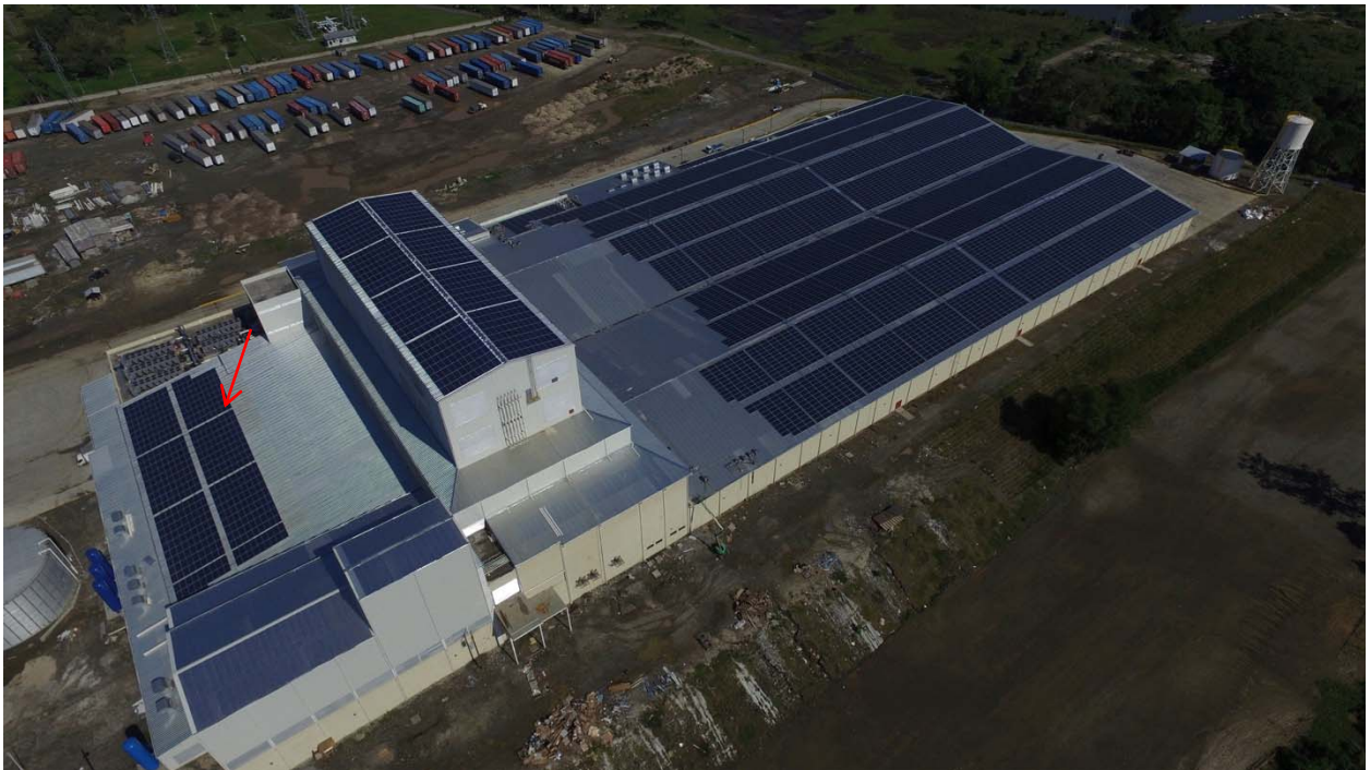
Ilustración 12. Vista aérea del edificio industrial.
