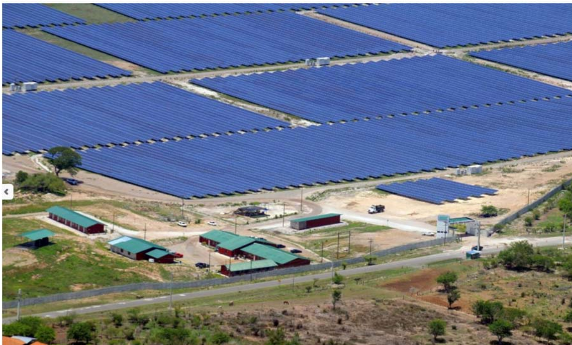
Ilustración 10. Planta solar fotovoltaica Cohessa ubicada en Nacaome, Valle.
