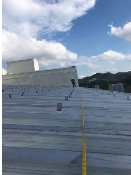
Ilustración 18. Medición de distancia para instalación de sensor de temperatura de techo exterior.
