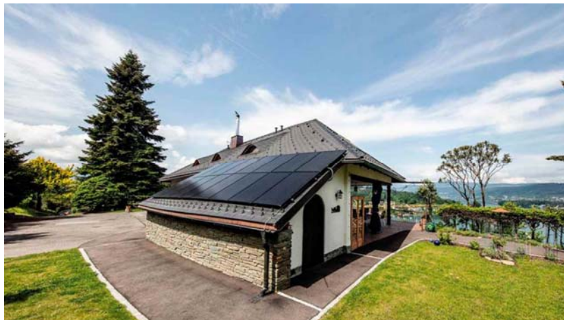
Ilustración 7. Instalación solar en Austria con módulos thin film.
