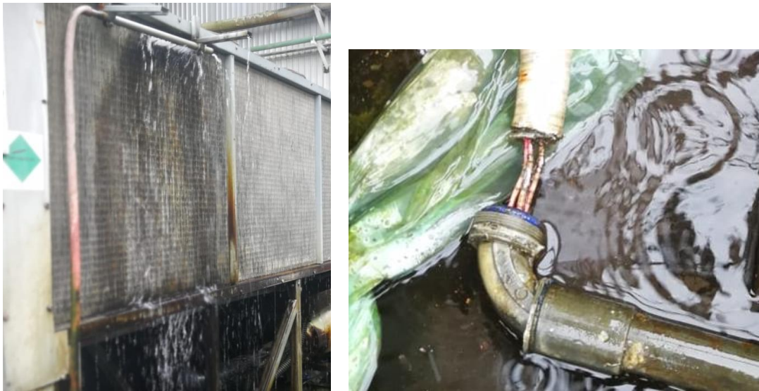
Ilustración 22. Sistema de enfriamiento implementado.
